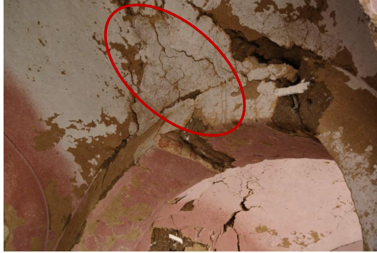
Resim 5.5: Kerpiç Parçalanma, El.Kurna - Luksor, Mısır, (Rasha ELBORGY)
