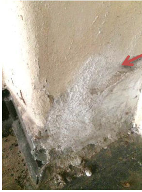
Resim 5.3: Kerpiç duvarındaki yeraltı suyu etkileri. (URL28)
