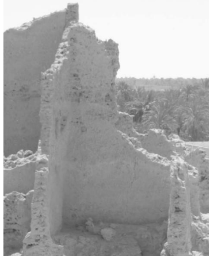
Resim 5.2: Kerpiç bir duvarda rüzgar etkisi, Siwa, Mısır (Rasha ELBORGY)
