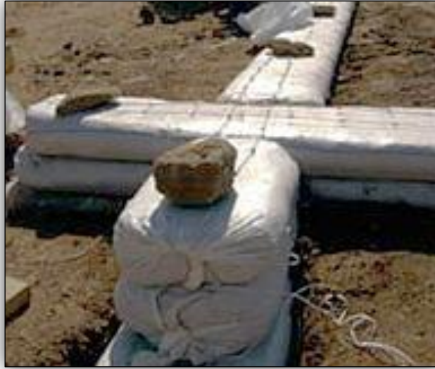
Resim 2.4: İçi toprakla dolu torbalarla yapılmış olan iki duvarın kesiştiği nokta. Tellerle birbirine iyice bağlanıp kenetlenmiş torbalar. (Owen Griger, 2011)
