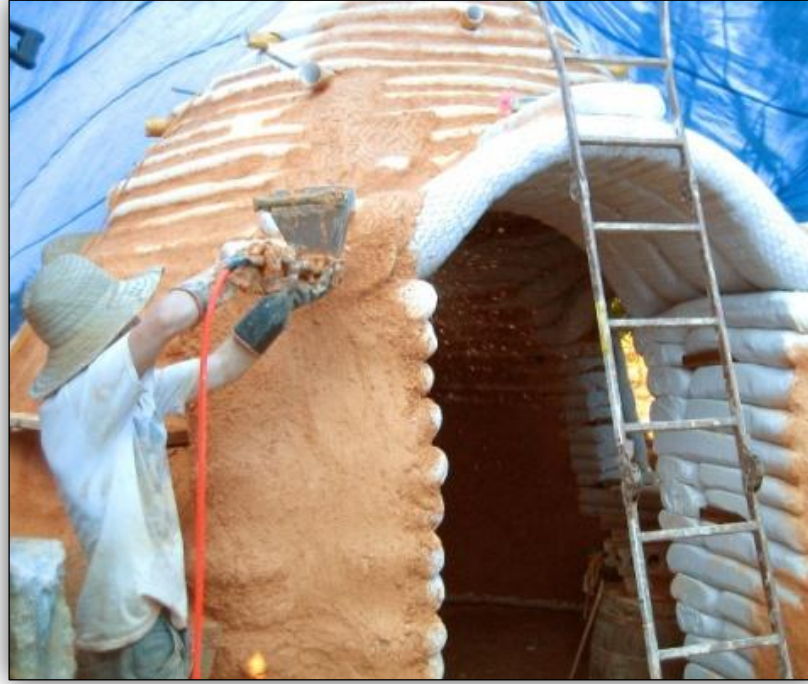
Resim 2.5: İçi toprak dolu torbalarla yapılmış olan duvarın iç ve dış cephesinin çamurla sıvanıp son şeklin verilmesi işlemi. (Owen Griger, 2011)
