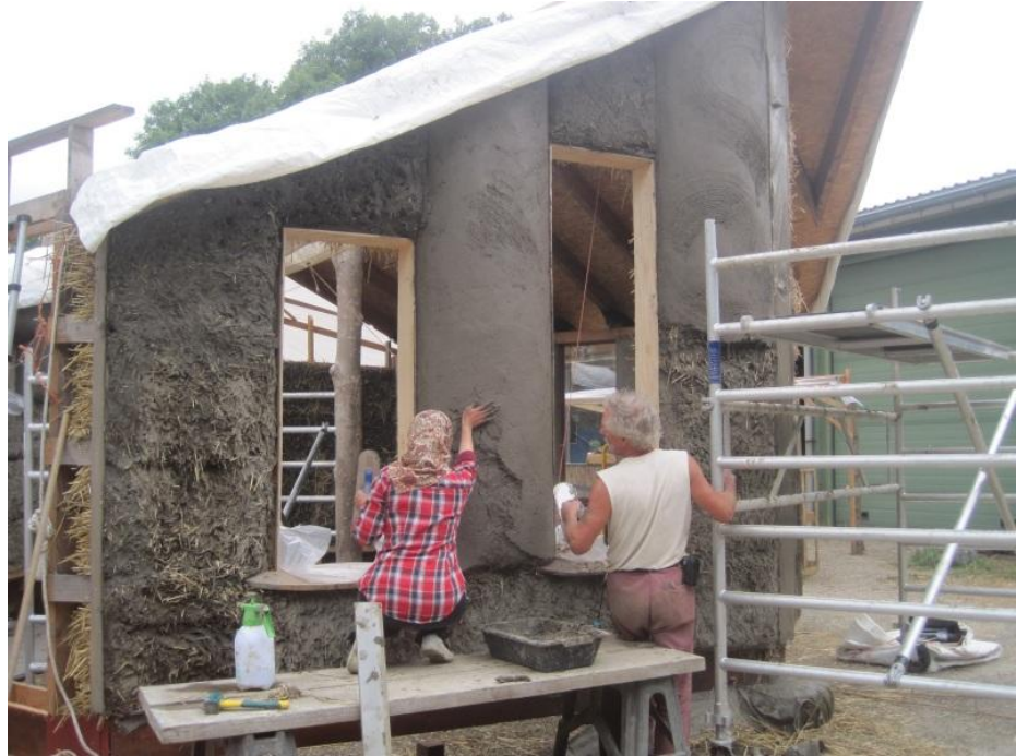
Resim 2.7: İç ve dış cephenin çamurla sıvanması, IFAC workshop, Hollanda (Rasha ELBORGY, 2015)
