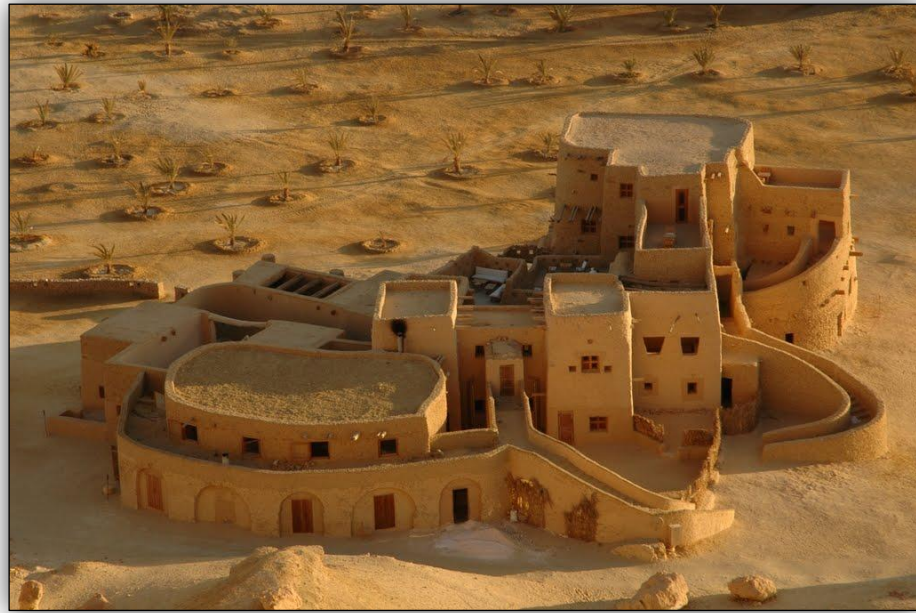
Resim 4.6: Adrere amellal Oteli, Siwa vahası, Mısır. (URL21)
