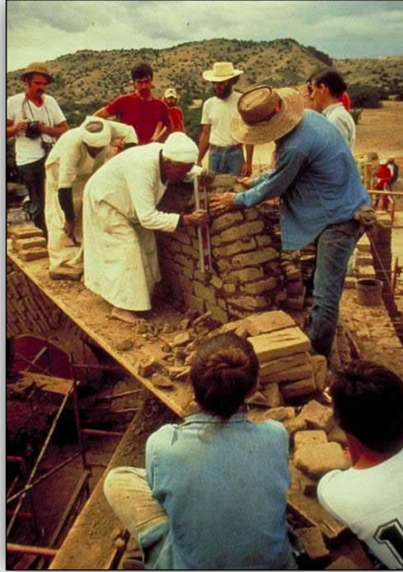
Resim 4.8: Mexico şehri “Dâru’l-İslâm” Projesi. Kubbe yapımı. Amerika Birleşik Devletleri1981. (URL22)
