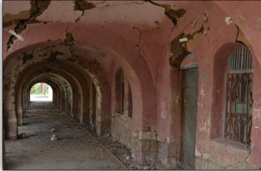
Resim 4.13: Pazar binasının şimdiki durumunu gösteren koridorun iç perspektifi. Yeni Gurna Köyü, Luksor, Mısır. (Rasha ELBORGY, 2016)
