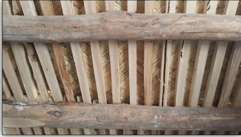
Resim 3.11: Ahşap yatay çatının alttan görünüşü. (URL16)
