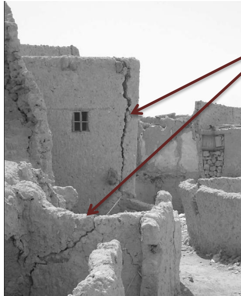
Resim 5.6: Kerpiç duvardaki çatlaklar, Siwa, Mısır, (Rasha ELBORGY)
