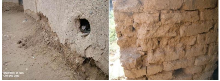
Resim 5.3: Kerpiç duvarındaki yeraltı suyu etkileri. (URL28)
