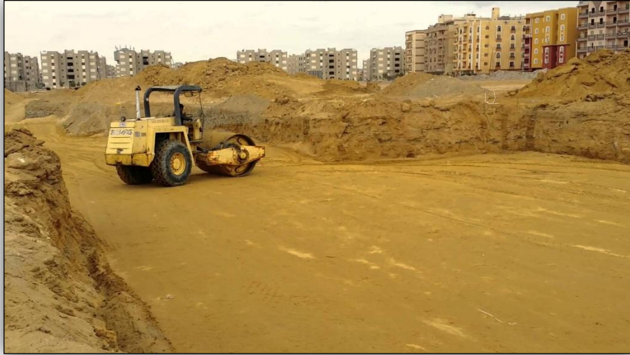
Resim 3.8: Bina yapımına başlamadan önce zemin preslenme işlemini gösteren fotoğraf. (URL13)
