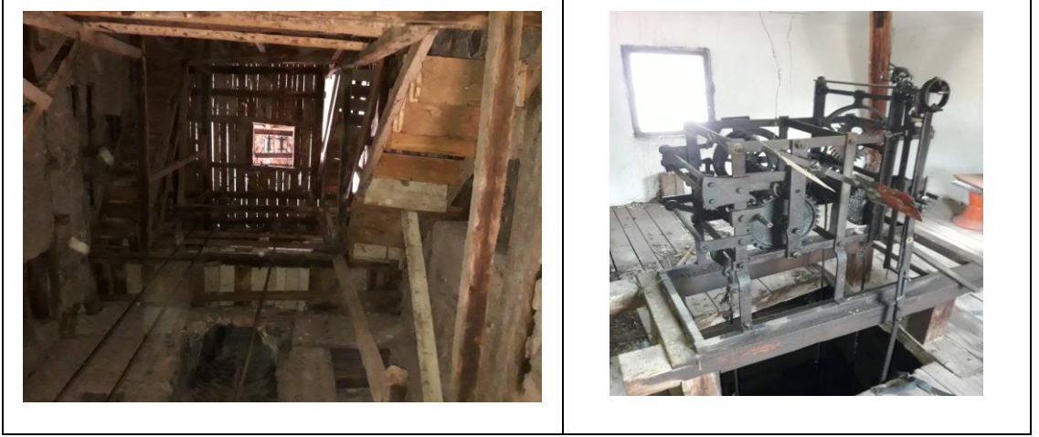
Şekil 2.61, İştîp Saat Kulesi iç kısmı (2019)
