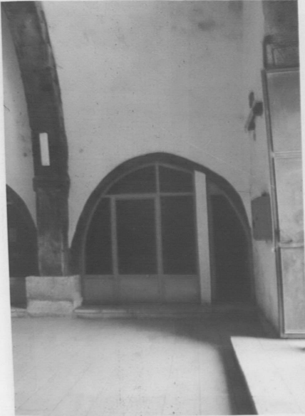
15. Kadınhanı-onarım sonrası çatı merdivenin önü, 1989 (A.T.Yavuz saydam arşivi.)
