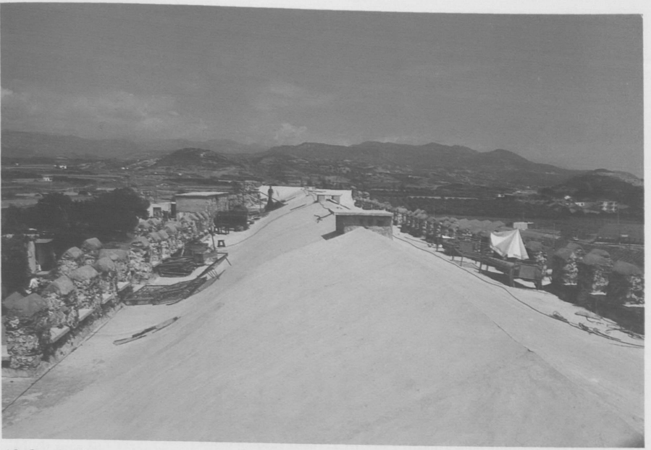
10. Şarafsa Han-onarımdan sonra çatı,1990 (A.T.Yavuz saydam arşivi.)
