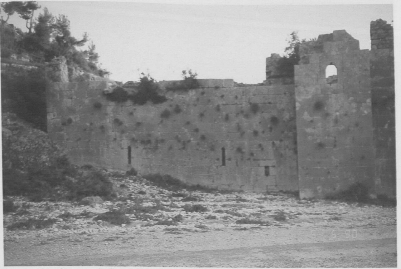
20. Alara Han-kuzey cephede merdivenli kule,1990 (A.T.Yavuz saydam arşivi.)
