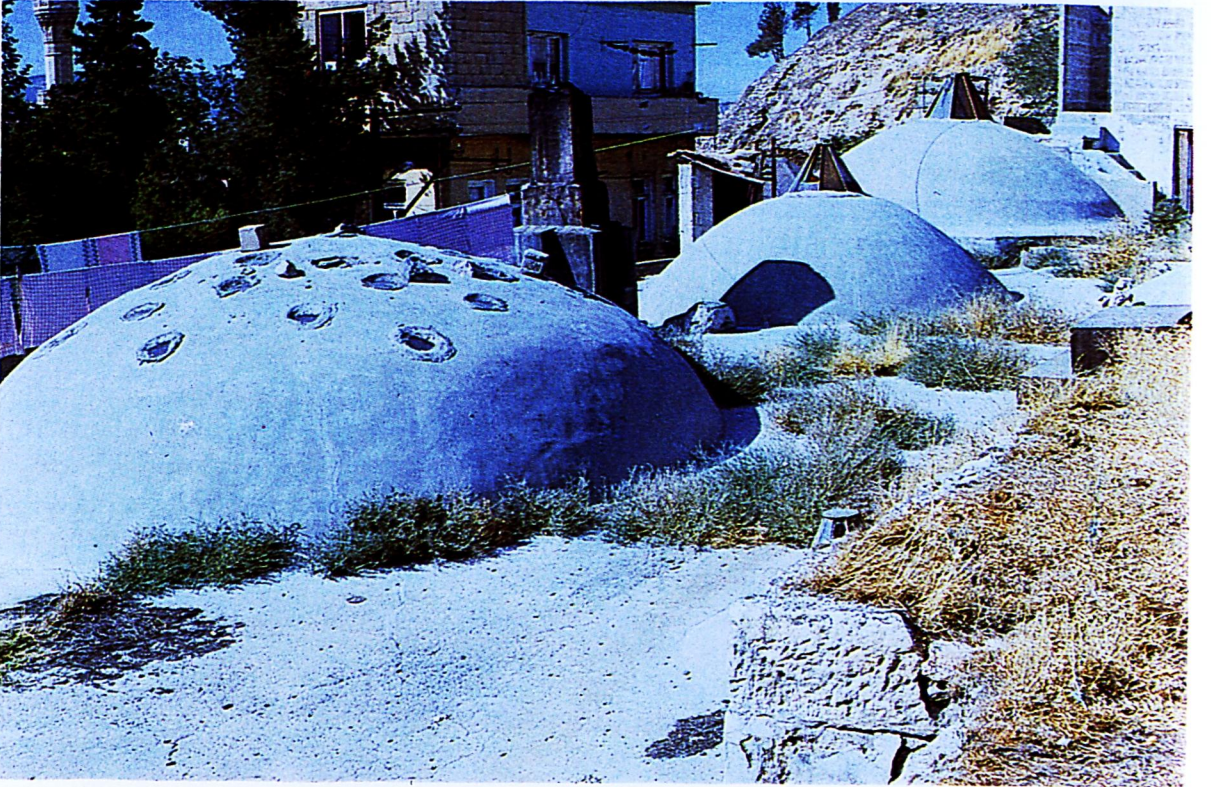
Res. 22: Hamam, örtü sistemleri.
