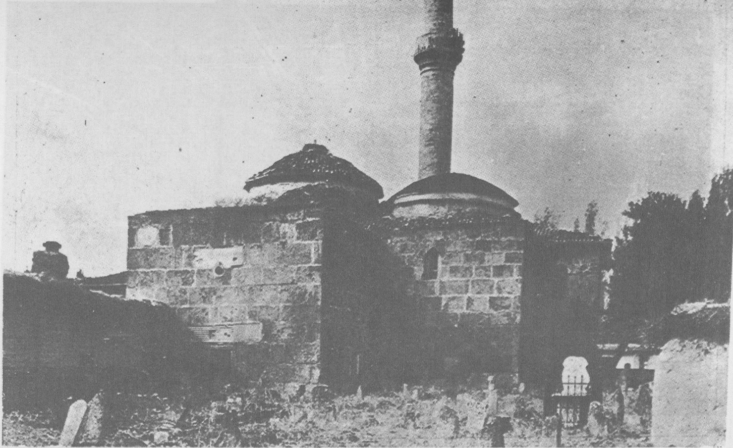
17 — Ahi Evran camiinin arka cephesi
