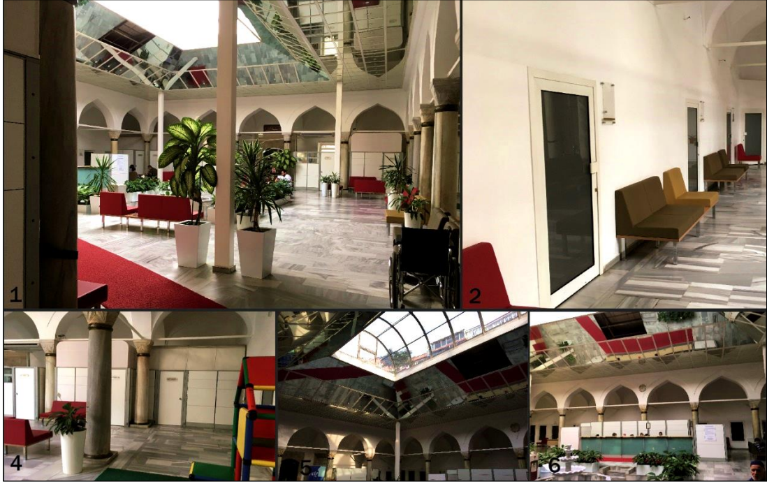
Şekil 6.7: Mihrimah Sultan Medresesi'nin mevcut durumu: 1.Kuzeybatı girişinden avlunun genel görünüşü, 2.Talebe odası kapıları, 3.Müşahade odası olarak kullanılan revaklar, 4.Camekan ve aynadan oluşan muhdes avlu örtüsü, 5.Karşılama bankosu (Faik Gönül, 2018)
