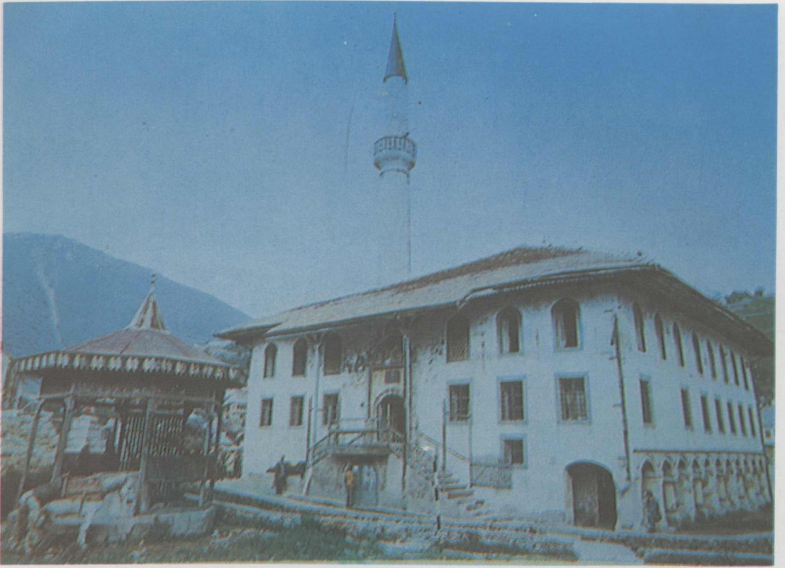
10. Travnik-Süleyman Paşa Camii(1757)
