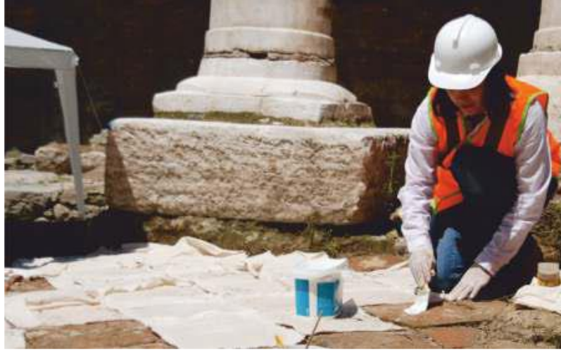
Resim 4. 32- Yapı kalıntılarının tabanındaki tuğla yer döşemelerinin sökülmesi (Somun İnşaat, 2012)
