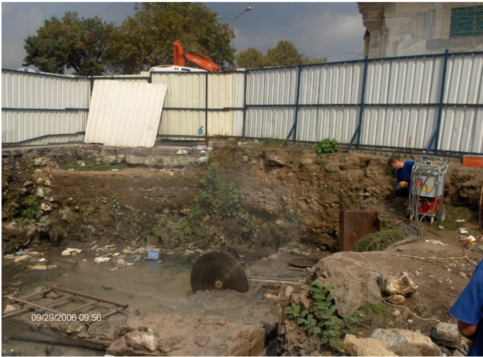
Resim 3. 7- Marmaray Üsküdar şantiyesi disk kesme makinası ile yapı kalıntısını keserek parçalara ayırma, (Somun İnşaat,2006)
