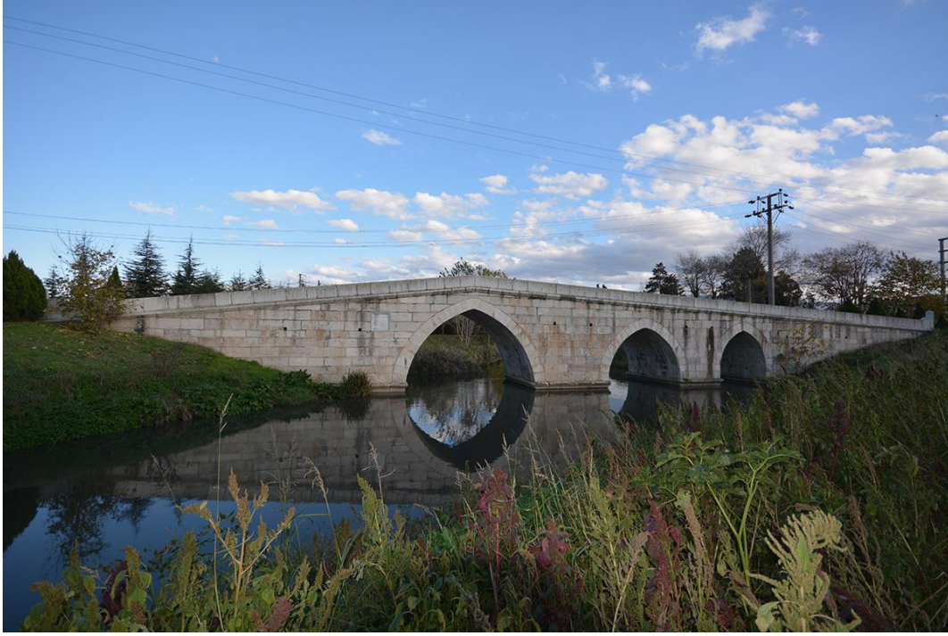
Resim 3. 29- Kilezdere Köprüsü, Başiskele, 2002, taşıma ve restorasyon sonrası ( http://www.avundukmimarlik.com.tr )
