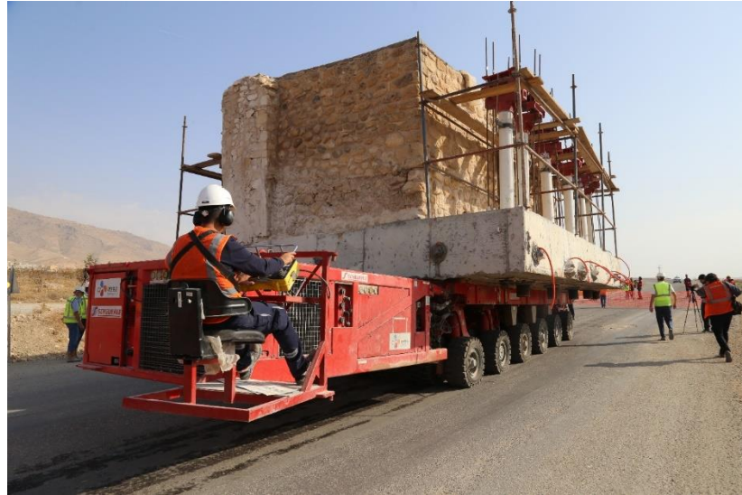
Resim 3. 15- İmam Abdullah Zaviyesi, SPMT aracı ile bütüncül taşıma yapılması, Hasankeyf,2018 ( http://www.aa.com.tr )
