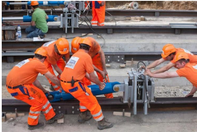
Resim 3. 12 - Tarihi Oerlikon Binası Taşıma, yapının pistonlar yardımıyla çelik raylarda itilmesi,2012 ( http://www.maschinenmarkt.ch )
