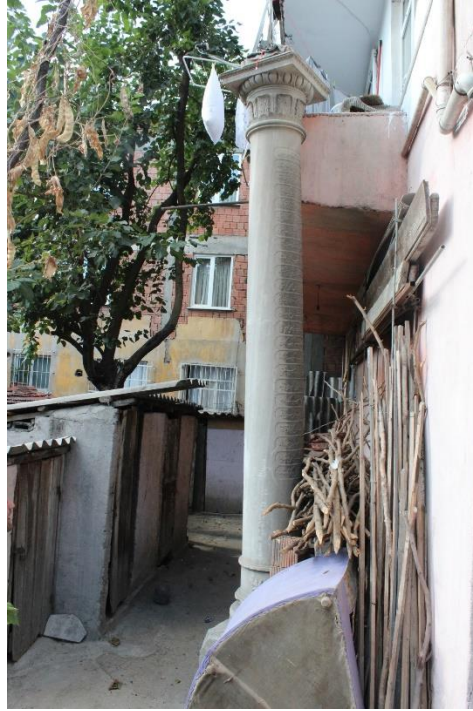
Resim 4. 41- Taşıma öncesi, Beyoğlu İlçesi, Keçecipiri Mahallesi 3149 Ada 9 parselde yer alan Sultan Mahmut Abidesi (R:17), (İBB Arşivi,2018)
