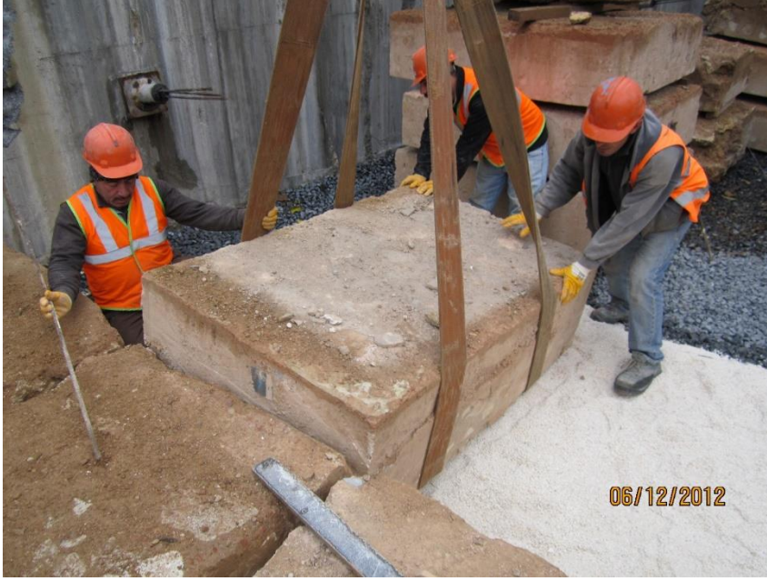
Resim 3. 8- Marmaray projesi Sirkeci istasyonu Roma dönemi sarnıç duvar kalıntısı blokların taşıma sonrası zemine yerleştirilmesi, (Somun İnşaat,2012)
