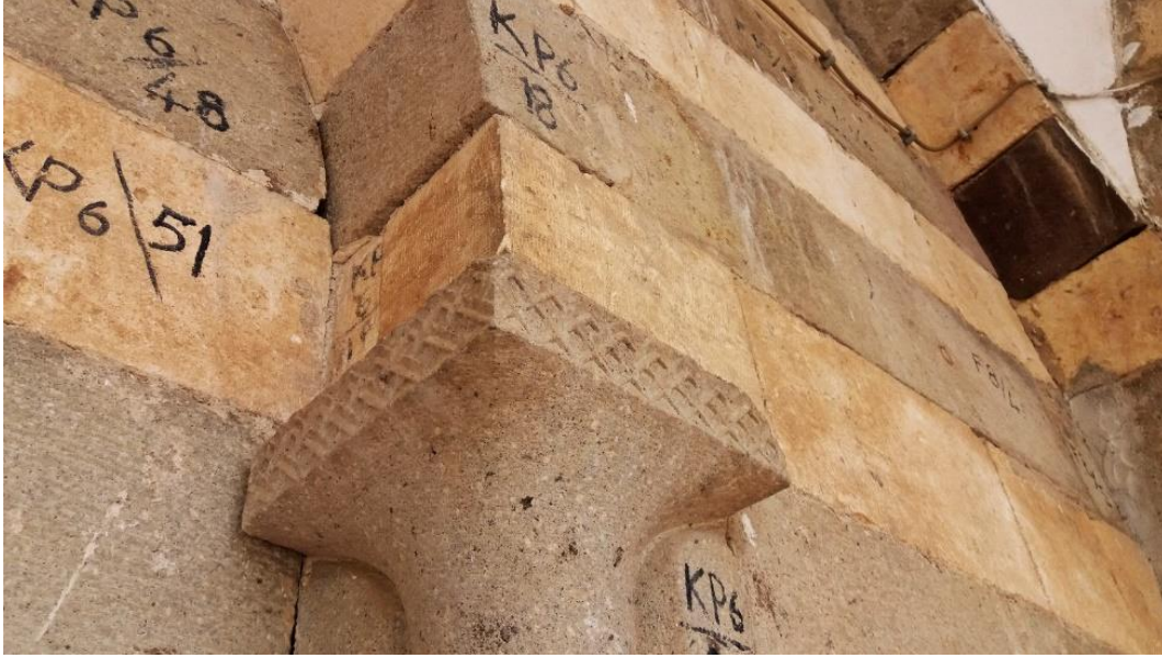
Resim 3. 2- Numaralandırılarak sökümü yapılan ve yeni yerinde montajı yapılan duvar kaplamaları, Tunceli ili Pertek ilçesi Sungur Bey camii, ( http://www.tuncelikulturturizm.gov.tr )
