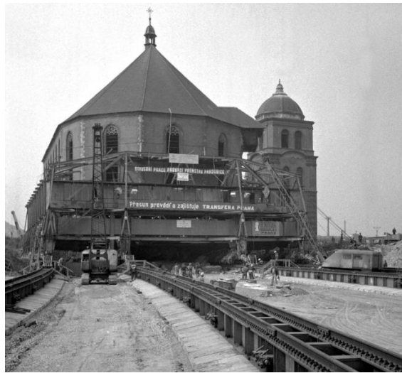
Resim 3. 28- Meryem Ana Kilisesi raylar üzerinde taşıma,1974, Most, Çekya ( http://www.atlasobscura.com )
