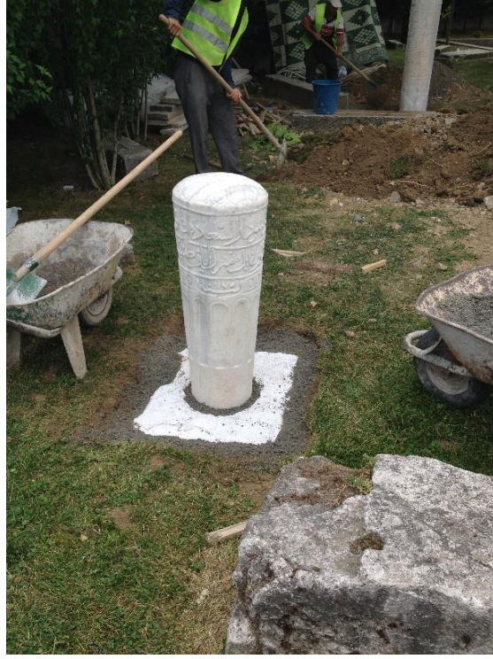
Resim 4. 45- Taşıma sonrası Okçular Tekkesi'nde yeni yerine yerleştirilen Beşir Ağa Ayak Taşı, (İBB Arşivi,2018)
