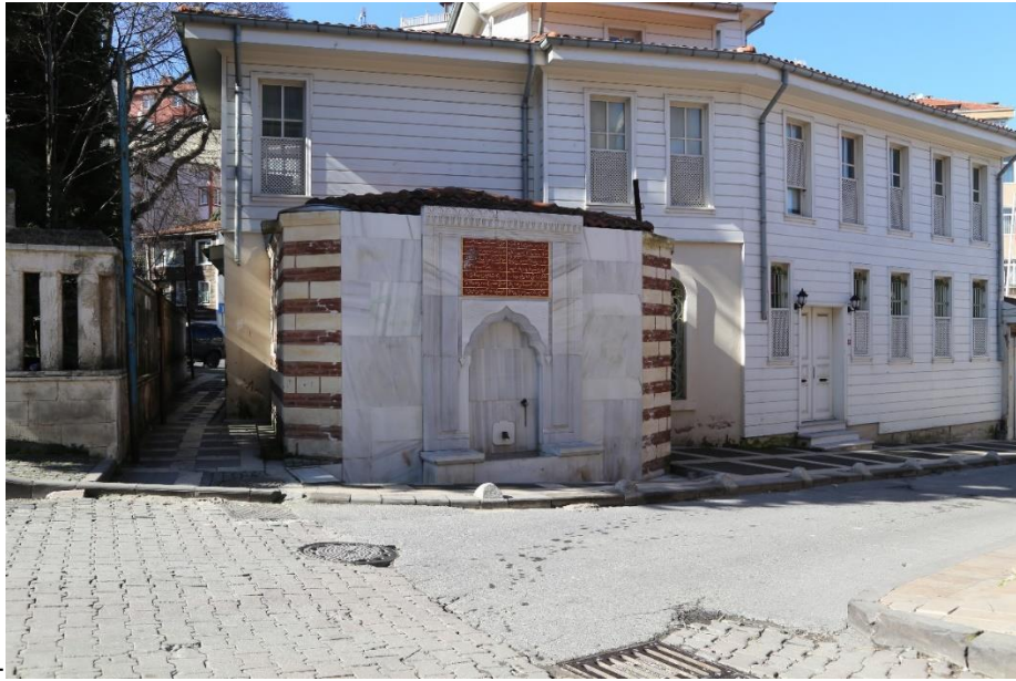
Resim 4. 15- İskender Baba Tekkesi restorasyon çalışmaları kapsamında replikası yapılan Damat İbrahim Paşa Çeşmesi, Üsküdar (Kendir, 2019)
