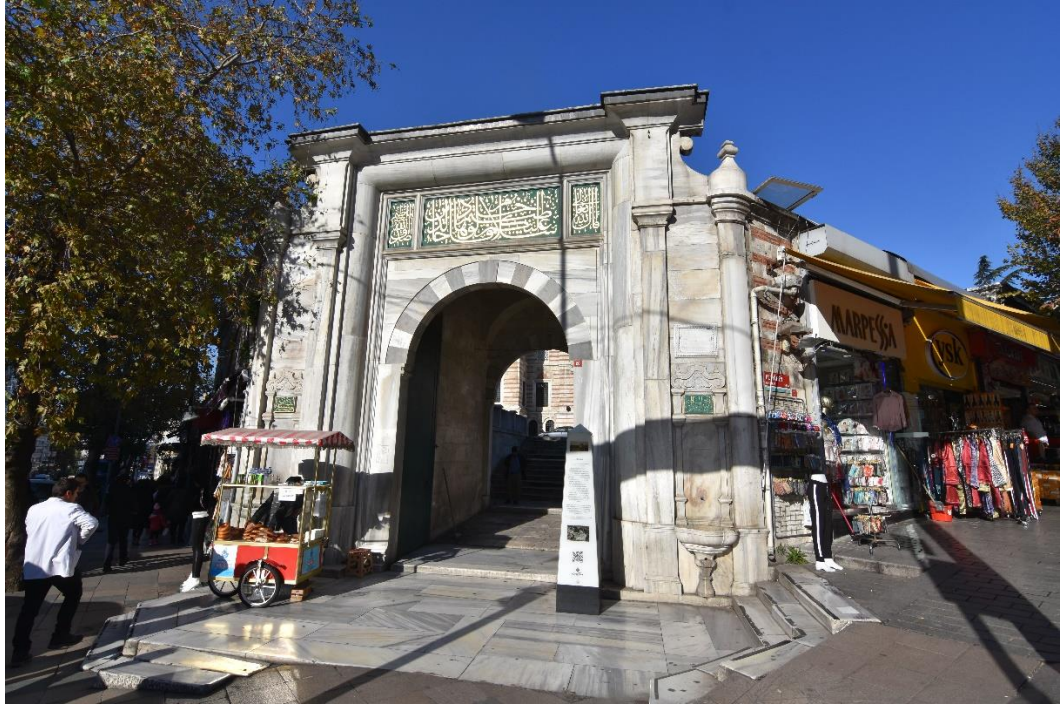
Resim 4. 81- Günümüzde, Laleli Camii Cümle Kapısı ve Sed Duvarı (Kendir, 2019)
