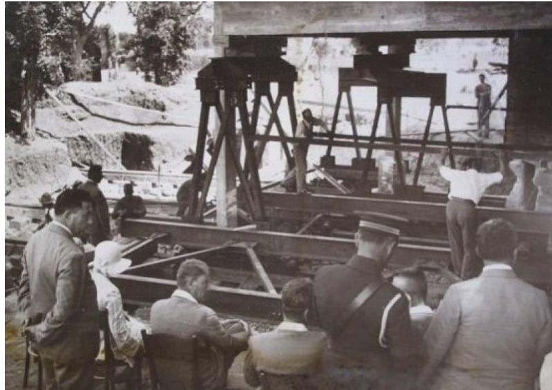
Resim 3. 20- Atatürk Köşkü taşınırken kurulan raylı sistem ( http://www.ensonhaber.com )
