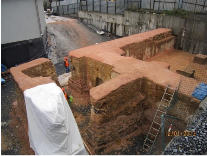
Resim 4. 31- Taşıma sonrası, kilise kalıntısı (Somun İnşaat, 2012)
