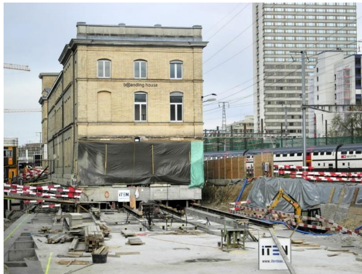
Resim 3. 31- Tarihi Oerlikon Binası, çelik raylarda taşıma, Zürih, 2012, ( http://upload.wikimedia.org )
