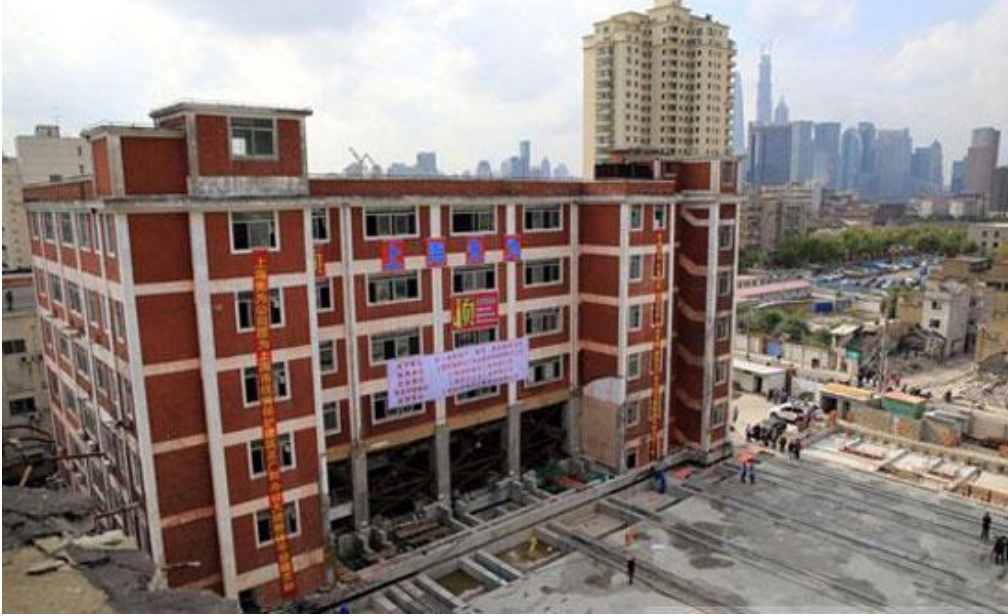
Resim 3. 32- Zhengguanghe Binası, beton raylarda taşınması, Şangay,2013, ( http://www.china.org.cn )
