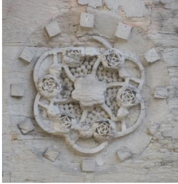
R. 166 Şeyh Zafir Türbesi Dış Cephesinde Rozet
