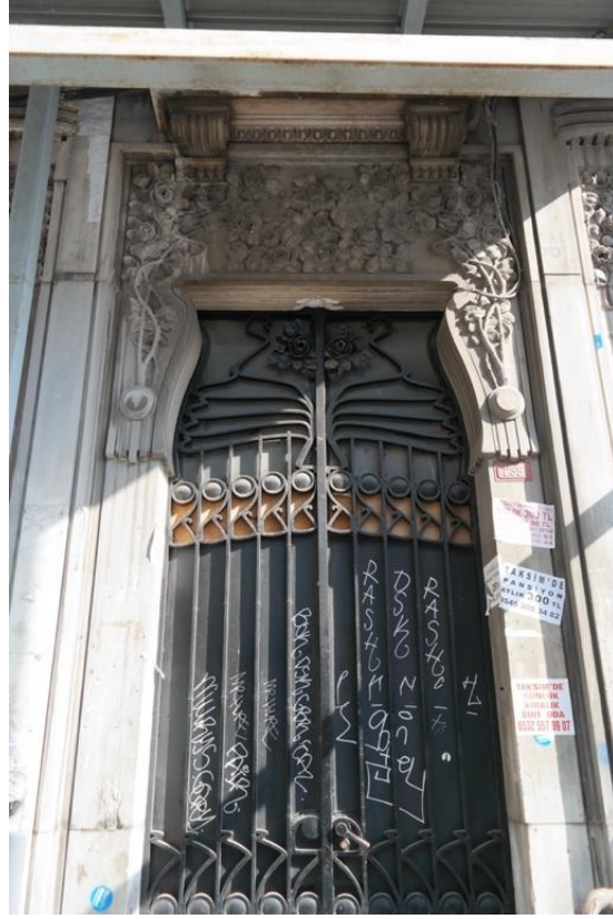
R. 146 Botter Apartmanı Griş Kapısı, Çift Kanatlı Kapı
