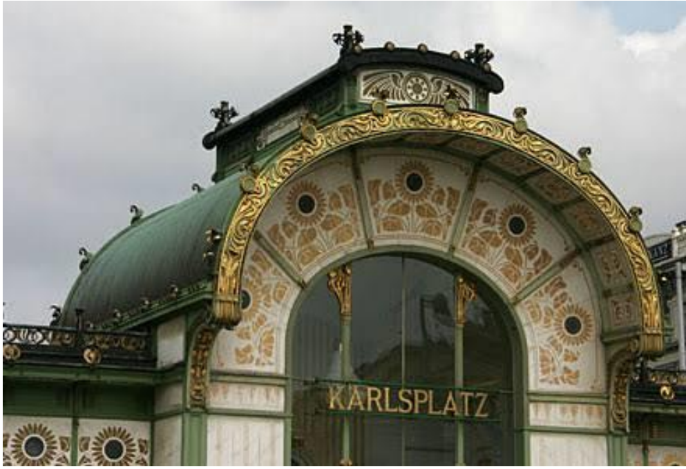
R. 115 Karlsplatz Kapısı, Viyana
