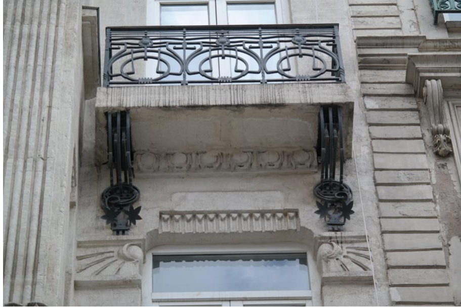
R. 180 İstiklal Caddesi No: 201. Apartman Dış Cephe
