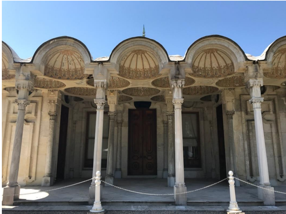
R. 134 Beylerbeyi Sarayı Deniz Köşkü'nün Giriş Kapısı
