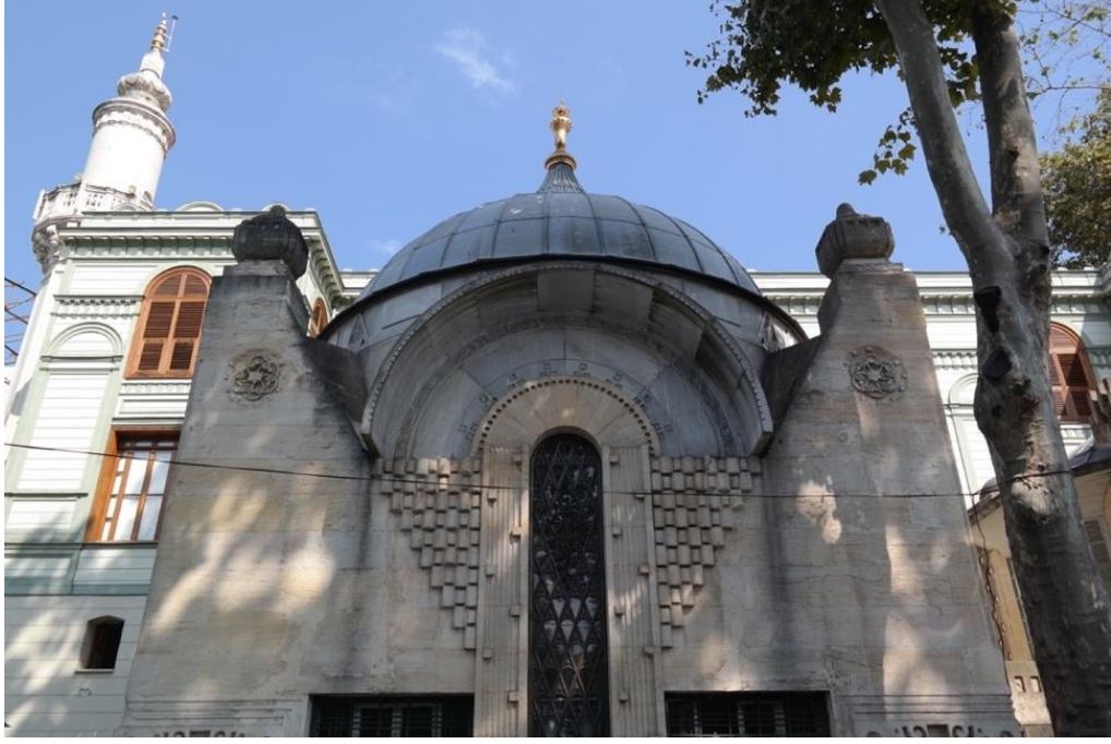
R. 106 Şeyh Zafır Türbesi
