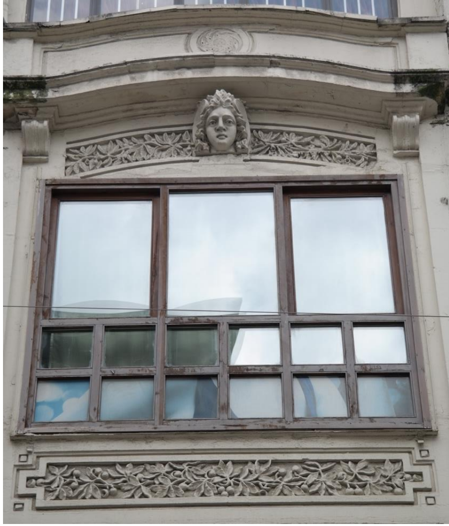
R. 182 İstiklal Caddesi No: 411, Beyoğlu, Moda Evi Binasının Dış Cephesi
