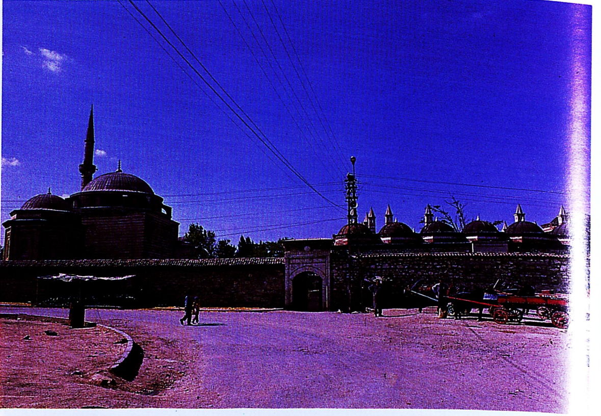
Lev. 13: Külliye, güneyden genel görünüm (1984).
