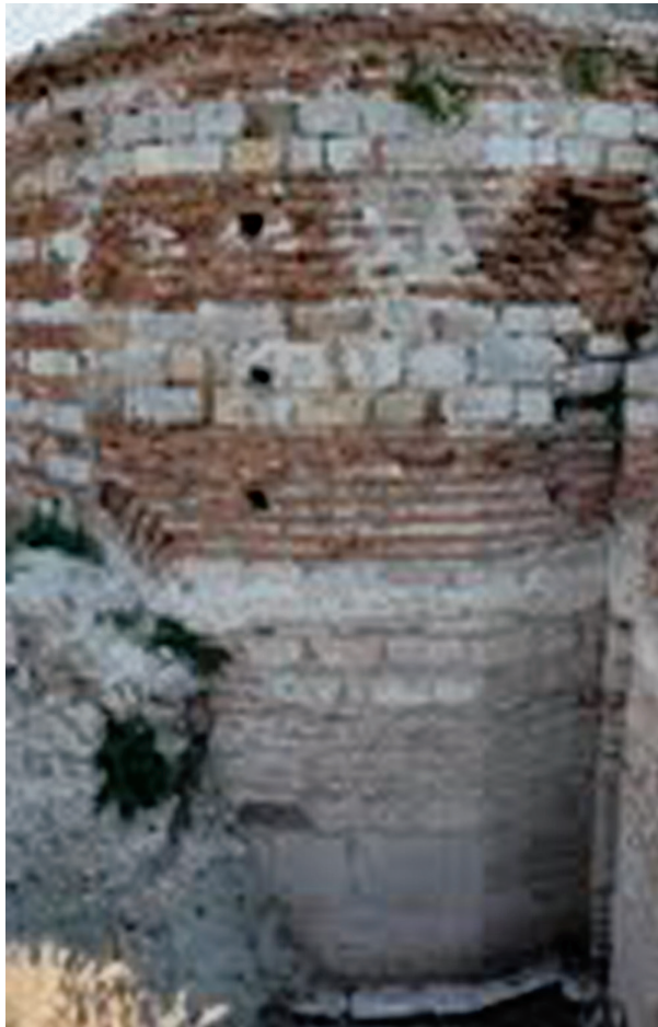
Fotoğraf 13: Apsislerin dışı köşeli duvar sistemini gösteriyor. Apsis duvarları temel seviyesinde dışa taşkın mermer silme üzerine oturtulmuştur.
