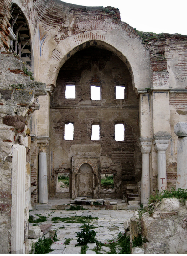
Fotoğraf 7: Camiye giriş kapısı, güney nefi ilave edilen mihrap, orta nefte kubbe-yi taşıyan paye ve sütunlar.
