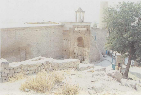
Res. 31: Develi Ulu Camii, kuzeyden görünüm (1991)
