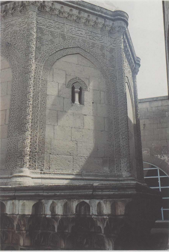
Res. 7: Kayseri Huand Hatun Türbesi, güney-batı cephe (1991)
