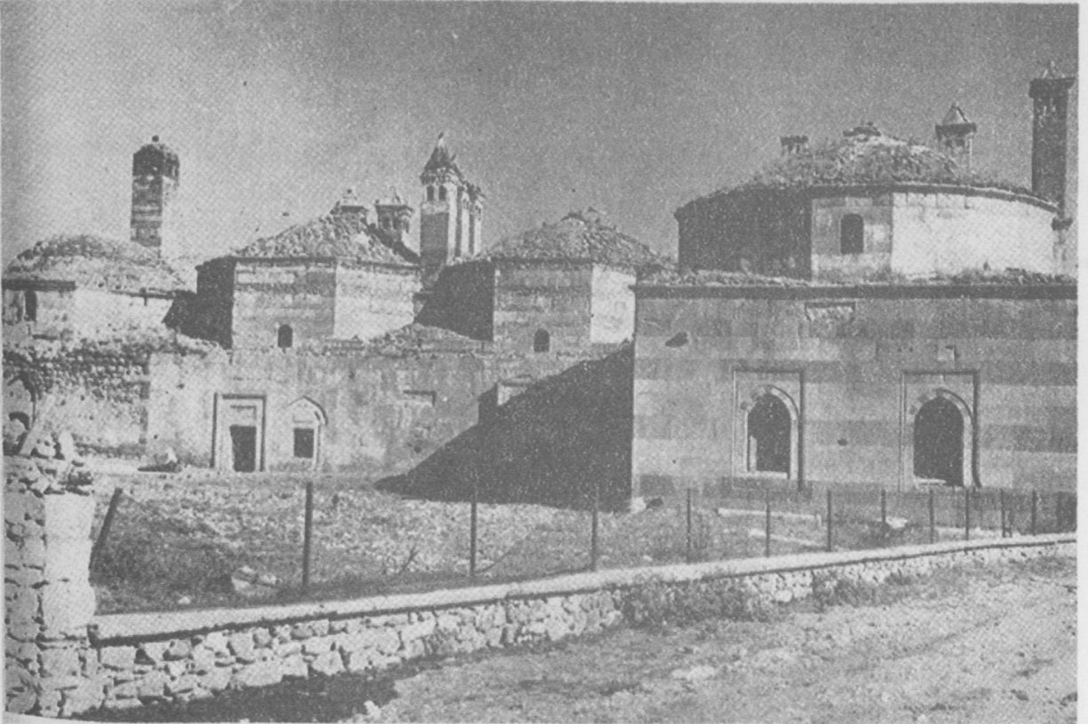
Resim: 6 — Şeyh Sücaeddin İmareti, güney cephesi (Ö. Bakırer)
