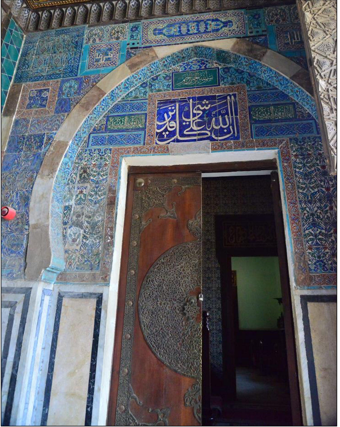
Resim 18: İstikbal Salonu Dış Giriş Kapısı Görünümü
