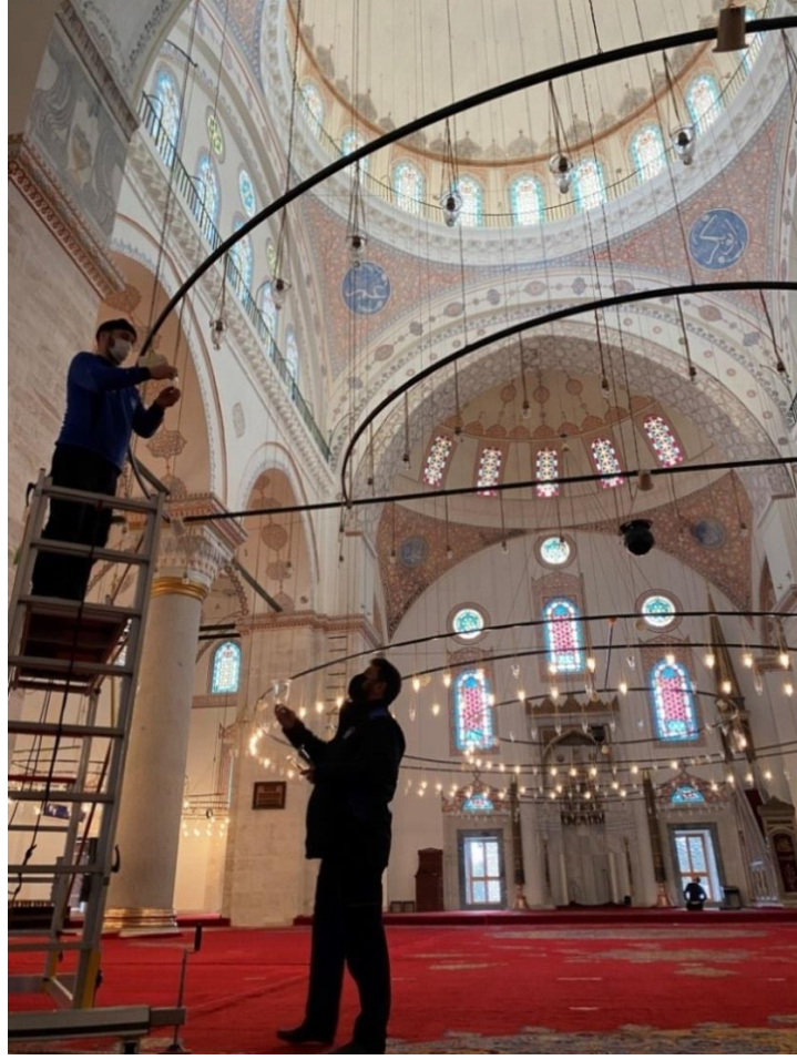
Resim 78. Beyazıt Camii Yapay Aydınlatma Elemanlarının Rutin Bakım ve Onarımının Yapılışının İzinli Şekilde Alınmış Görüntüsü (Ocak 2021) 146 .
