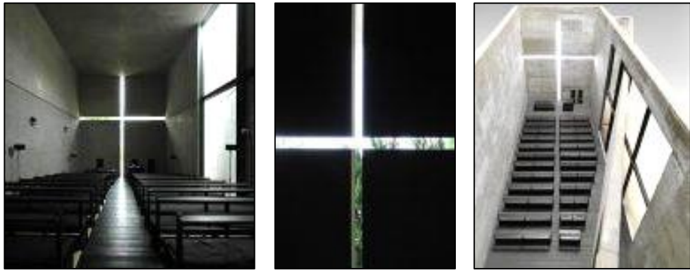
Resim 66. Haç Şeklindeki Duvar Boşluğundan Günışığını İç Mekana Alarak Dini Sembole Vurgu Yapan Tadao Ando'nun Minimalist Tasarımı; Işık Kilisesi 118 .
