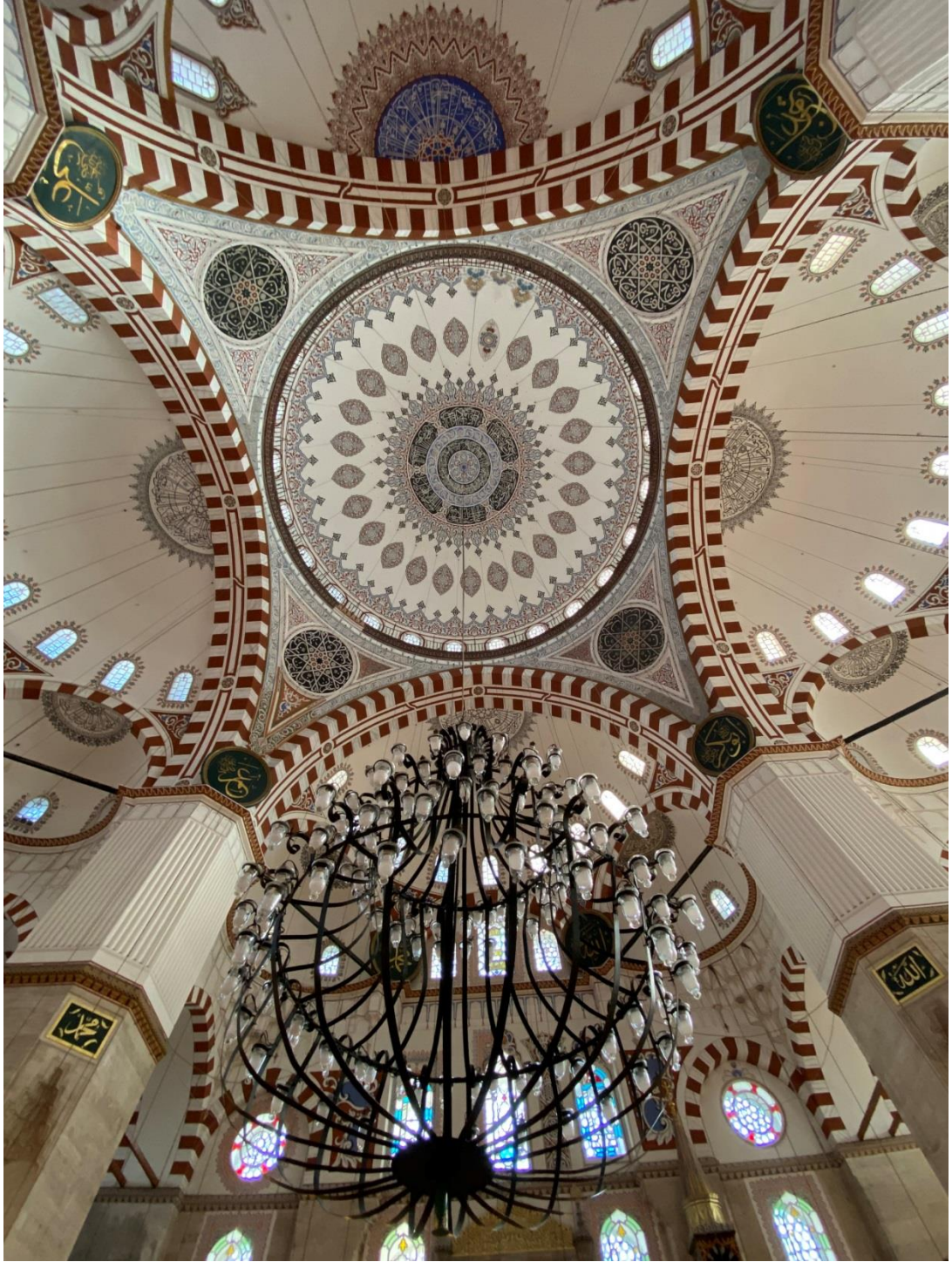
Resim 136. Şehzadebaşı Camii Dört Yarım Kubbe İle Desteklenen Merkezi Kubbenin Zeminden Görünüşü (Ocak 2021) 220 .
