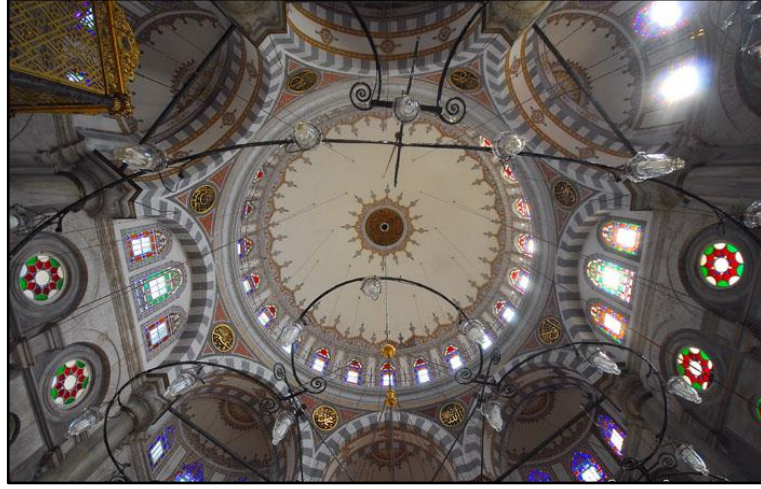
Resim 29. İstanbul Laleli Cami Kubbesinin İç Mekandan Görünüşü 59 .
