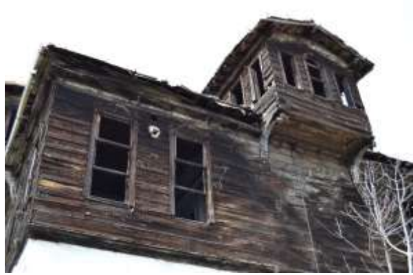
Şekil 2.98: Ahşap söveli pencereler
