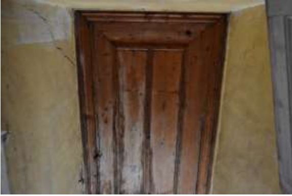
Şekil 2.54: Z04 wc ahşap tavan kaplaması
