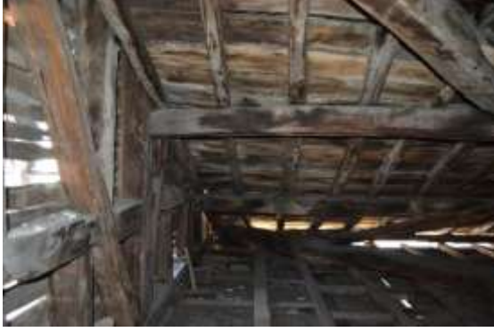
Şekil 2.66: Çatı arası ahşap kuşaklama
