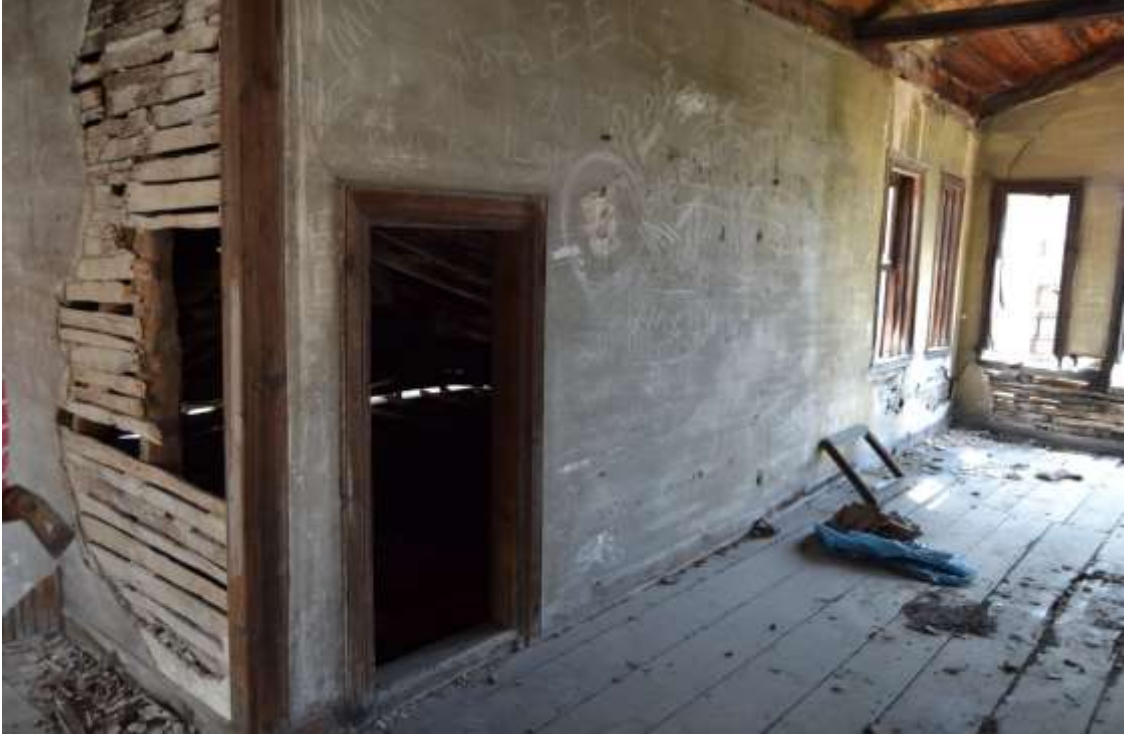
Şekil 2.80: K10 poz numaralı kapı boşluğu
