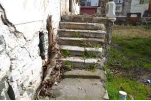
Şekil 2.48: Beton müdahaleli merdiven
