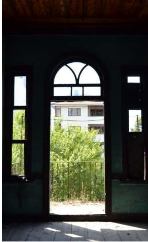
Şekil 2.79: K9 poz numaralı kapı boşluğu
