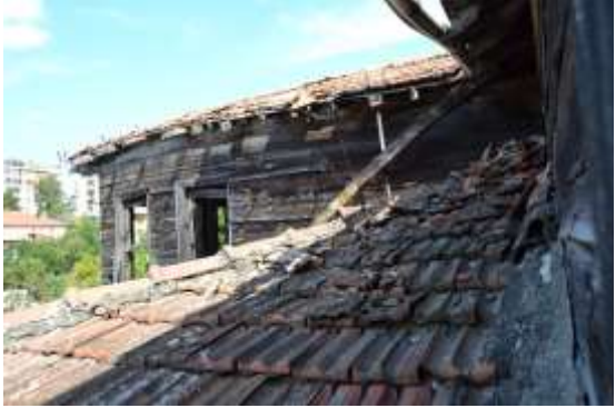
Şekil 2.68: Çatı katı pencereden görünüm
