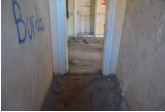
Şekil 2.62: Beton ile müdahale edilmiş döşeme
