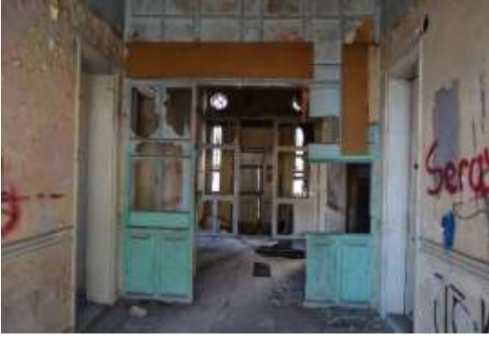
Şekil 2.74: K4 poz numaralı kapı boşluğu
