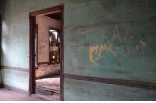
Şekil 2.76: K6 poz numaralı kapı boşluğu
