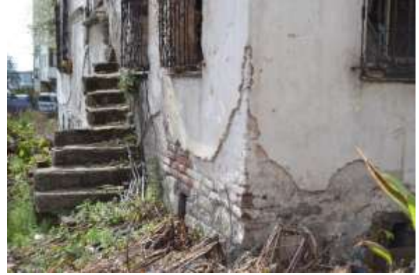
Şekil 2.51: Güneydoğu giriş merdiveni (ön)
