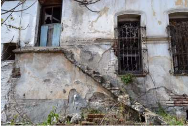
Şekil 3. 2: Güneydoğu cephesindeki betonarme merdiven
