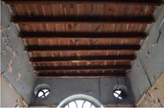
Şekil 2.52: Z01 holde ahşap kirişler
