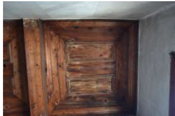
Şekil 2.57: 104 wc ahşap tavan kaplaması
