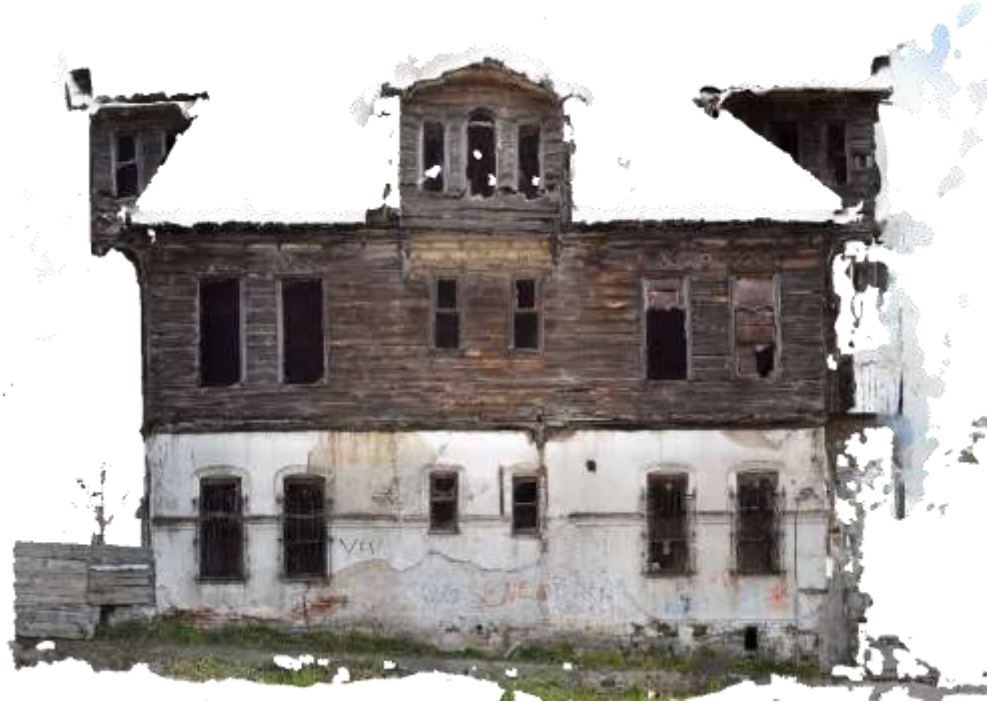
Şekil 2.38: Kuzeybatı cephesi (ortofoto tekniği ile oluşturulmuştur.)
