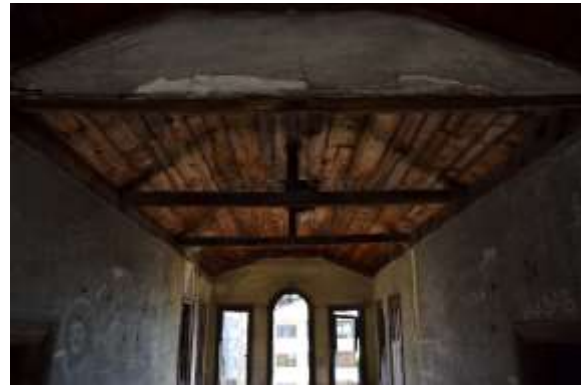
Şekil 2.59: Çatı katı ahşap tavan kaplaması
