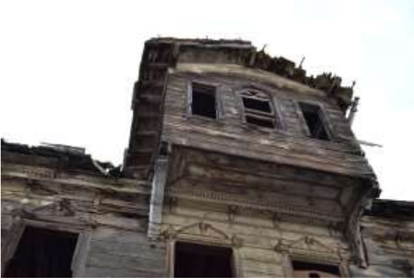
Şekil 2.97: Çıkma altındaki ahşap payandalar
