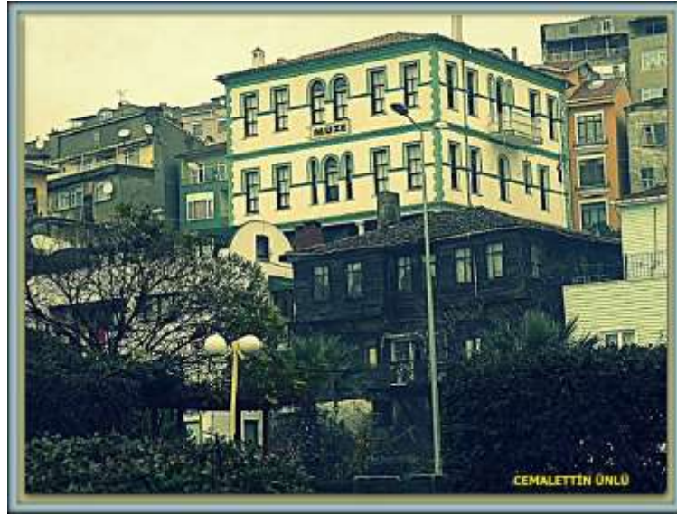
Şekil 1. 15 Halil Paşa Konağı ön cephe, Müze. (Cemalettin Ünlü arşivi)
