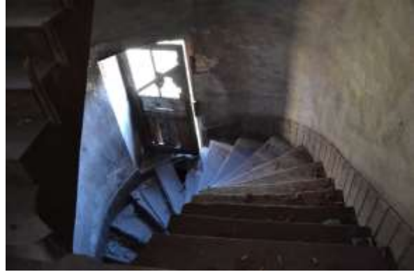
Şekil 2.43: Merdivenden alt kata bakış
