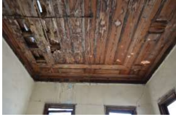
Şekil 2.53: Z02 oda ahşap tavan kaplaması
