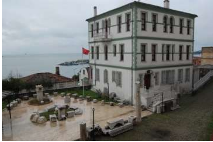
Şekil 1. 14: Halil Paşa Konağı arka cephe, Müze.
