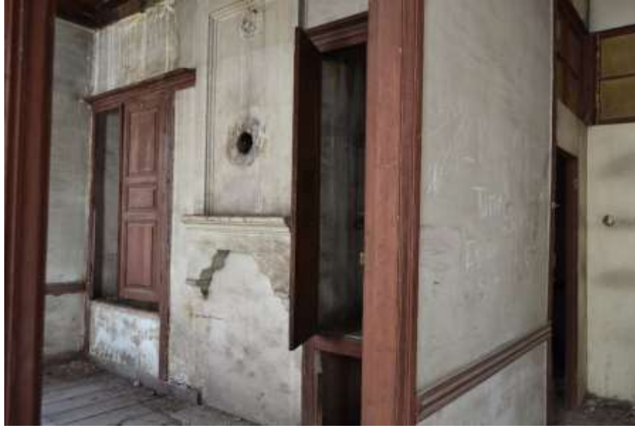
Şekil 2.102: 107 odada bulunan DP2 poz numaralı dolap
