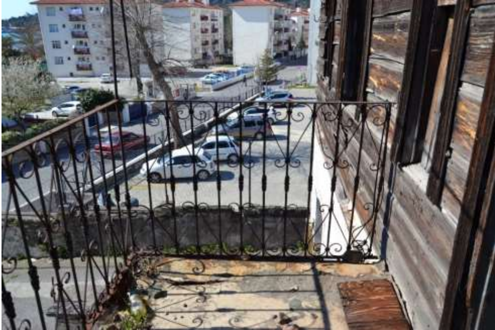
Şekil 2.33: Balkonda bulunan demir korkuluk
