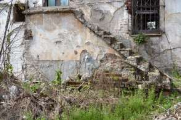
Şekil 2.50: Güneydoğu giriş merdiveni (yan)
