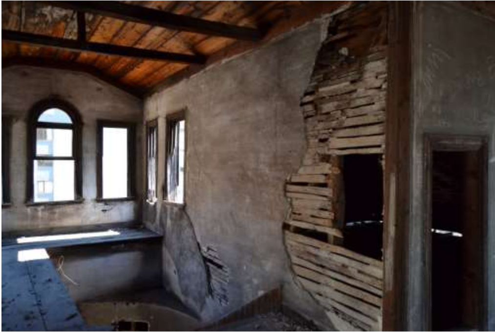
Şekil 2.35: Çatı katında bulunan merdiven kısmı
