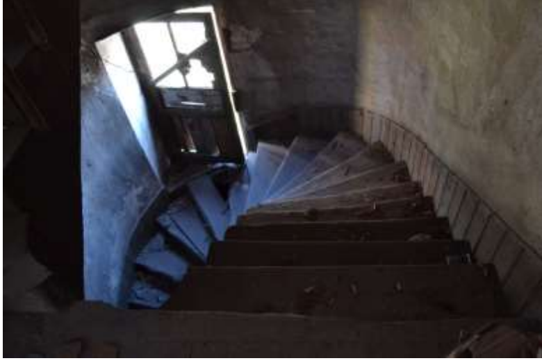
Şekil 3. 1: Güneydoğu cephesine açılan kapı içeriden görünüm
