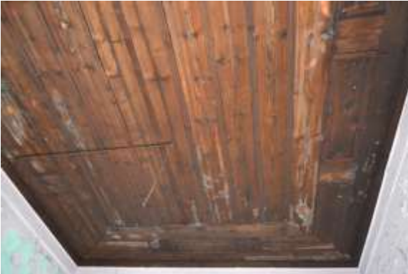
Şekil 2.56: Z09 oda ahşap tavan kaplaması
