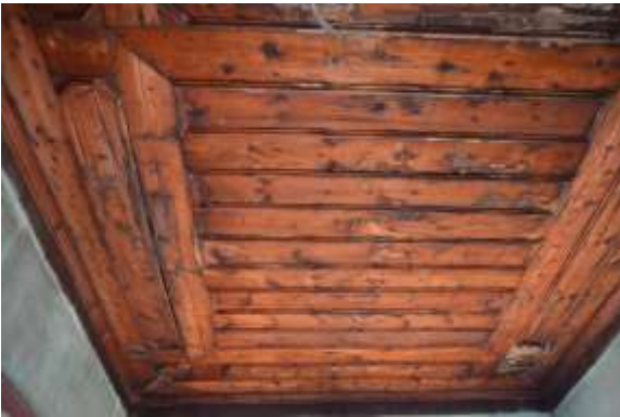
Şekil 2.58: 108 oda ahşap tavan kaplaması
