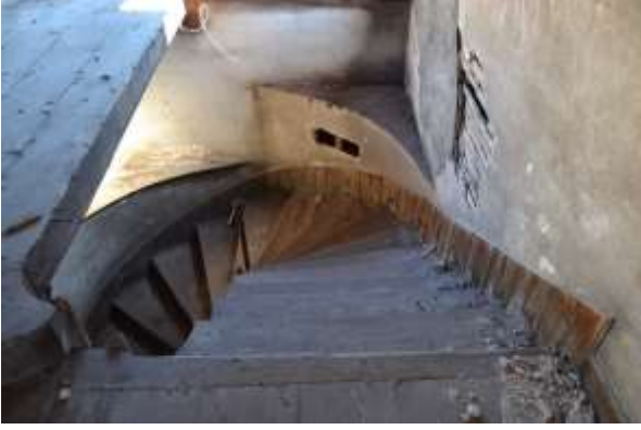
Şekil 2.46: Çatı katından merdivene bakış
