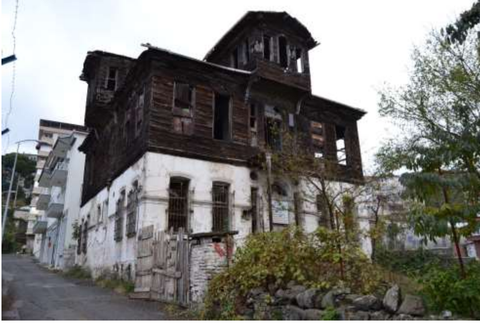
Şekil 2.37: Kuzeybatı cephesi sokak ilişkisi
