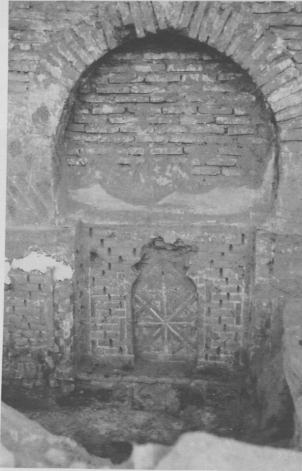
Fot. 27- Mescit, son cemaat yerinde yapılan mevzii kazı ve siva raspası sonucunda meydana çıkarılan son cemaat mihrabı (1965).
