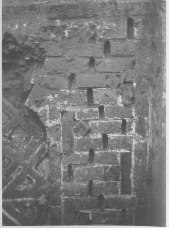
Fot. 30- Mihrapçığın sağ tarafındaki tuğla örgüsü, gömme derzler ve iç ve dış kısımlardaki turkuaz renkli dikey ve kare tuğlalar (1965).
