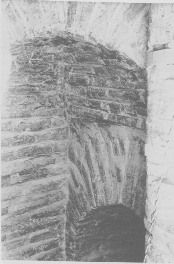
Fot. 7- Merdiven altlarındaki kemer tonozların görünüşü. (1965)
