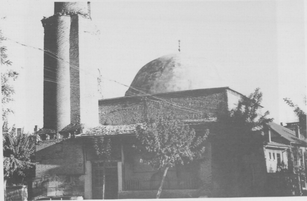
Fot. 21- Onarımdan önce kubbe üzerindeki çıkıntılar (1963).
