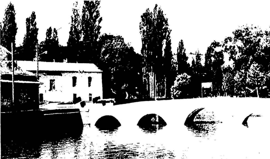
Resim : 3 — Meram Köprüsünün doğu cephesi (Onarımdan sonra) ve geride, solda değirmen
