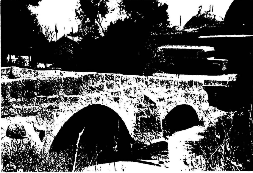
Resim : 2 — Meram Köprüsünün batı cephesi (Onarımdan önce ve geride Meram Hamamı)
