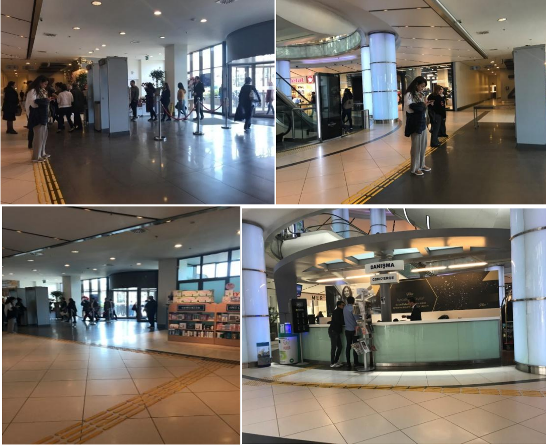
Resim 5.16 : A AVM hissedilebilir yüzey uygulaması (Tuba Terece arşivinden, 2018).
