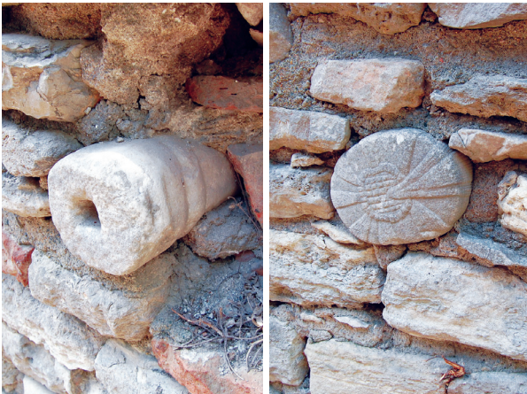
Fotoğraf 20. Avlu duvarında kullanılan mezartaşları (M.Sav, 7.7.2014).
