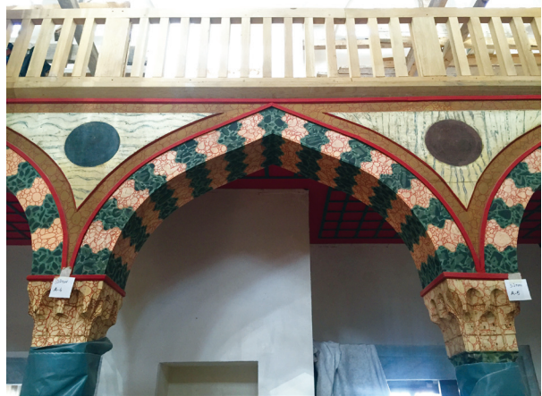
Fotoğraf 15. Mahfil katını taşıyan sütun ve kemerlerin üzerinde bulunan kalemişi bezeme raspa sonrası (M.Sav, 16.6.2014) ve uygulama sonrası (M.Sav / Ö.F.Kara, 5.10.2015).
