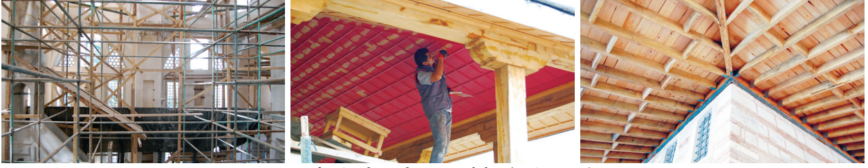
Fotoğraf 7. Saçak uygulaması yapılırken (M. Sav, 2015).
