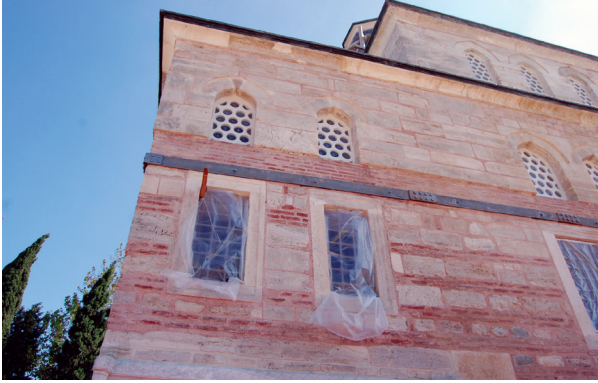
Fotoğraf 13. Caminin cephesinde uygulanan kuşaklama çalışmasından detay (M.Sav).
