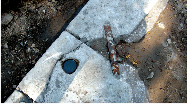
Fotoğraf 9. Mermer döşeme ve paslanmış kenet sisteminden detay (M.Sav,7.7.2014).
