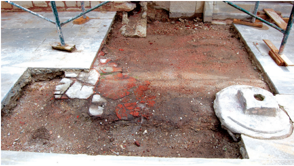
Fotoğraf 10. Son cemaat saçaklarının altıgen tuğla döşemesinden kalanlar ve tam aksta bulunan çatı suyunu kanalla dışarı atmaya yarayan gider (M.Sav, 2.6.2014).
