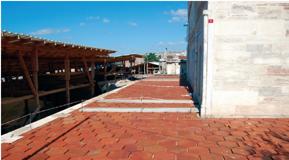
Fotoğraf 11. Son cemaat saçak altı bölümünün altıgen döşeme sistemi uygulanması (M.Sav,2.9.2014).
