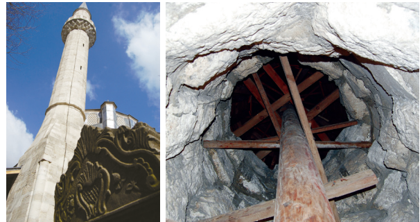
Fotoğraf 16. Minare seren direği, içten ve minarenin dıştan görünümü (16.3.2015).
