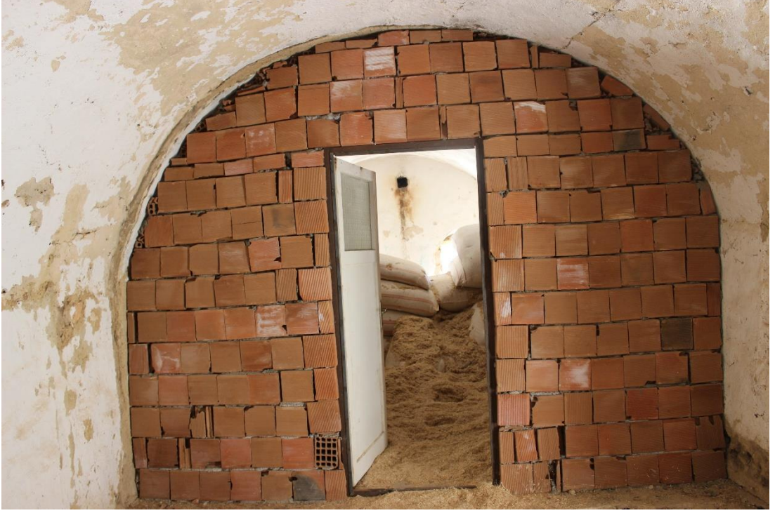
Şekil 5.13: Tuğla malzemesi ile müdahale yapılmış bölme duvar (Ö.Yıldız, 2018)
