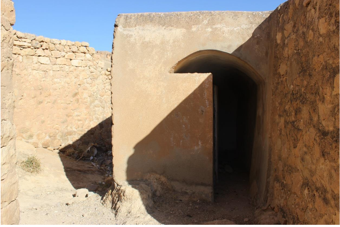
Şekil 5.15: Çimento malzemesi ile eklenti yapılmış yapı (Ö.Yıldız, 2018)
