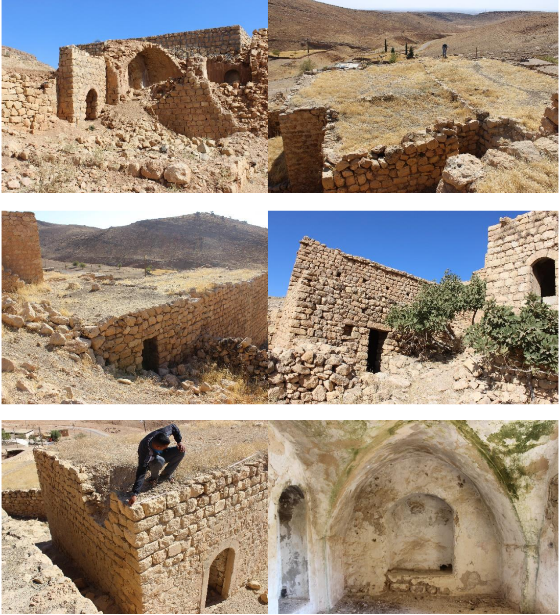
Şekil 5.9 : Yapılarda görülen bozulmalar (Ö.Yıldız, 2018)
