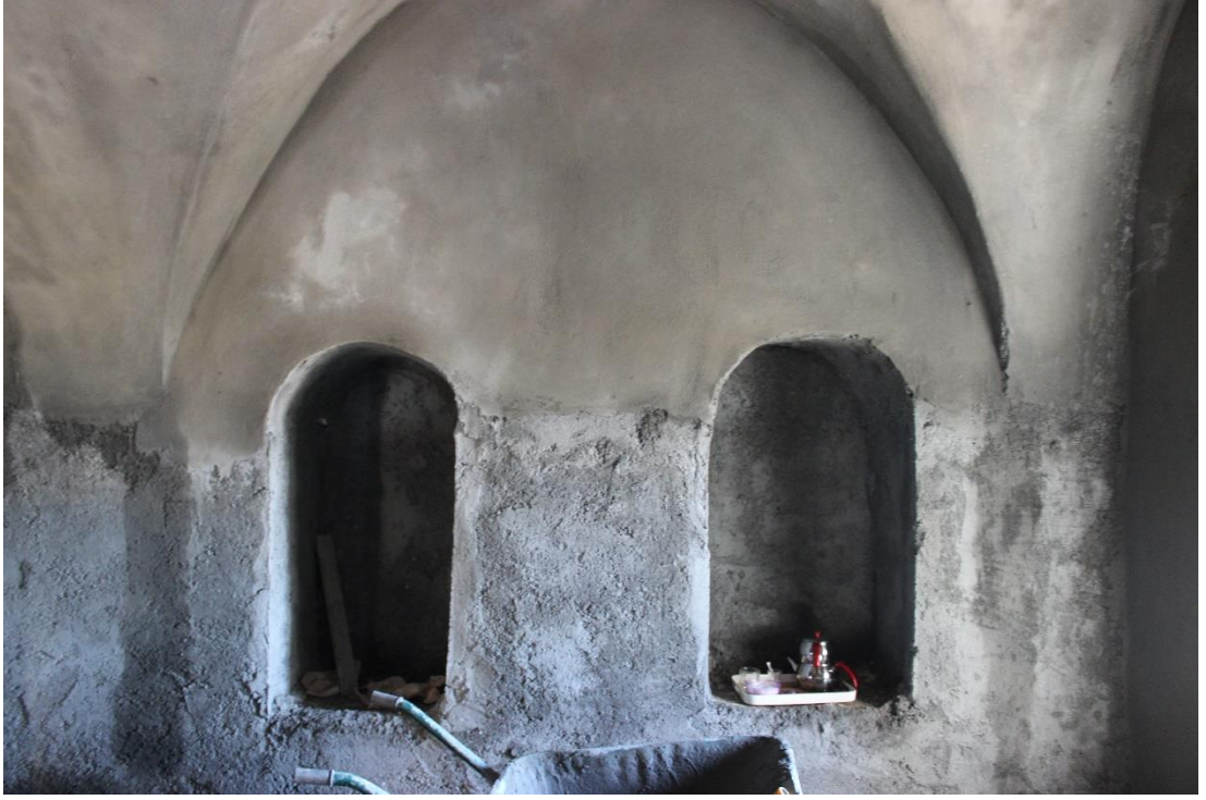
Şekil 5.11: Çimento malzemesi ile müdahale yapılmış duvar (Ö.Yıldız, 2018)
