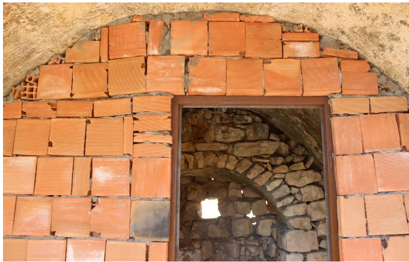
Şekil 5.10: Çimentolu malzemeler ile müdahale yapılmış duvarlar (Ö.Yıldız, 2018)
