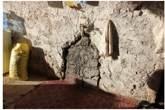
Şekil 6.1- 6.2 :Yapılara eklenen tuğla ve çimento malzeme uygulaması
