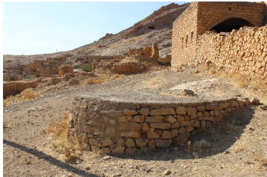
Şekil 5.4-5.5-5.6: Su deposu ve su kuyuları
