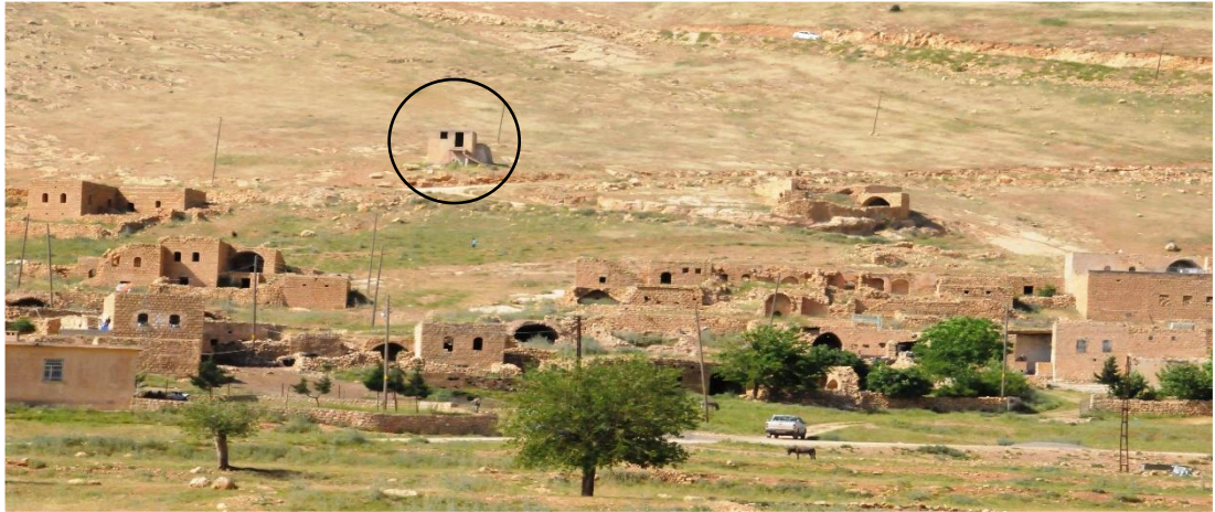
Şekil 5.3: Alımlı Köyü betonarme su deposu ( Ö.Yıldız, 2018 )
