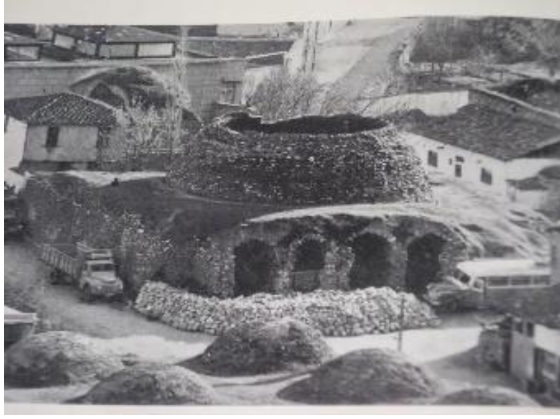
Fotoğraf 3.10: Tokat Yağibasın Medresesi'nin yıkılan bölümleri tamamlanmadan önceki görünümü (Kuran, 1968)
