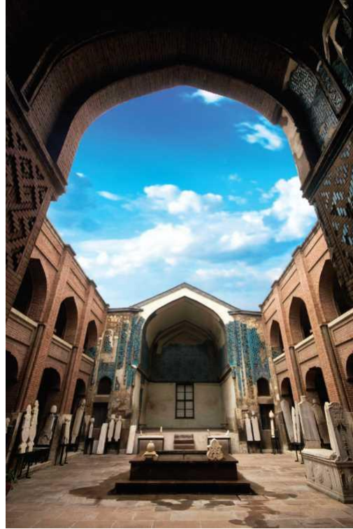
Fotoğraf 3.15: Konya Sırçalı Medresesi'nin yıkılan bölümleri tamamlandıktan sonraki görünümü (URL 65)
