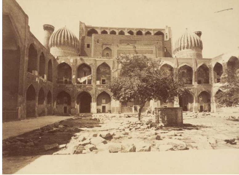
Fotoğraf 3.7: Şirdar Medresesi'nin restore edilmeden önceki görünümü (URL 93)
