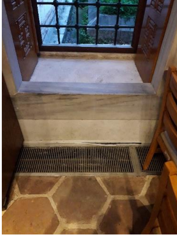
Fotoğraf 3.61: Şemsi Ahmet Paşa Medresesi'ne yapılan teknik müdahaleler (Aytekin, 2021)
