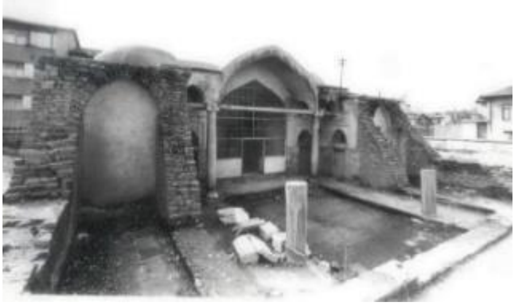
Fotoğraf 3.12: Konya Ali Gav Medresesi'nin yıkılan bölümleri tamamlanmadan önceki görünümü (VGM Arşivi)
