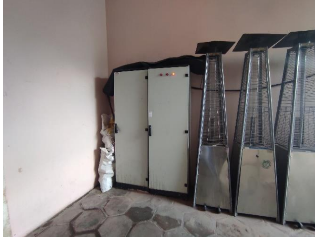
Fotoğraf 3.62: Zal Mahmut Paşa Medresesi'ne yapılan teknik müdahaleler (Aytekin, 2021)
