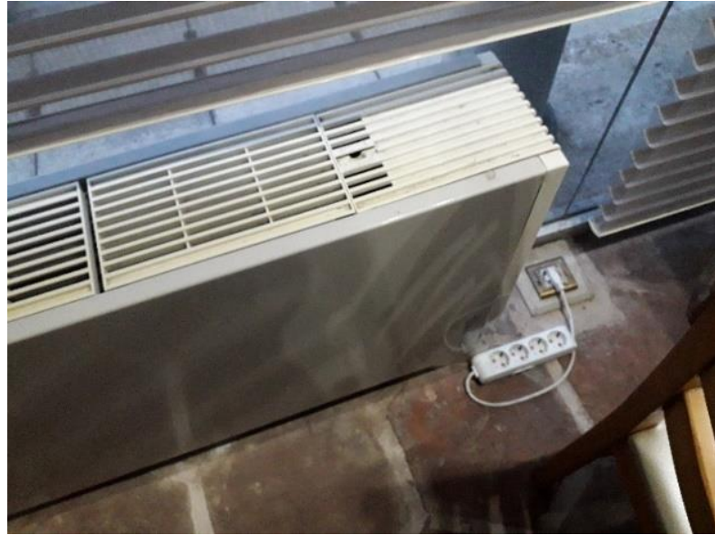
Fotoğraf 3.60: Şemsi Ahmet Paşa Medresesi'ne yapılan teknik müdahaleler (Aytekin, 2021)
