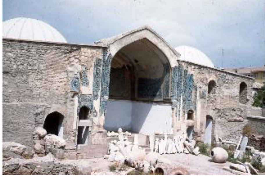
Fotoğraf 3.14: Konya Sırçalı Medresesi'nin yıkılan bölümleri tamamlanmadan önceki görünümü (Ülgen Arşivi)
