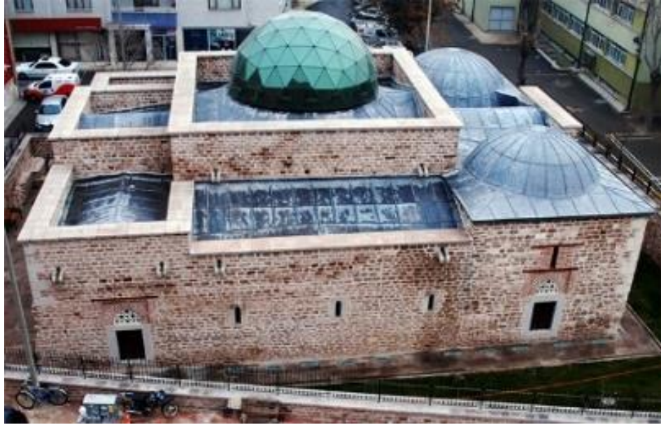
Fotoğraf 3.13: Konya Ali Gav Medresesi'nin yıkılan bölümleri tamamlandıktan ve kubbe açıklığı kapatıldıktan sonraki görünümü (URL 61)
