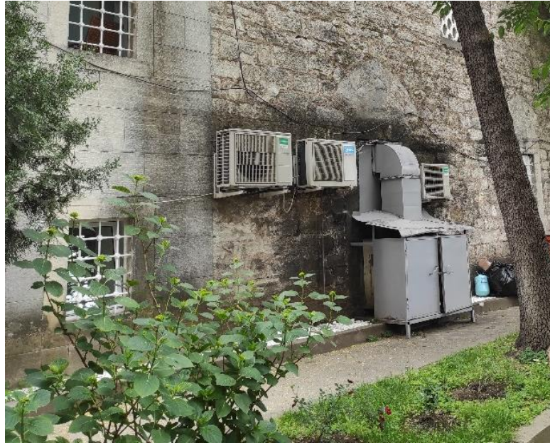
Fotoğraf 3.68: Mihrimah Sultan Medresesi'ne yapılan teknik müdahaleler (Aytekin, 2021)
