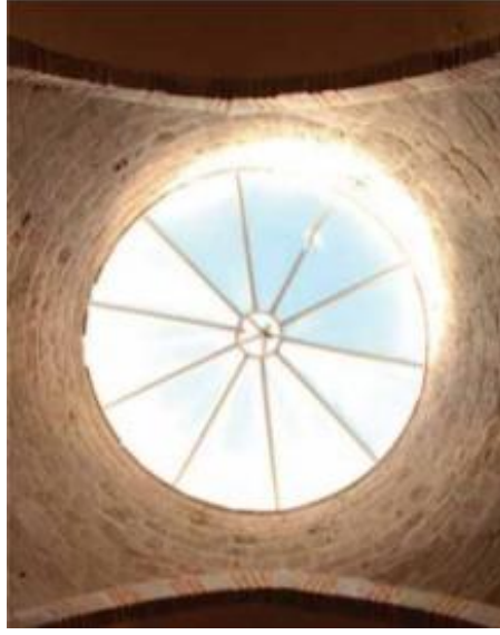
Fotoğraf 3.18: Isparta Ertokuş Medresesi kapatılan kubbe açıklığı (Şaman Doğan, 2008)
