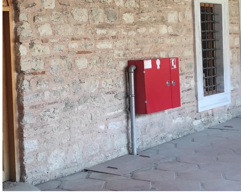
Fotoğraf 3.59: Siyavuş Paşa Medresesi'ne yapılan teknik müdahaleler (Aytekin, 2021)
