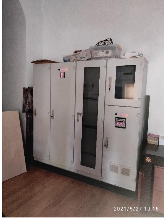
Fotoğraf 3.55: Rüstem Paşa Medresesi'ne yapılan teknik müdahaleler (Aytekin, 2021)
