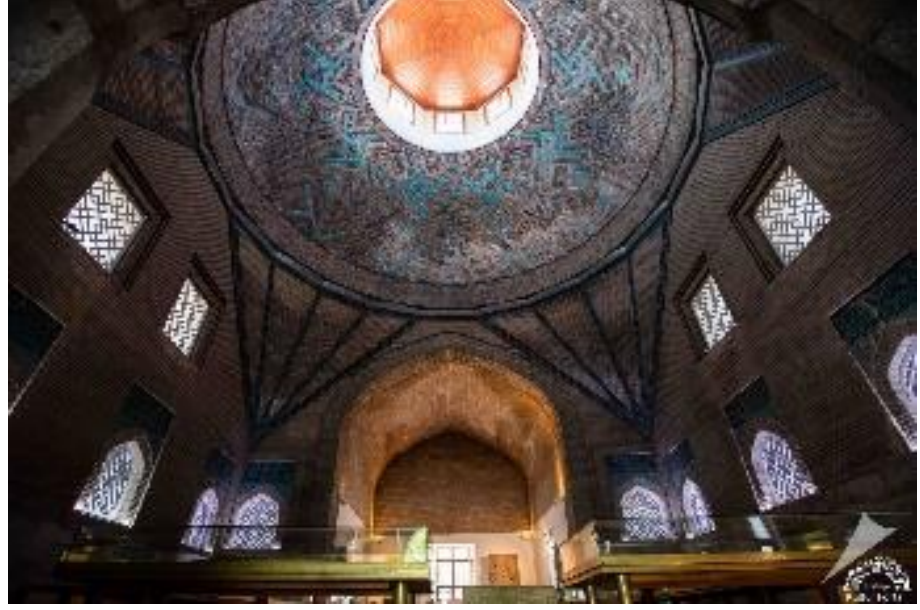
Fotoğraf 3.16: Konya İnce Minareli Medresesi'nin yıkılan ve kubbe açıklığı kapatıldıktan sonraki görünümü (URL 70)
