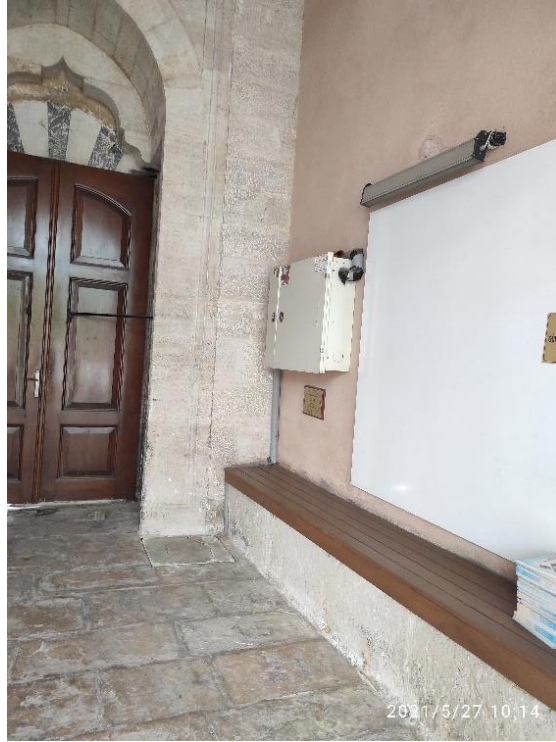
Fotoğraf 3.56: Rüstem Paşa Medresesi'ne yapılan teknik müdahaleler (Aytekin, 2021)
