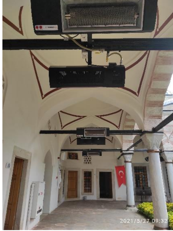
Fotoğraf 3.63: Kılıç Ali Paşa Medresesi'ne yapılan teknik müdahaleler (Aytekin, 2021)
