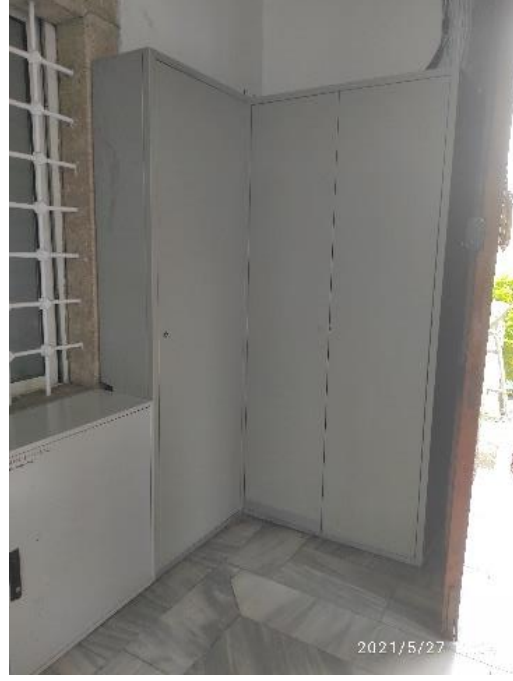
Fotoğraf 3.67: Mihrimah Sultan Medresesi'ne yapılan teknik müdahaleler (Aytekin, 2021)
