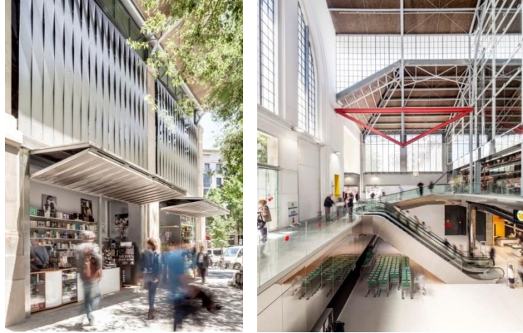
Şekil 3.50 Saçak işlevi kazanan kepenkler. (URL-34)
