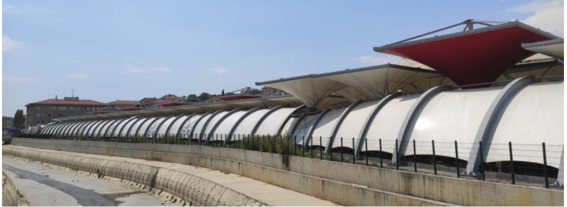
Şekil 2.23 Asma-Germe sistem pazarın dışardan bir görünüşü. Kaynak: Yazar tarafından oluşturulmuştur.
