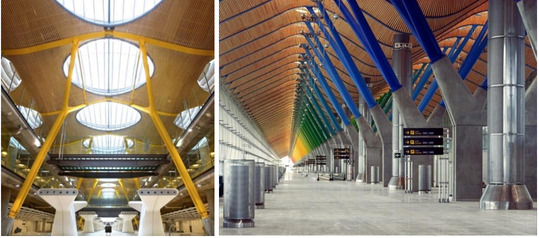
Şekil 3.35 Madrid Barajas Havalimanı, İç Mekan Renkli Çelik Taşıyıcılar. (URL-27)
