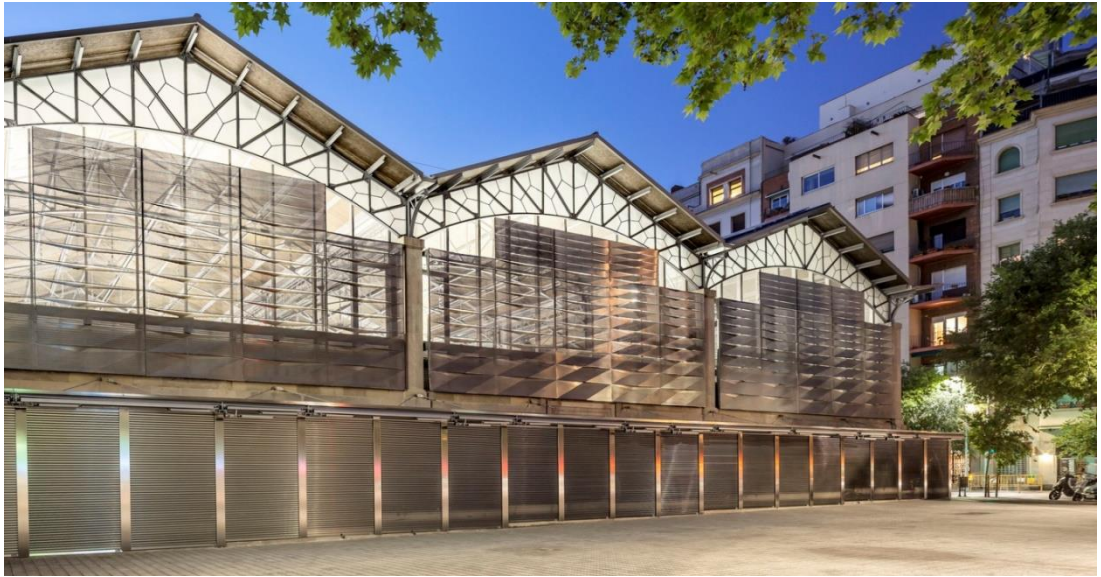
Şekil 3.48 Ninot Market güneş kırıcılı saydam cephe. (URL-34)
