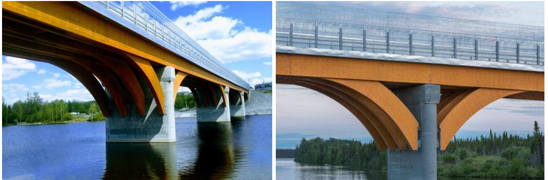
Şekil 3.30 Mistissini Köprüsü. (URL-23)
