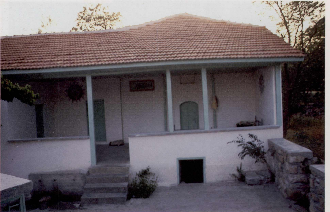
Resim 25: Zaviyenin doğu cephesi (Sağ altta türbenin kriptasına giriş kapısı görülüyor).
