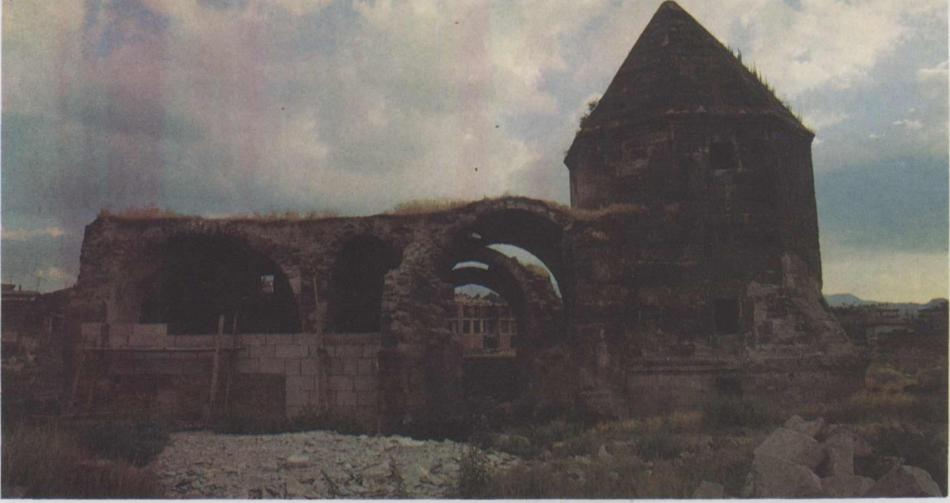
Resim5 :Medresenin kuzey (giriş) cephesinden görünüş.
