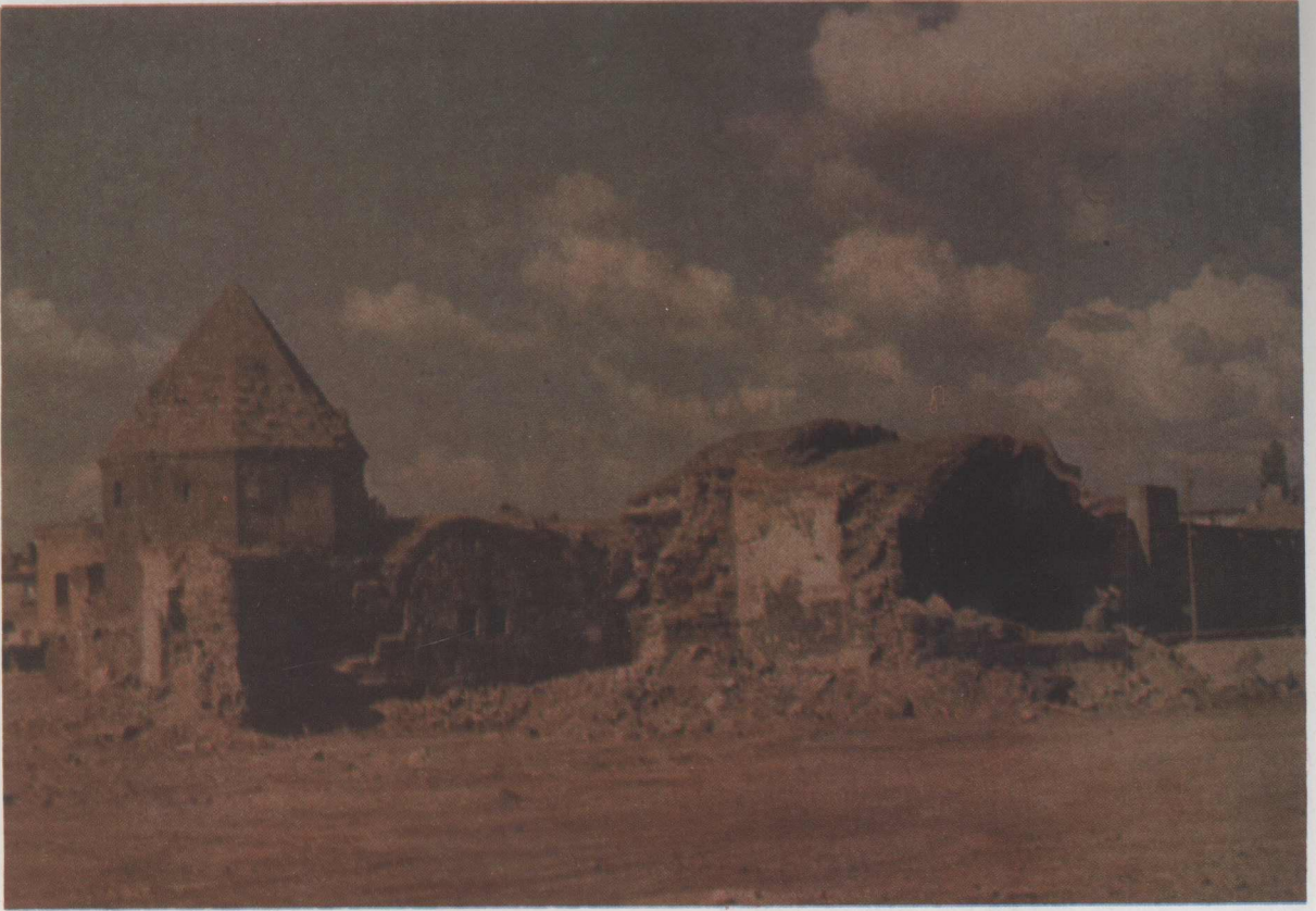
Resim 3: Medrese kalıntılarının güneyden görünüşü (istimlak sonrası).
