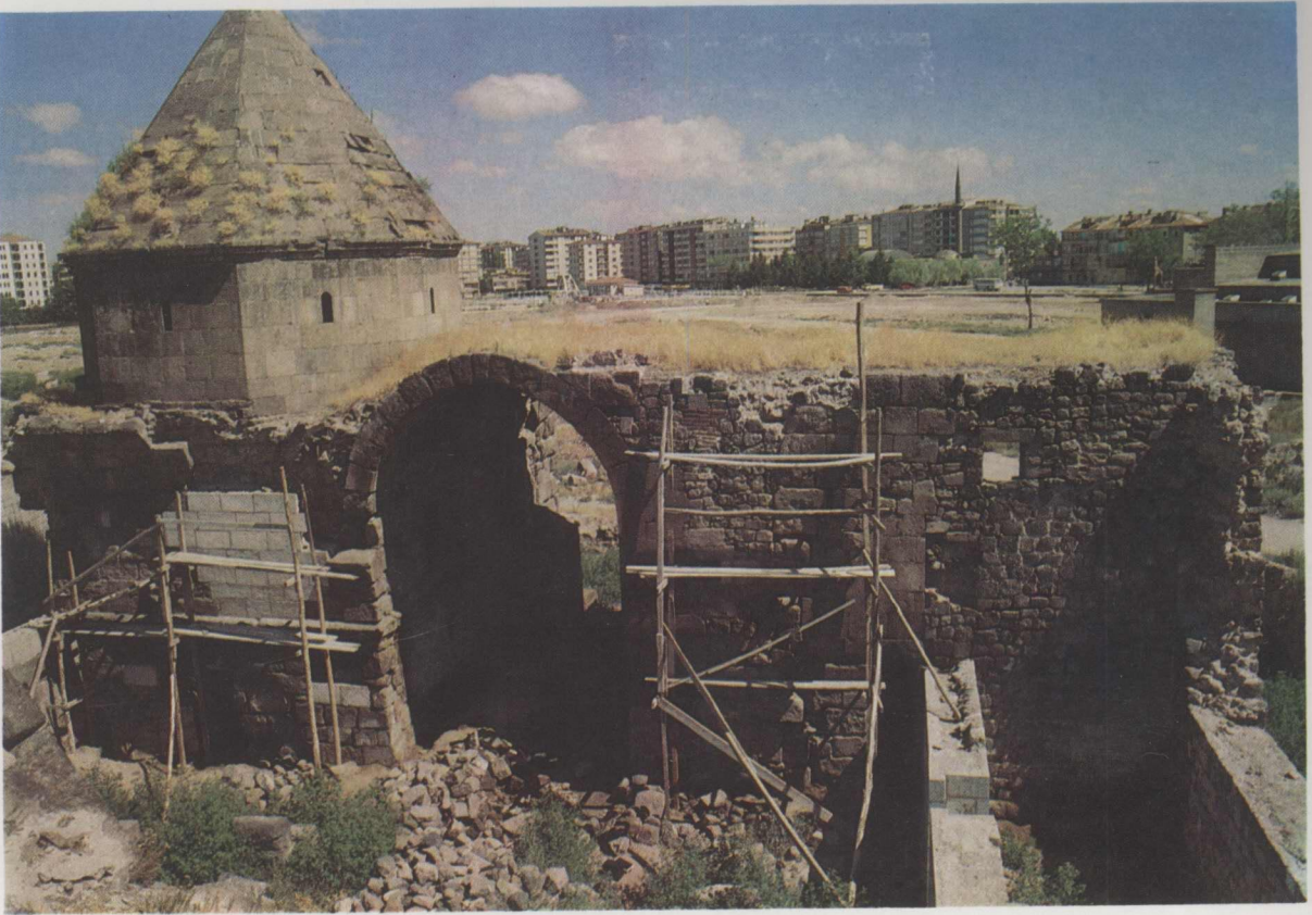
Resim 9: Aulunun kuzey cephesinden görünüş (hafriyat sonrası).
