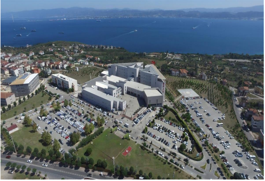
Resim 5.1: Kocaeli Darıca Fârâbî Eğitim ve Araştırma Hastanesi Genel Görünüş (Url-32).
