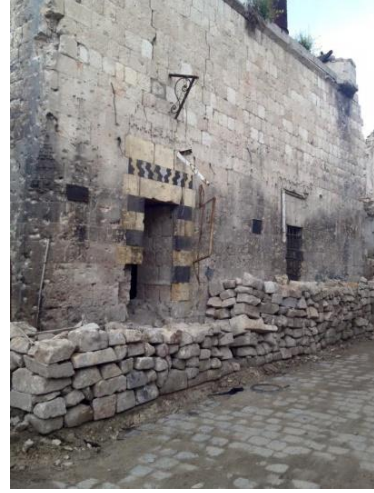
Şekil 19: Mescid'in Mevcut Durumu, 2017
