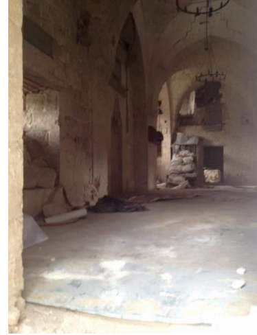
Şekil 20: Mescid'in Mevcut Durumu, 2017
