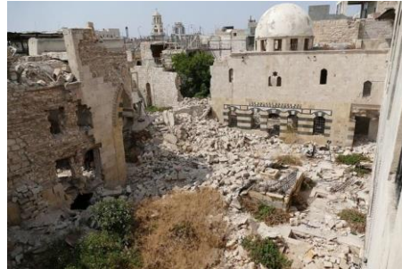
Şekil 6: Gazale Evi, Evin Avlu ve Eyvanı, wikiwand. 2017. (URL-22)
