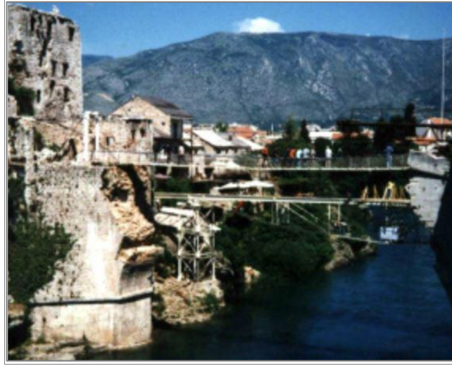
Şekil 5. 7 Mostar'daki (1566) Eski Köprü'nün 1993'teki yıkımından sonra kalıntıları, (Sulejmn Demirović)
