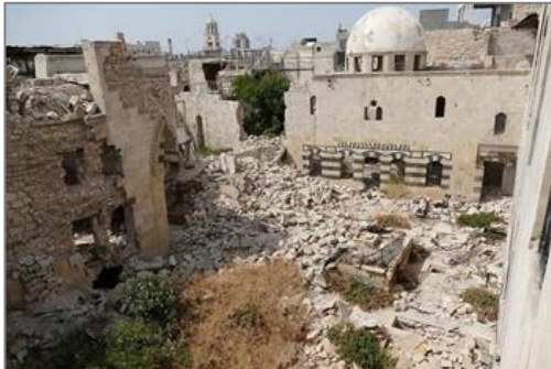
Şekil 4. 12 Gazale evi, Evin Avlu ve Eyvanı, wikiwand. 2017. (URL-22)
