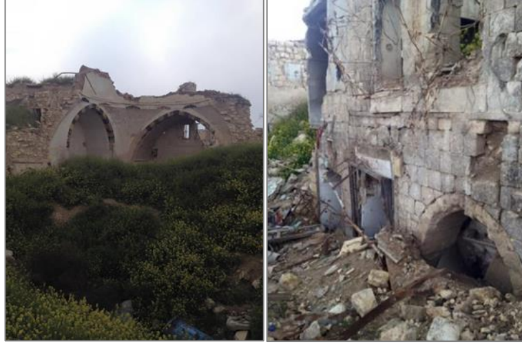
Şekil 4. 11 Behram Paşa Hamamı, Mevcut Durum, 2017
