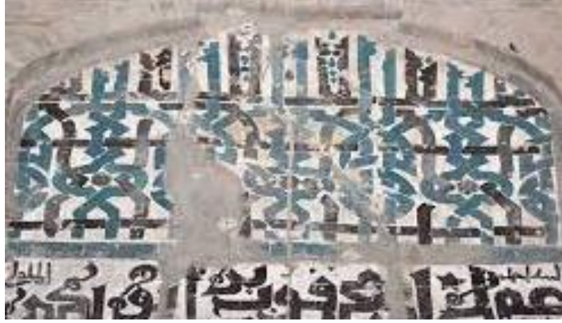
Resim 6: 13. yy Sahte Çini Mozaik Tekniği Malatya Ulu Camii. (Kaynak: Nevin Ayduşlu, Bir Selçuklu Çini Tekniği; Sır Kazıma, s. 14)
