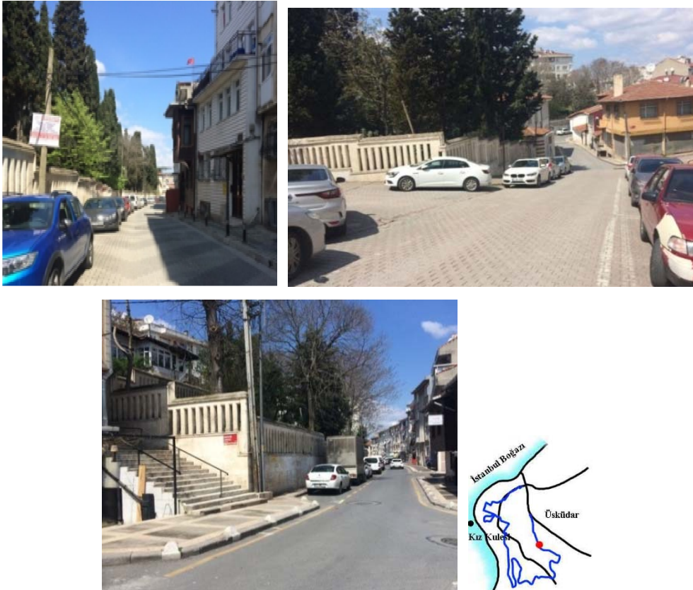
Şekil 3.59 : Mezarlık duvarları (16.04.2019), fark edilen 37 konum krokisi (alt sağ)
