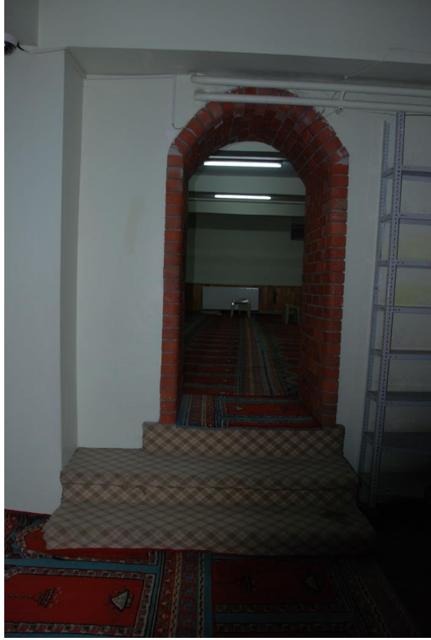
Ek D. 65: Z04 Harim batı duvarı tuğla merdiven basamakları
