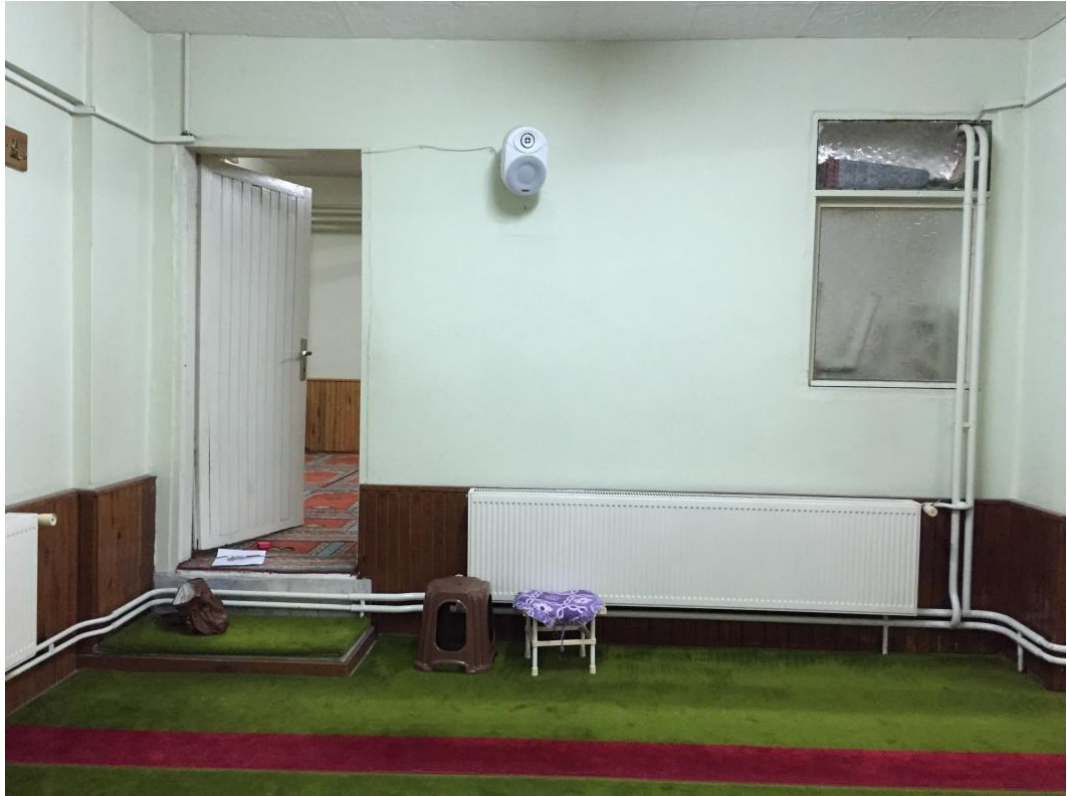
Ek D. 58: Z01 Harim güney duvarı
