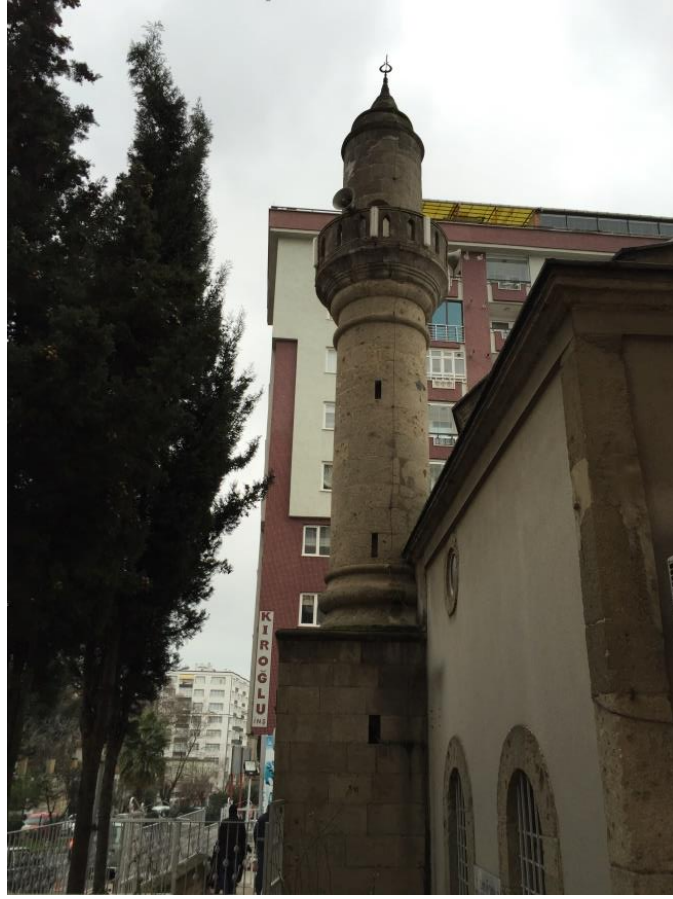
Ek. D. 29: Minare ve kaidesi güney duvarı
