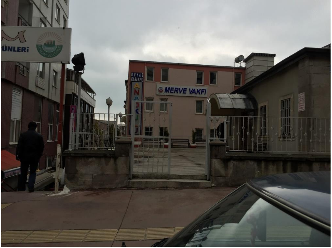
Ek. D. 11: Bahçe taş duvarı ve bahçe giriş kapısı
