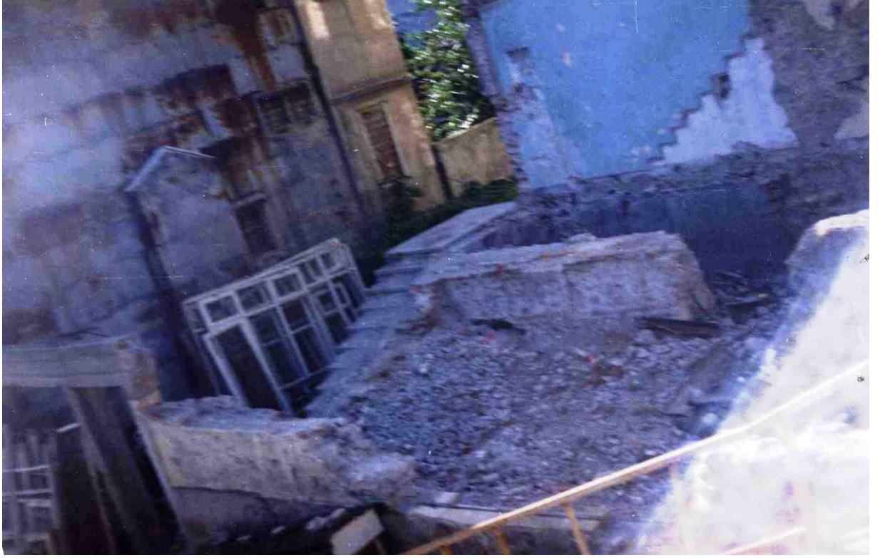
Ek. C. 38: Bitişik yapı yıkımı (Vakıflar Genel Müdürlüğü Arşivi)
