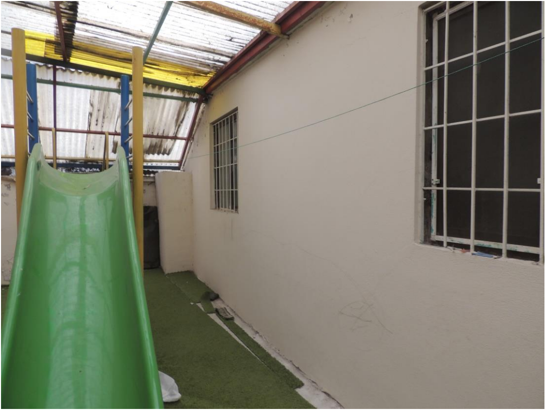
Ek. D. 16: Z05 harime ait dođu duvarı
