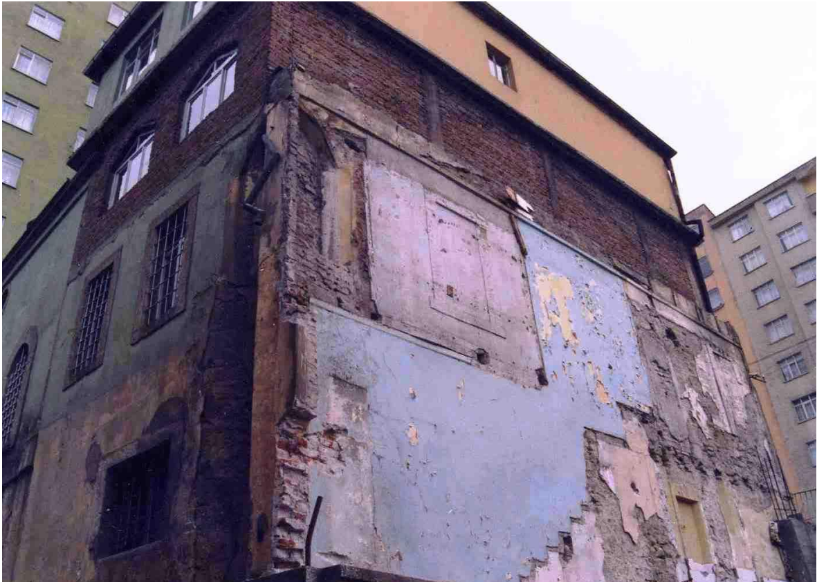
Ek. C. 39: Bitişik Yapı Güney Cephe (Vakıflar Genel Müdürlüğü Arşivi)
