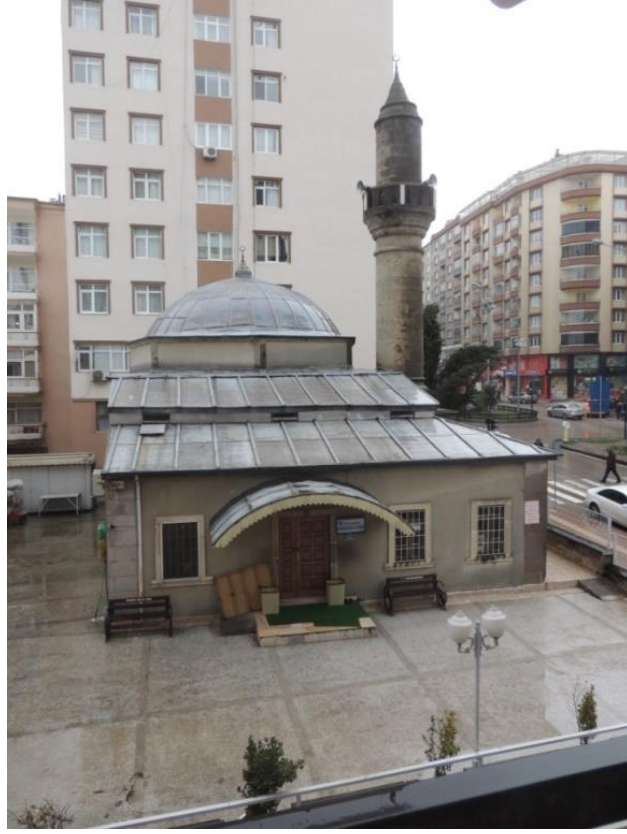
Ek. D. 19: Kuzey cephe genel görünüm
