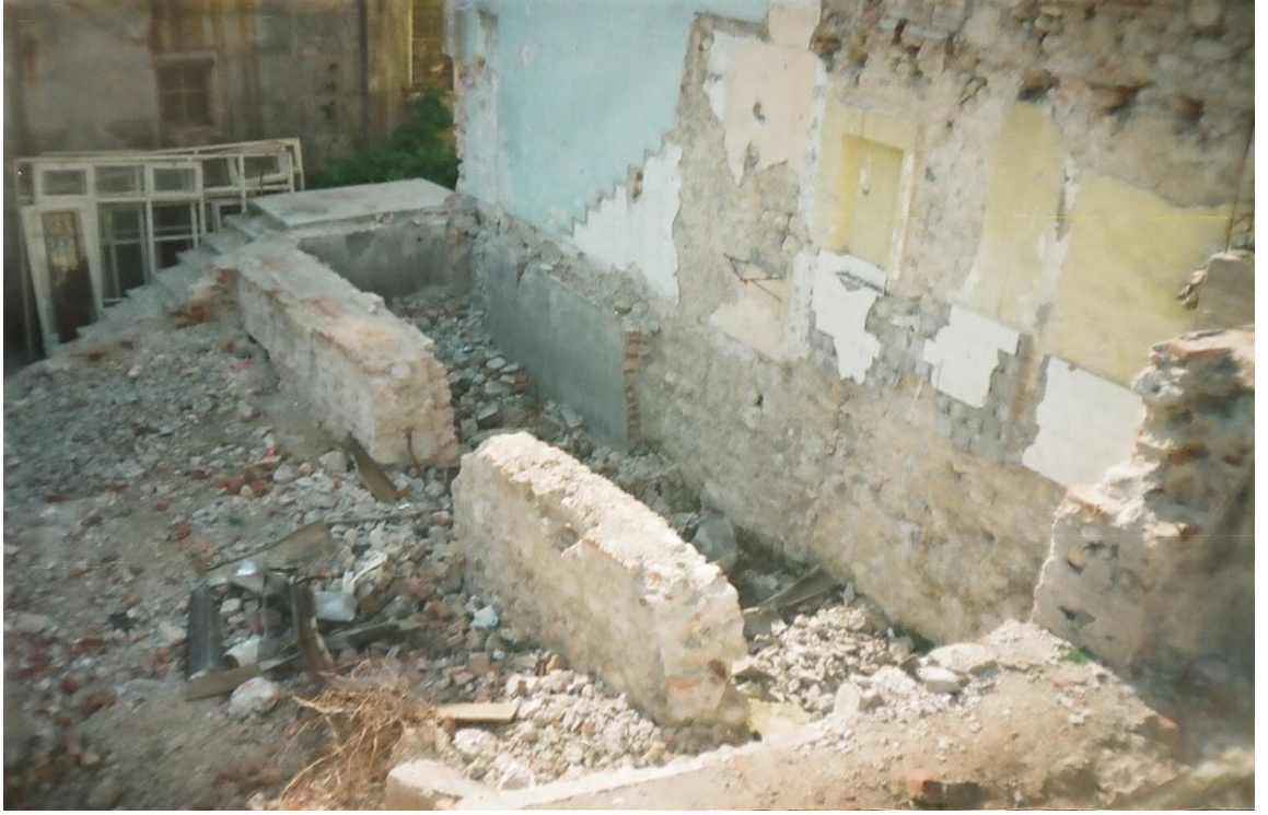
Ek. C. 44: Bitişik Yapı Yıkımı (Vakıflar Genel Müdürlüğü Arşivi)
