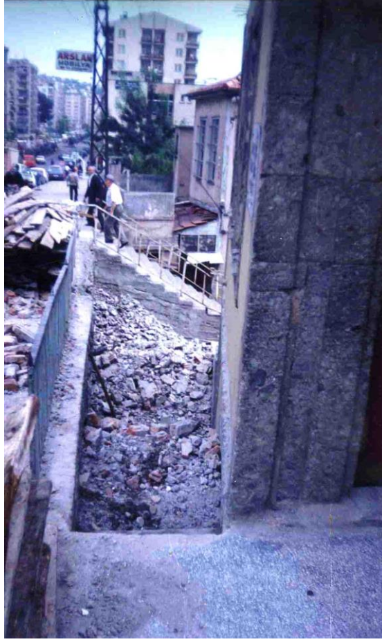
Ek. C. 46: Bitişik Yapı Yıkımı (Vakıflar Genel Müdürlüğü Arşivi)
