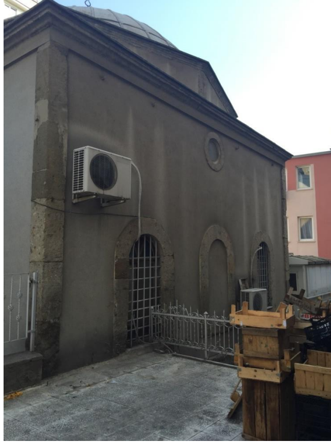
Ek. D. 25: Güney cephe genel görünüm
