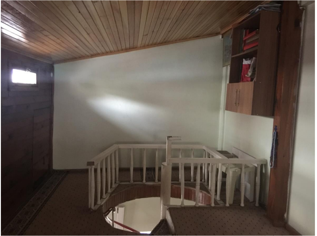
Ek D. 78: N101 Harim doğu duvarı
