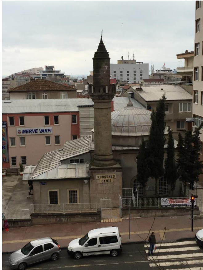
Ek. D. 6: Kurşunlu Camii Batı Cephesi
