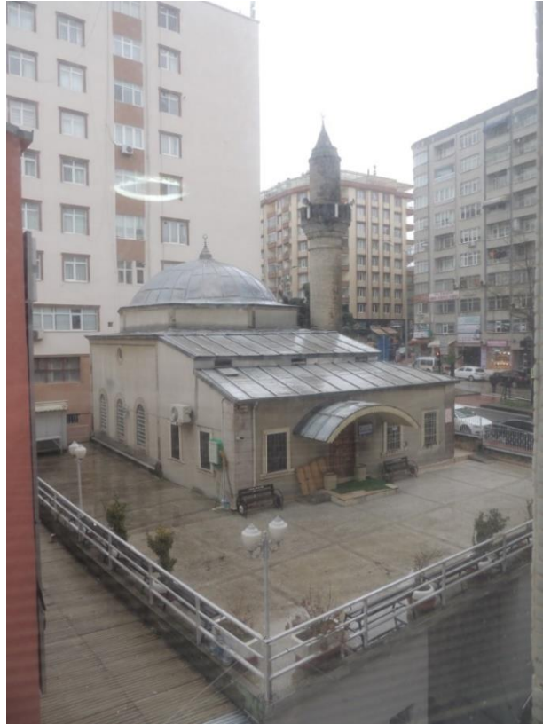
Ek. D. 20: Kuzey cephe genel görünüm
