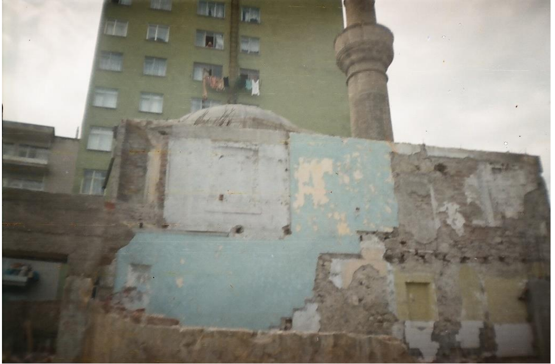
Ek. C. 47: Bitişik Yapı Yıkımı (Vakıflar Genel Müdürlüğü Arşivi)
