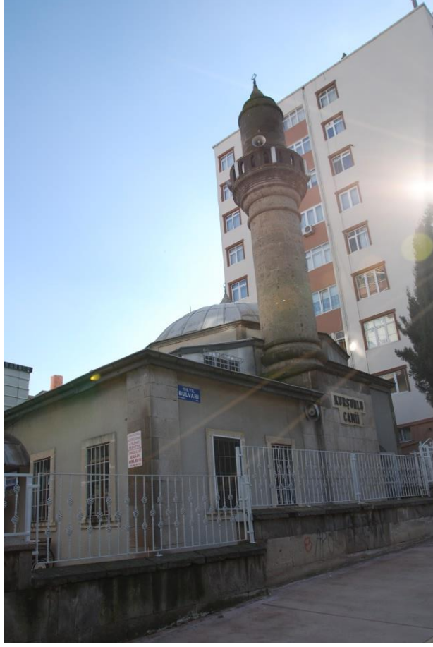
Ek. D. 7: Kurşunlu Camii Batı Cephesi
