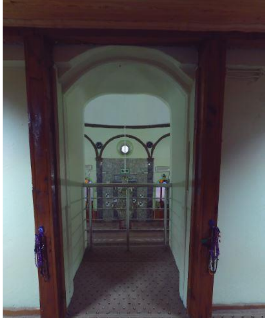
Ek D. 79: N101 Harim'den ana mekana açılan basık kemerli kapı açıklığı
