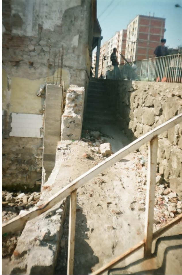
Ek. C. 43: Bitişik Yapı Yıkımı (Vakıflar Genel Müdürlüğü Arşivi)
