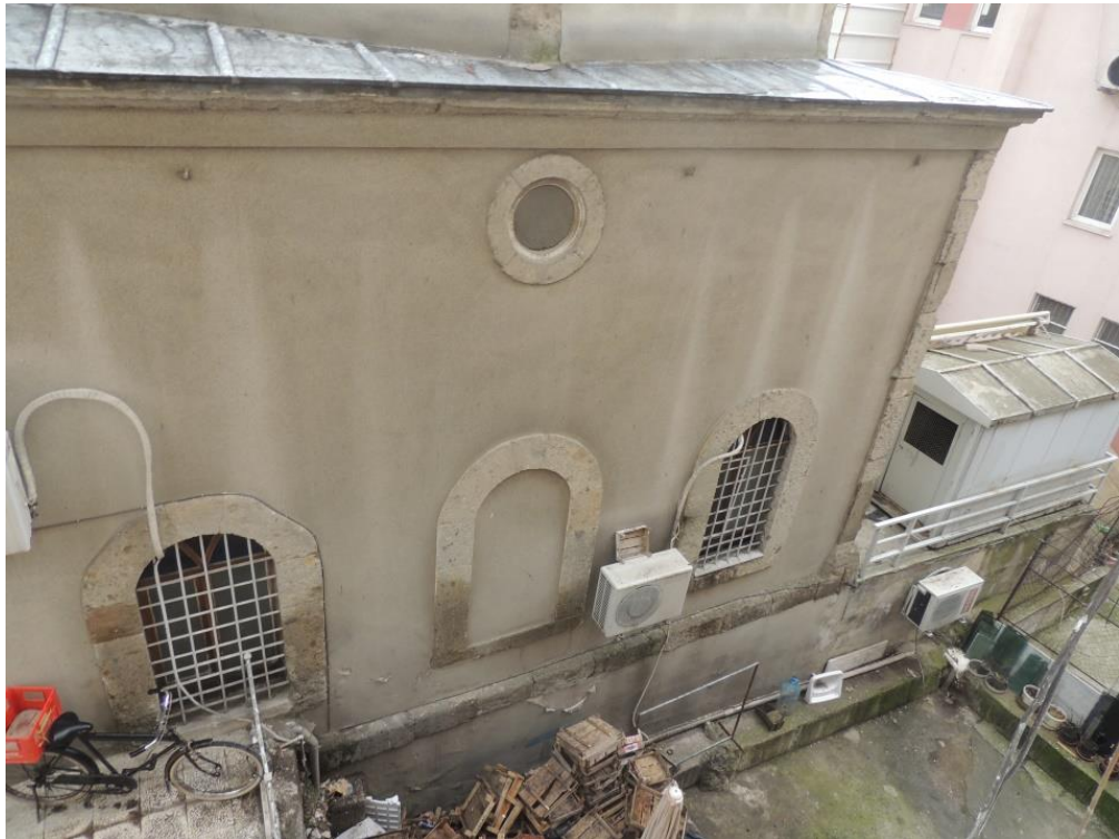
Ek. D. 26: Güney cephe genel görünüm
