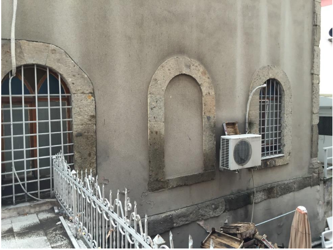
Ek. D. 27: Harimin güney duvarının pencereleri
