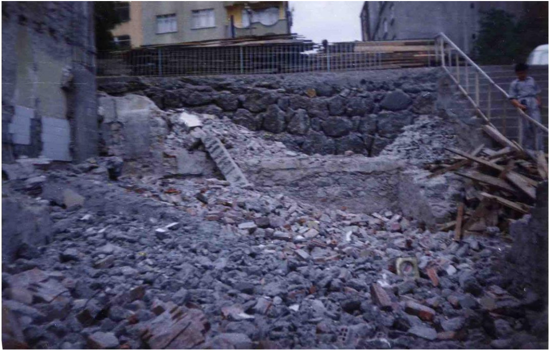
Ek. C. 41: Bitişik Yapı Yıkımı (Vakıflar Genel Müdürlüğü Arşivi)
