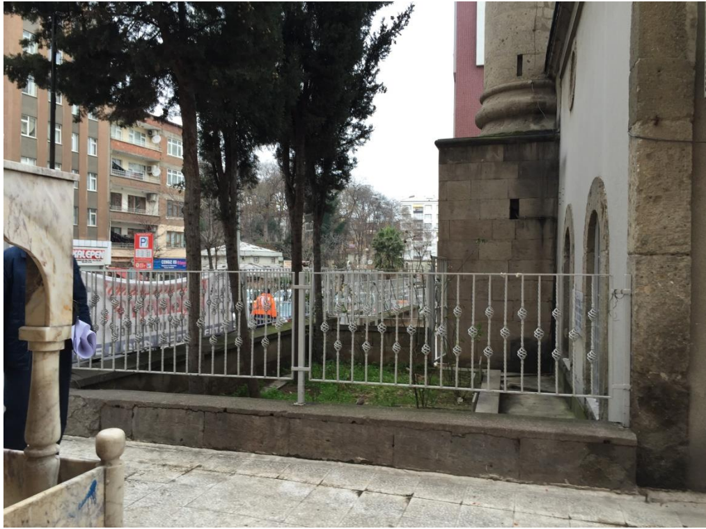
Ek. D. 30: Bahçe güney taş duvarı ve korkulukları
