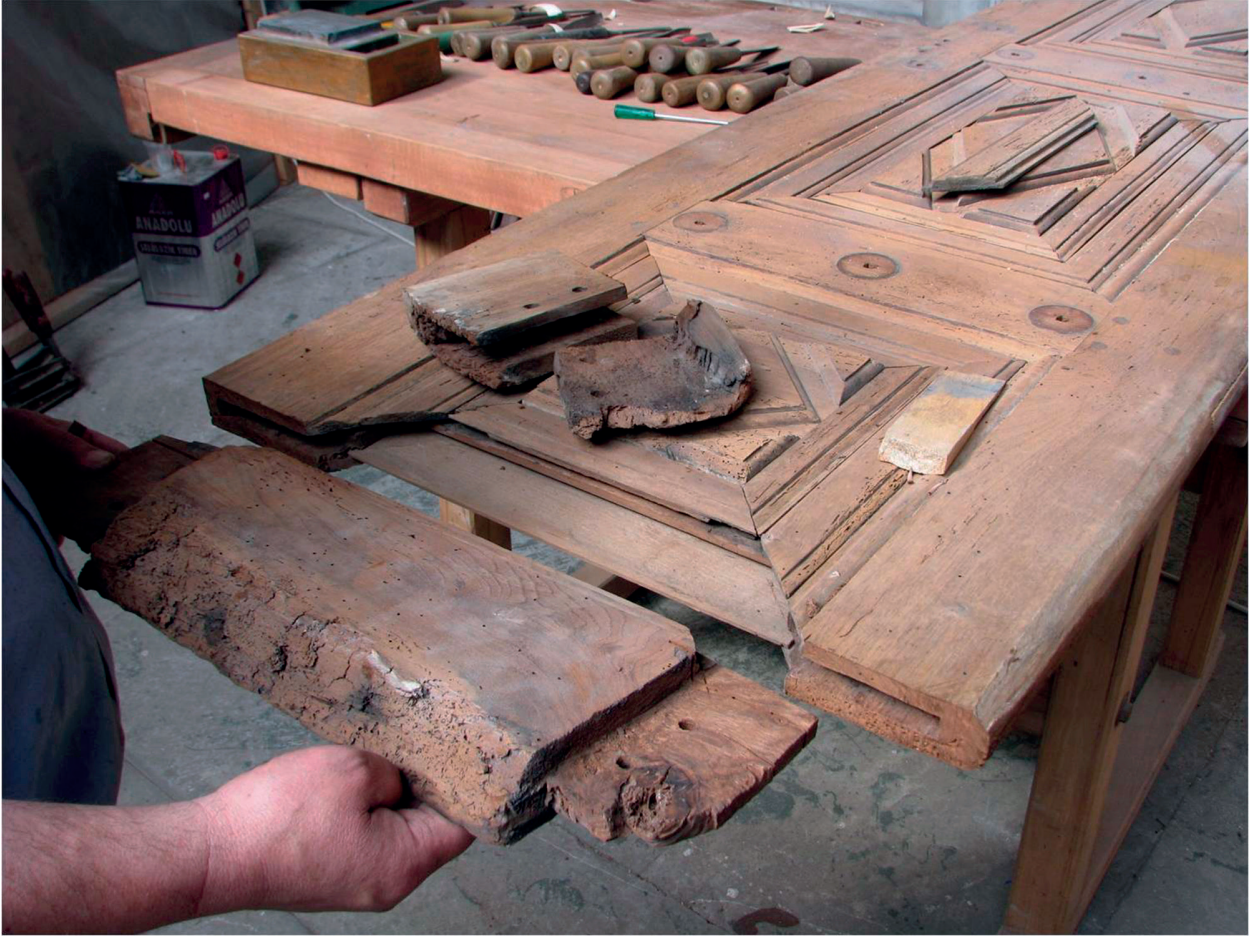
Fotoğraf 12. Ahşap malzemede temizlik-bütünleme-sağlamlaştırma (Durak, 2012)
