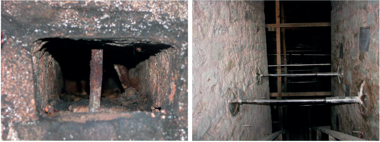
Fotoğraf 14. Cami alt yapısında/bodrum katta, solda temizlenmiş hatıl boşlukları, sağda sağlamaştırma örneđi (Durak, 2012)
