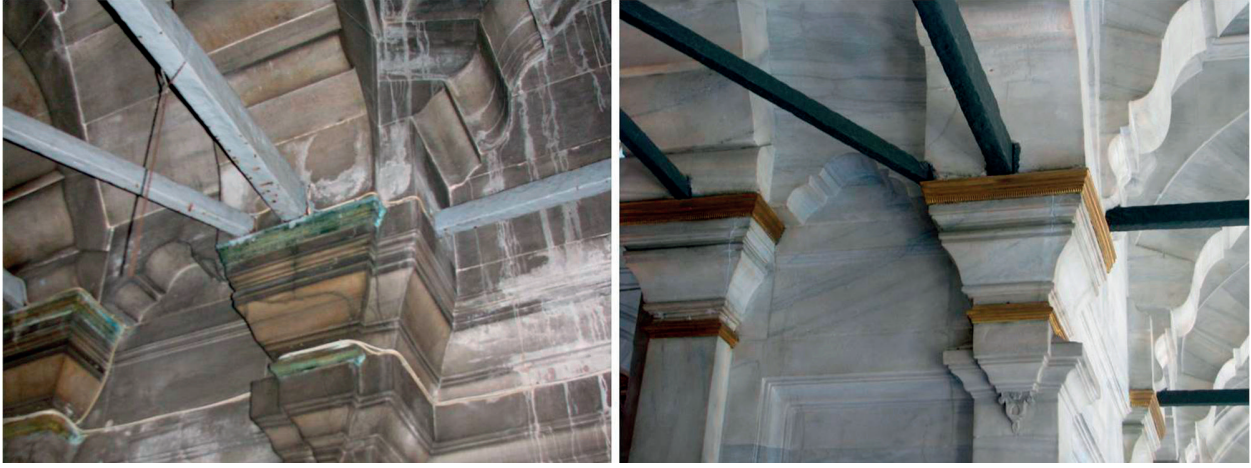
Fotoğraf 10. Kontrollü düşük basınç altında kumla temizlenmiş mermer yüzeyler (Durak 2012)
