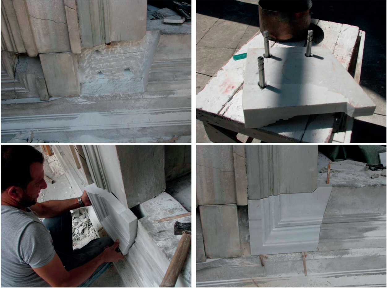
Fotoğraf 13. Mermer yapı elemanı bileşenlerinde temizleme-bütünleme-sağlamaştırma (Durak, 2012)
