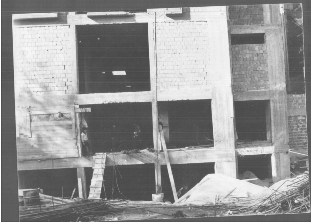
Şekil 1.63. Opera Pasajı Şantiye Fotoğrafi – 1975 (Kadıköy Belediye Arşivi)
