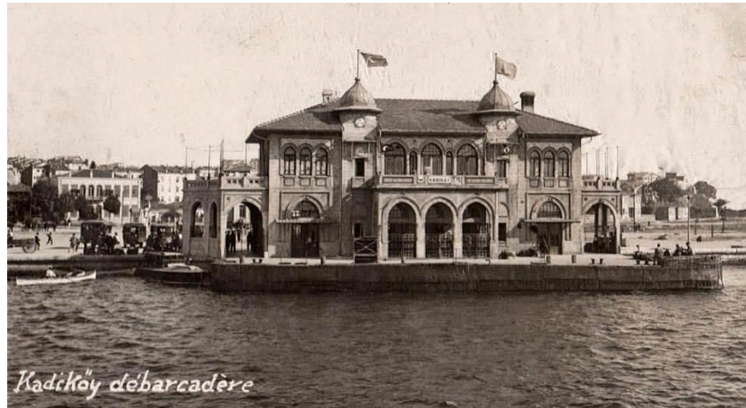
Şekil 3.6. İskele Binası (URL-27).
