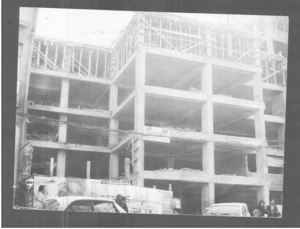
Şekil 1.62. Opera Pasajı Şantiye Fotoğrafi – 1975 (Kadıköy Belediye Arşivi)
