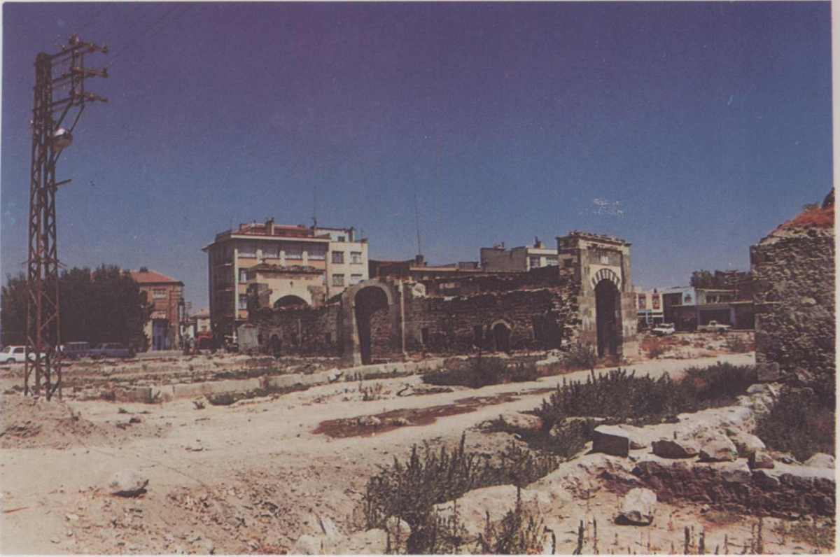
11. Karapınar II. Selim Külliyesi Hanı'nın batı bölümünün kazı sonrası genel görünüşü.
