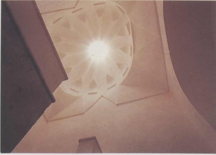
4. Konya Mahkeme Hamamı restorasyon sonrası hela kubbesinin görünüşü
