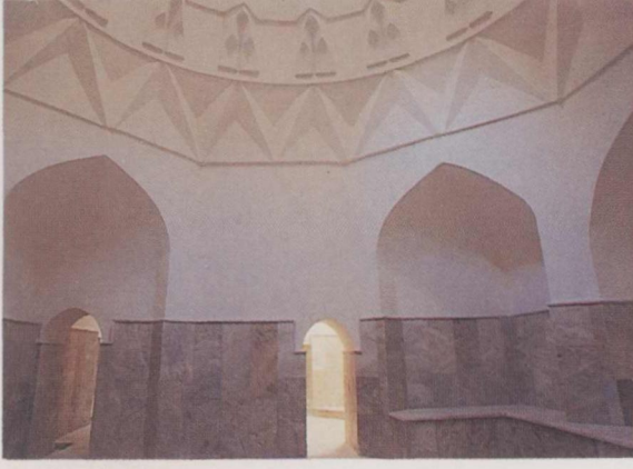
7. Konya Mahkeme Hamamı erkekler kısmı, ılıklik bölümünün restorasyon sonrası genel görünümü
