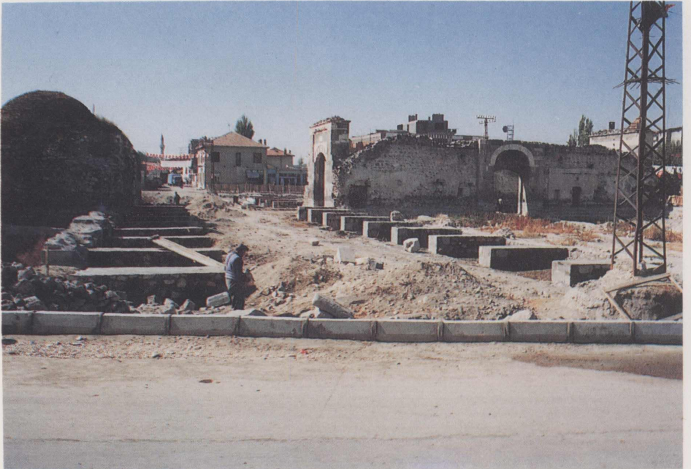
15. Karapınar II. Selim Külliyesi Arastası temellerinin takviyesi.
