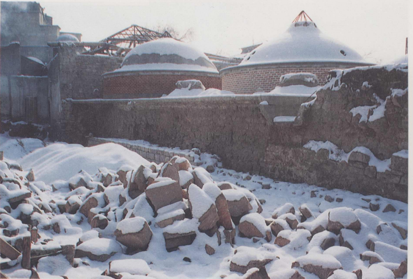
13. Konya Mahkeme Hamamı kubbelerinden restorasyon sonrası bir ayrıntı.
