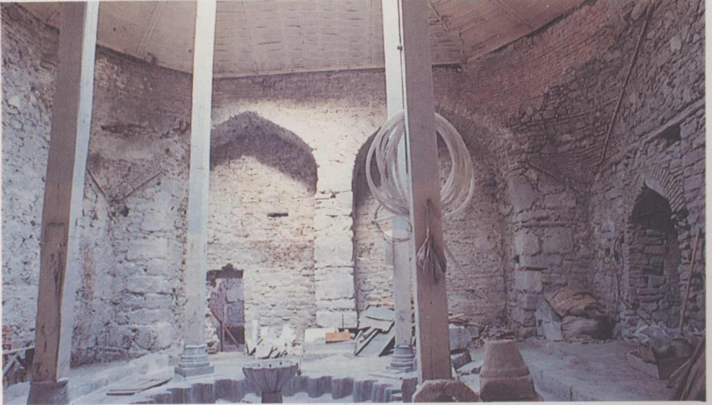
3. Konya Mahkeme Hamamı erkekler bölümü soyunmalığının sıva raspası sonrası genel görünüşü.
