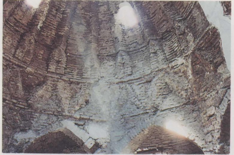
5. Konya Mahkeme Hamamı erkekler kısmı ılık bölümü siva raspası sonrası genel görünüşü.
