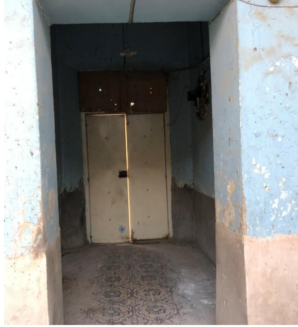
Şekil 4.46 Hacı Osman Oruç Evi takaltıdan giriş fotoğrafı.
