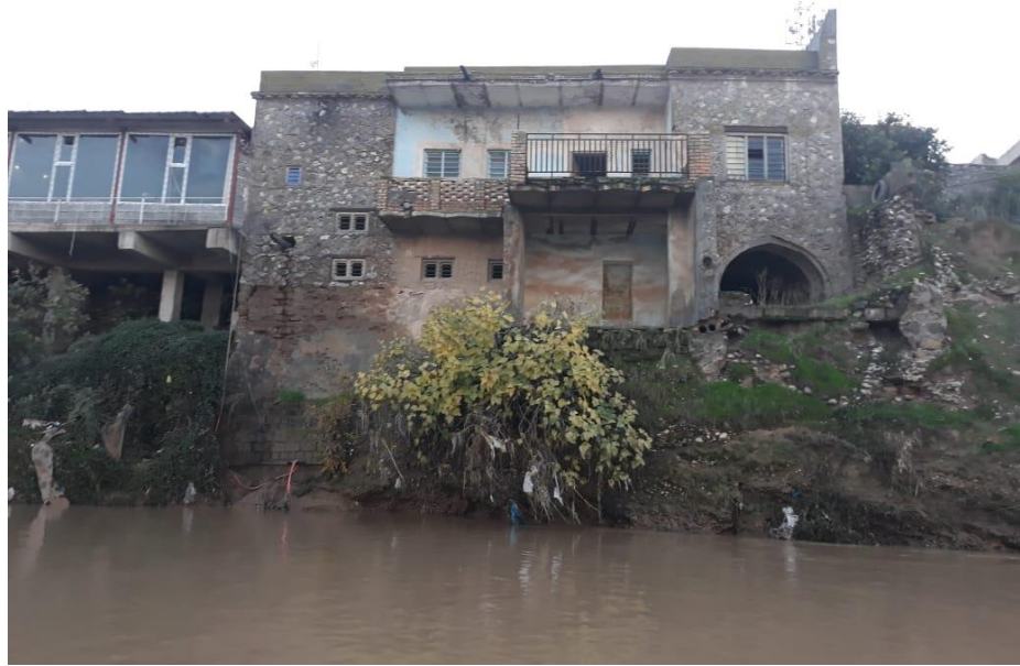
Şekil 4.51 Hac1 Osman Oru Evi Aşağı Zap nehrinden fotoğraf.
