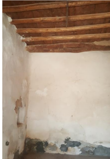
Şekil 4.21 Ahmet Ali Evi solda yangöz tavan örüntüsü görüntüsü ve sağda dör biriminde yer alan dinge görüntüsü.
