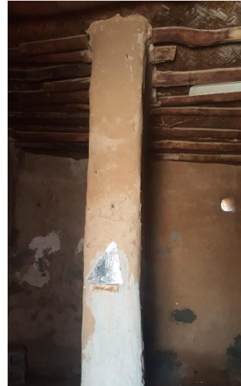
Şekil 4.21 Ahmet Ali Evi solda yangöz tavan örüntüsü görüntüsü ve sağda dör biriminde yer alan dinge görüntüsü.
