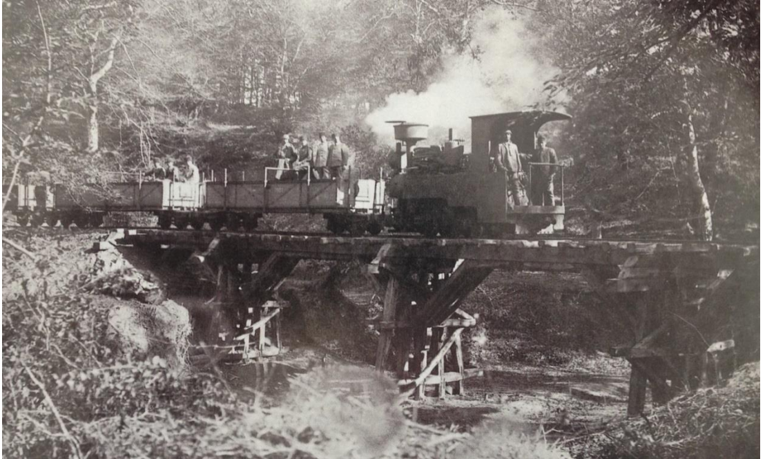
Resim 4.34 Kemberburgaz-Çiftalan Şubesi Üzerinde Ahşap Köprü (Irmak, 2011)
