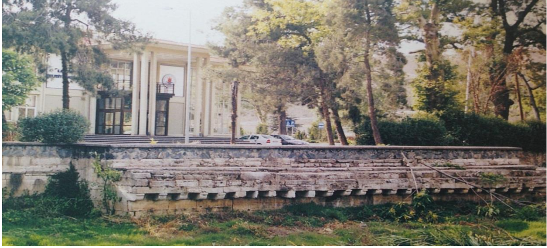
Resim 4.11 Çadır Köşkü'nün 1996'da Çıkarılan Temel Kalıntıları 2001 (Irmak,2014)
