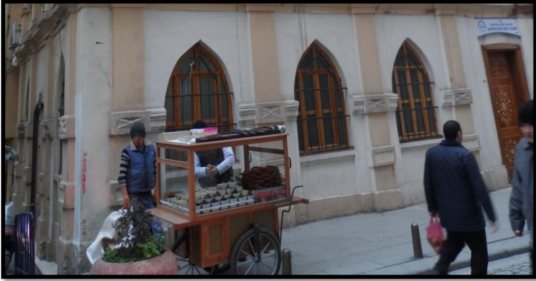
Şekil 3.72: Doğu cephesinde bulunan sivri kemerli pencerelere sonradan eklenmiş demir parmaklıklar.
