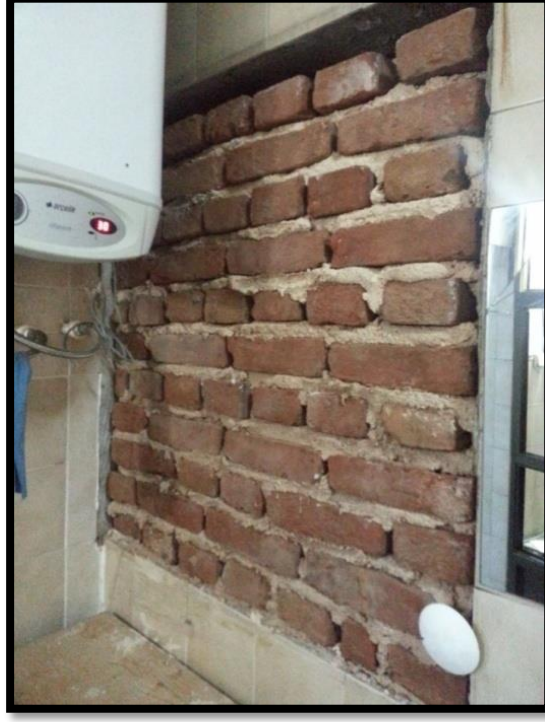
Şekil 3.80: Zemin kat son cemaat alanı batı duvarında bulunan işlevini yitirerek kapatılan kapı boşluğunun şadırvan tarafından görünüşü.
