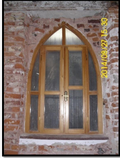
Şekil 3.46: Zemin kat DV1-P1 kodlu sivri kemerli pencere iç görünüş.
