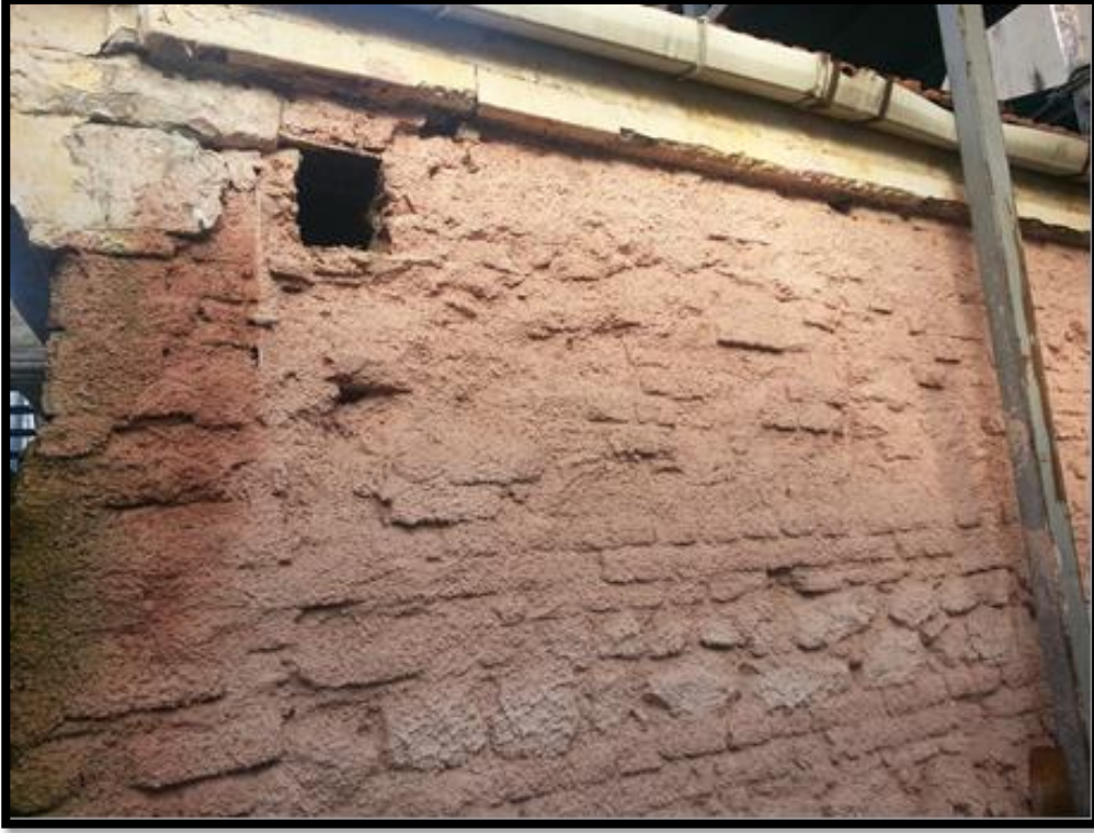
Şekil 3.75: Kuzey cephesinde havalandırma amacıyla açılmış havalandırma penceresi.
