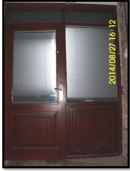
Şekil 3.41: Zemin kat giriş holü görevli yeri kapısı K3 numaralı kapı iç görünüş.
