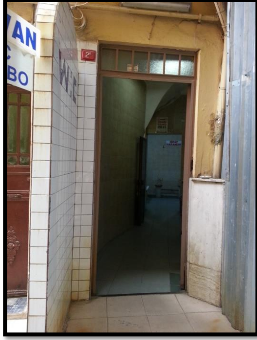
Şekil 3.44: Güney cephesi şadırvan ve tuvalet giriş kapısı.
