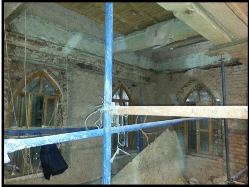
Şekil 3.25: N01 Birinci kat döşemesi döşeme kirişleri.(08/2014)
