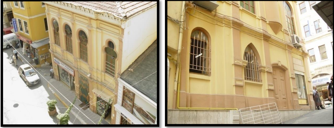
Şekil 5.5: Şahsuvar bey Camii'nin dükkânlara kiraya verilerek bölünmüş doğu cephesi.
