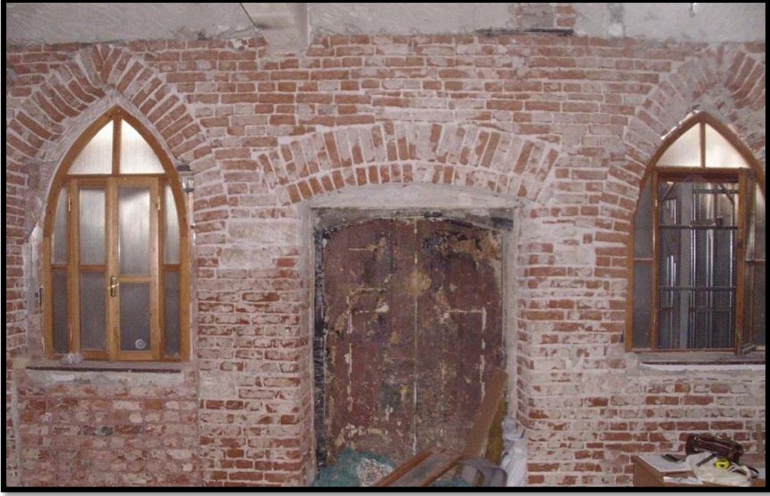
Şekil 3.8: Zemin kat son cemaat alanı güney duvarı.
