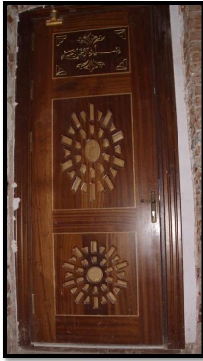
Şekil 3.37: Doğu cephesi giriş kapısı, DV1 K1 numaralı kapı iç görünüş.
