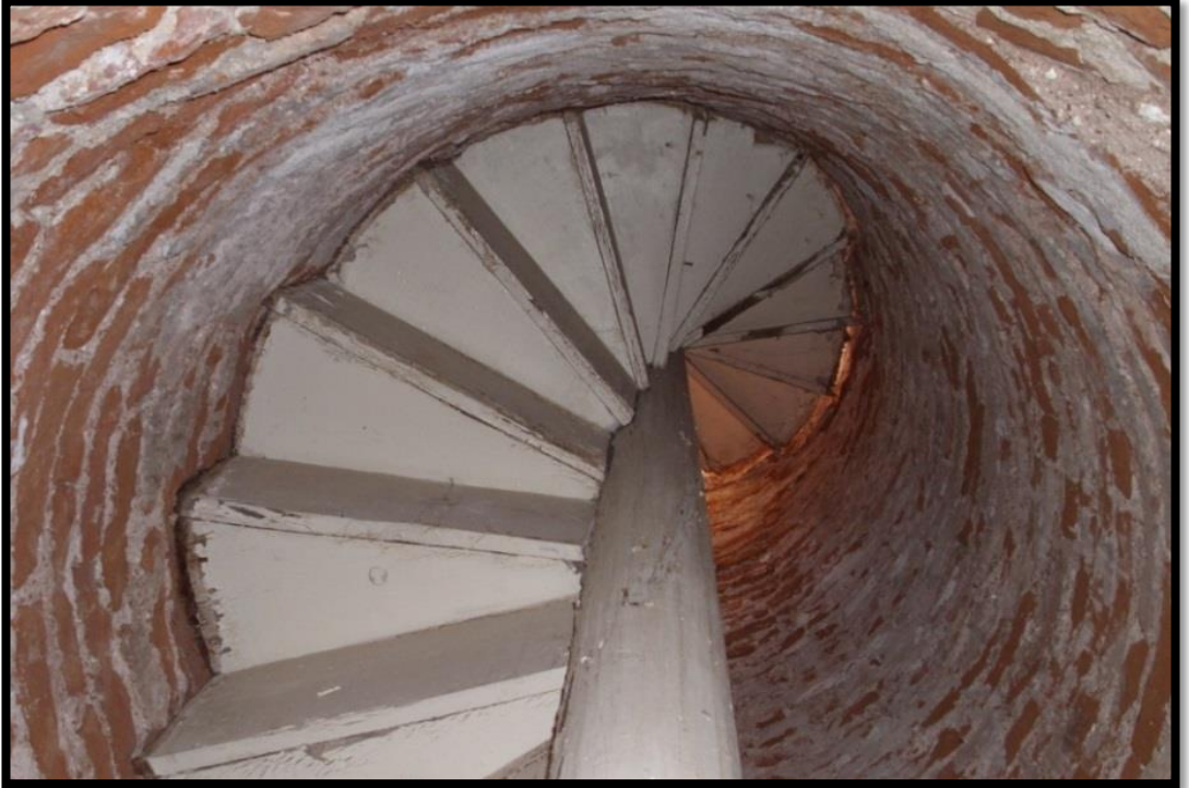
Şekil 3.19: Minare çıkış merdivenleri.
