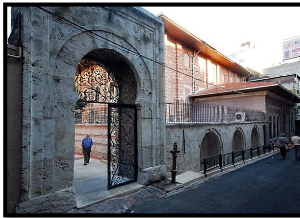
Şekil 4.25: Arap Camii'nin kuzey cephesinde bulunan yapı ve avlu giriş kapısı.
