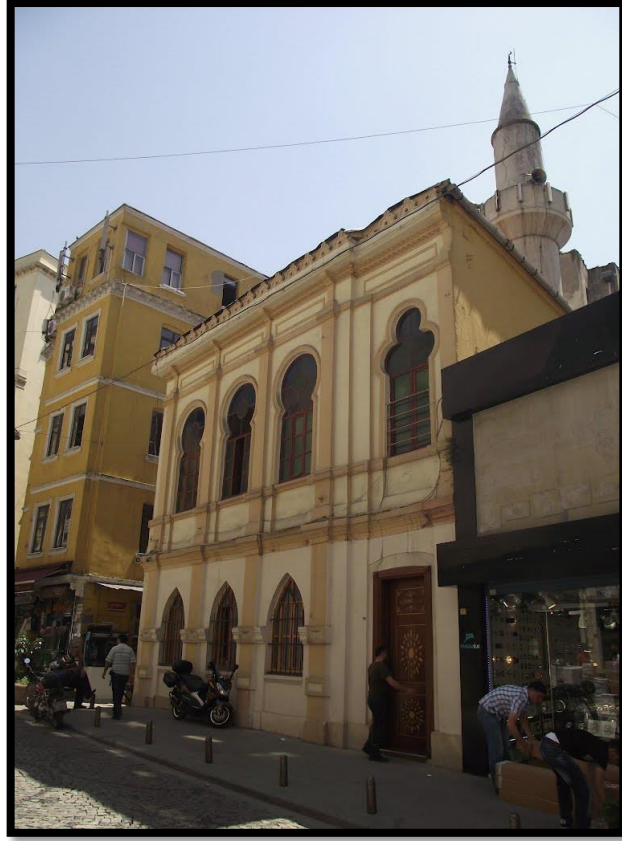
Şekil 3.2: Şahsuvar Bey Camii Doğu Cephesi.
