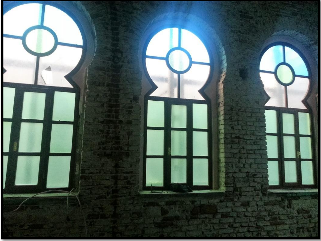
Şekil 3.74: Birinci kat mescit alan at nalı kemerli pencerelerin arasında tesisat nedeniyle oluşan tuğla duvardaki kütle kaybı.
