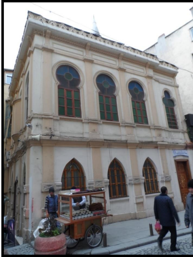
Şekil 3.1: Şahsuvar Bey Camii Doğu Cephesi.
