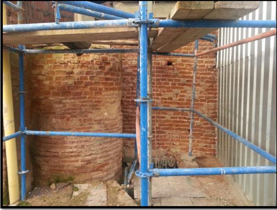
Şekil 3.65: Batı Minare duvarı.
