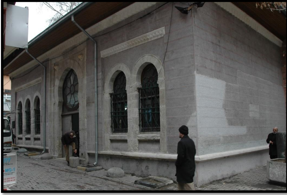
Şekil 4.26: Arap Camii'nin kuzey cephesinde bulunan yapı.
