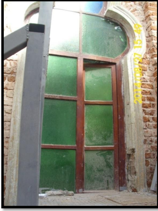
Şekil 3.49: Birinci kat DV1-P1 kodlu yonca kemerli ahşap pencere iç görünüş.
