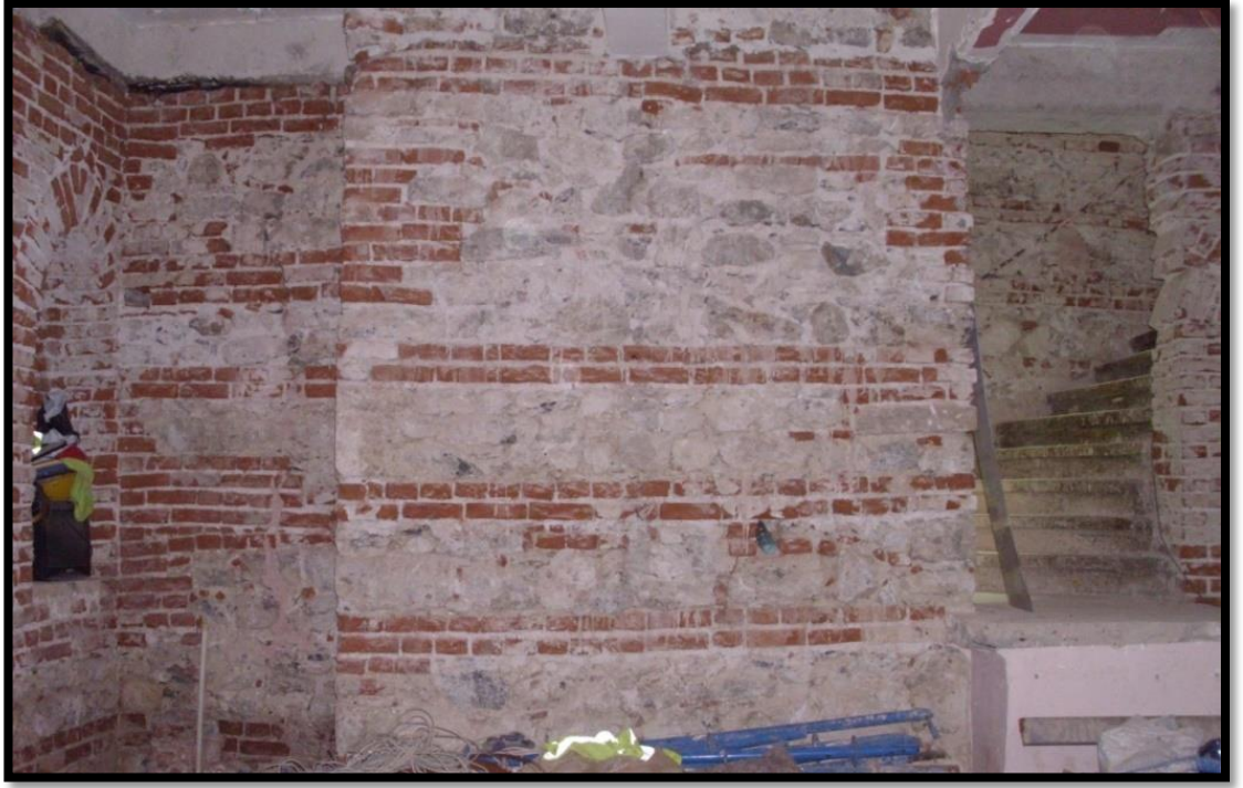
Şekil 3.10: Zemin kat son cemaat alanı kuzey duvarı.
