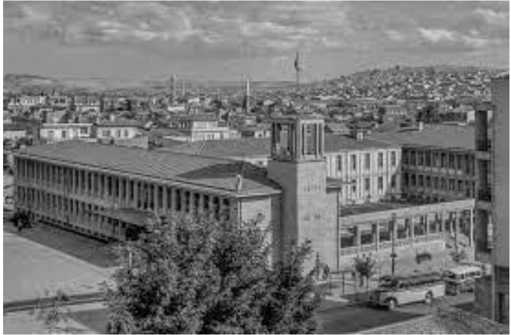
Resim 57. Gaziantep Hükümet Konağı, 1956 (URL-52)
