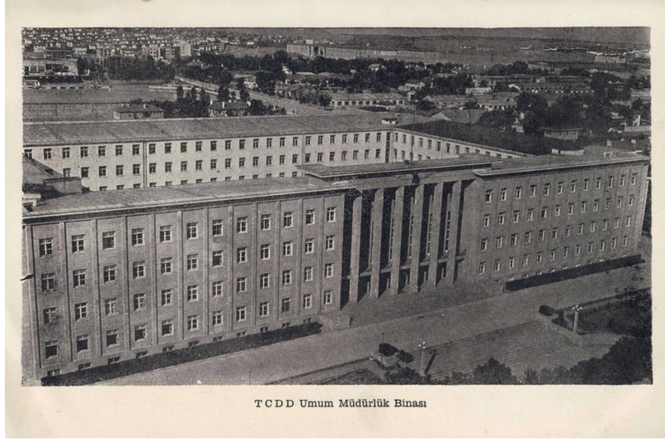
Resim 35. TCDD Umumi İdare Binası, Ön Cephe Görünüşü, Ankara, 1941 (URL-33)
