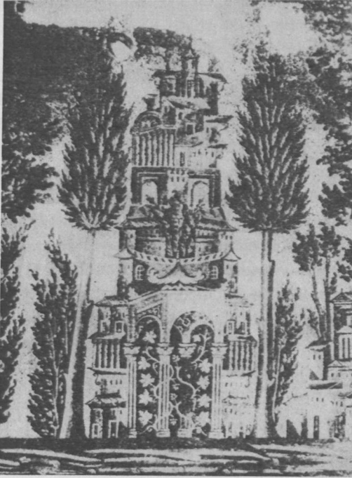
Şam Ümeyye Cami batı revakındaki pano
