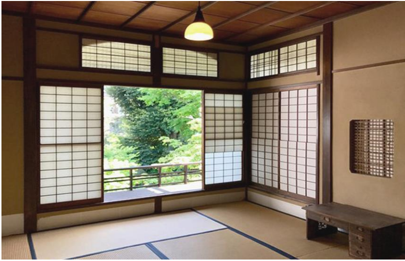
Resim 5.15 Geleneksel Japon Evi'nde kapı ve pencere vazifesi gören shoji (URL-41)
