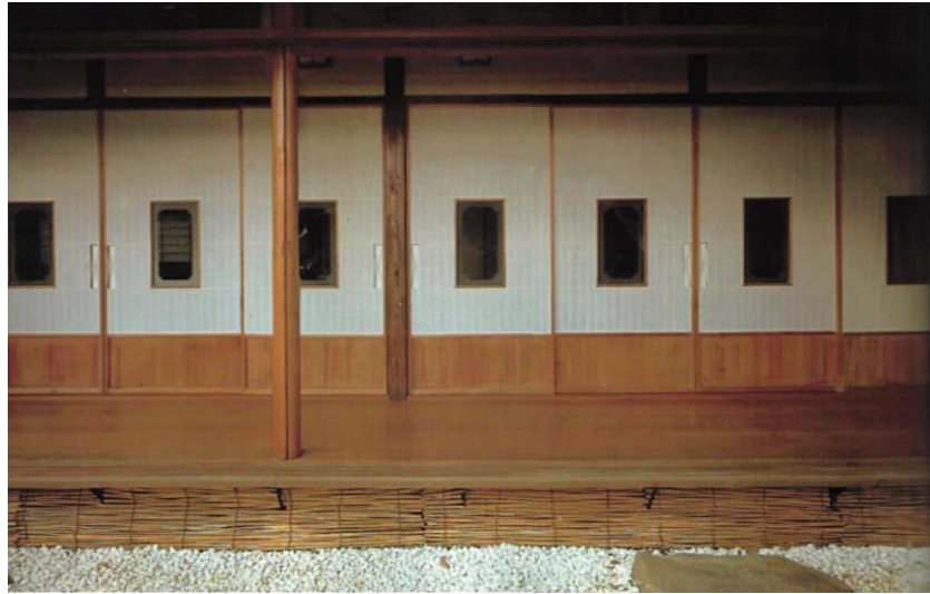
Resim 4.25 Geleneksel Japon Evi'nde duvar vazifesi gören fusuma (Yagi, 1986)
