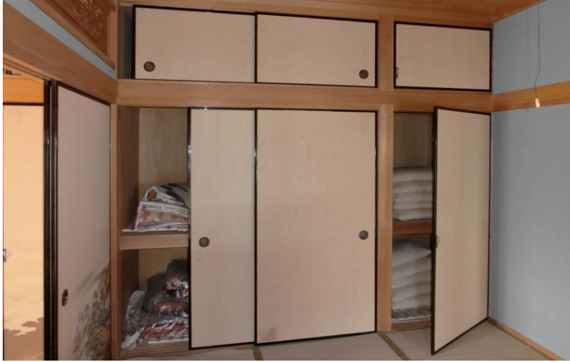
Resim 4.15 Yüklük ve dolap olarak kullanılan oshiire (URL-26)
