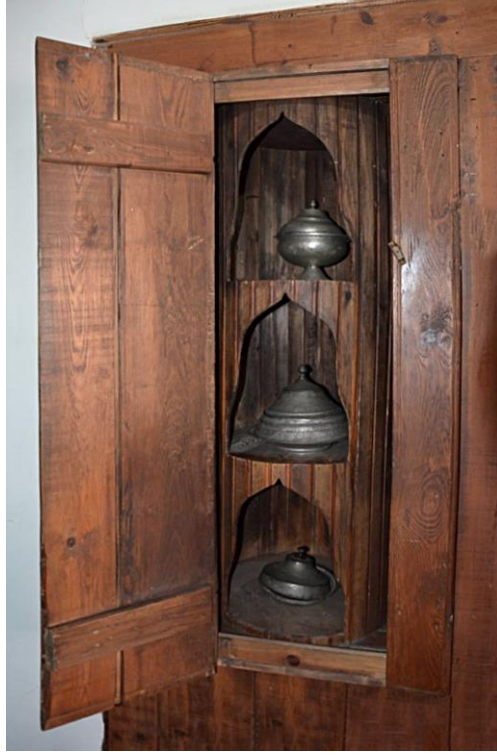
Resim 3.7 Harem ile selamlık arasında servis sağlayan dönme dolap (URL-3)
