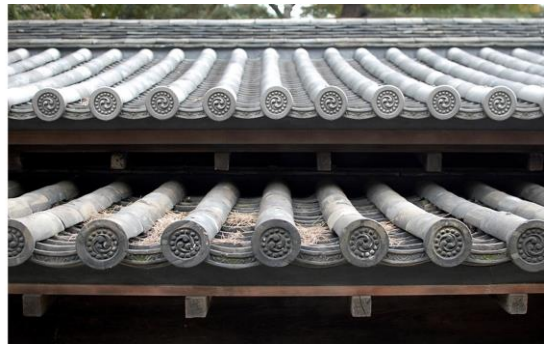
Resim 4.28 Kiremit örtülü çatı (URL-35)
