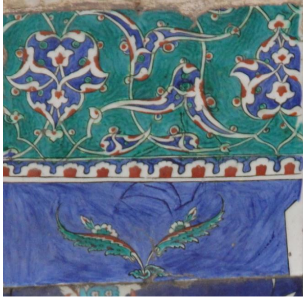
R.296: Soncemaatte dokuzuncu pencere alınlık bordüründe sol üst köşeye yakın yerde eksilen çini 16. yüzyıl İznik çinisi ile tamamlanmıştır.
