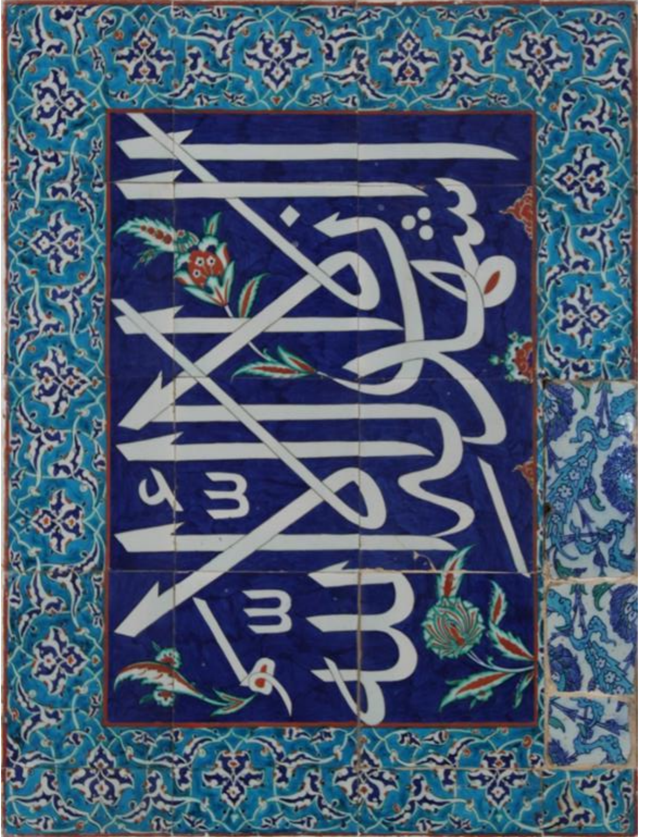
R.68: Üçüncü Pencere Üstü Çini Pano: “Eşhedüenlâilâhe illallah” (Kelime-i Şahadet) Yazılı Panonun Alt Sol Bordür Çinilerinden Bir Kısım Çalınmış ve Yerine Aynı Dönem ve Üslubda Olmayan Çini Parçalarıda Yerleştirilmiştir. Dikdörtgen Formu, 23/24.5x25 cm ölçülerinde 13 tam karo olup eni: 1.05 cm, boyu: 0.84 cm. ve Bordürün Sol Alt Tarafı Enine ve Boyuna Çeyrek Karolar İle Tamamlanmıştır. Burada Sol Alt Tarafı Farklı Renk ve Motifler İle Tamamlama Yapılmıştır. Bordürün Köşe Dönüşleri Diğerlerinden Farklıdır.
