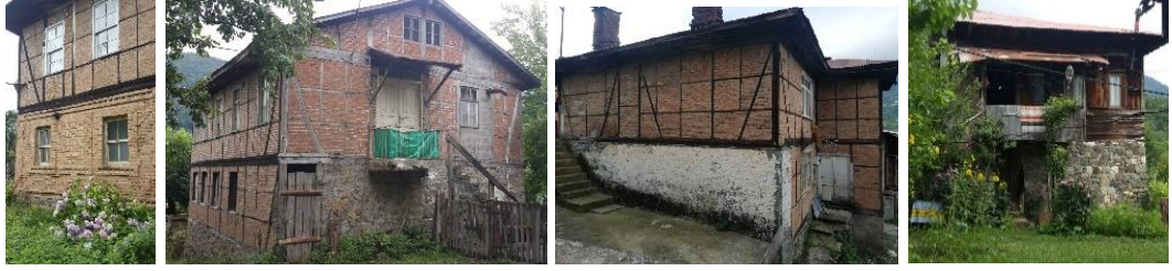
Şekil 161 Geleneksel Karadeniz Artvin bölgesindeki evlerin cephe görünümleri. (Hanedar Arşivi, 2021)
