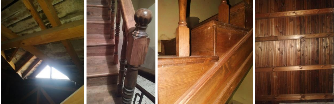
Şekil 189 Binaya ait çatı iskelet sistemi, merdiven basamak, korkuluk ve yanakları, taşap tavan kaplaması detayları. (Hanedar Arşivi, 2021)
