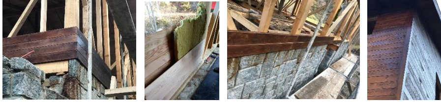
Şekil 165 Geleneksel Karadeniz evi ahşap duvar uygulama aşaması ve cephe görünümleri. (Ünal Karaman Evi: Hanedar Arşivi, 2021)
