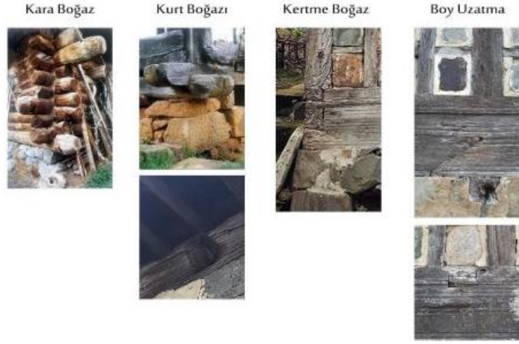
Şekil 73 Doğu Karadeniz kırsal mimarisinde ahşap birleşim detayları. (Pınar, 2018, s:63) 33 , (URL 206)
