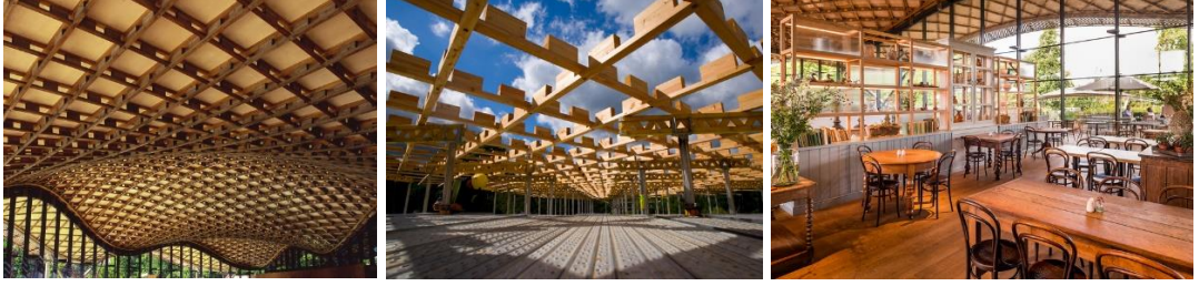
Şekil 158 Konstrüksiyon ve çatı kabuk sistemi bütünüyle ahşap parçaların birbirine geçmesi ve birleştirmeleriyle oluşturulmuştur ve restoraniç mekânında zemin kaplaması ile mobilya üniteleri ahşaptan üretilmiştir.(URL 203, URL 204)
