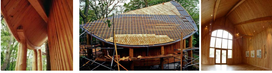
Şekil 154154. Geleneksel yöntemlerle destekleyici kolonlar, çatıuygulaması ve iç mekândan genel görünüm.(URL 195, URL 196, URL 197)
