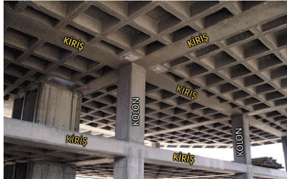
Şekil 11 Kolon ve kirişlerin en yalın haline örnektir. (URL 8)
