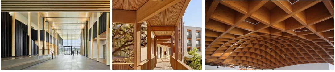
Şekil 71 Kolon, kiriş ve tavan yüzeylerinde ahşap kullanımı ve İstanbul Avcılar Nikâh Dairesi Eğrisel Lamine malzemenin kullanıldığı ahşap kirişler. (URL 107)
