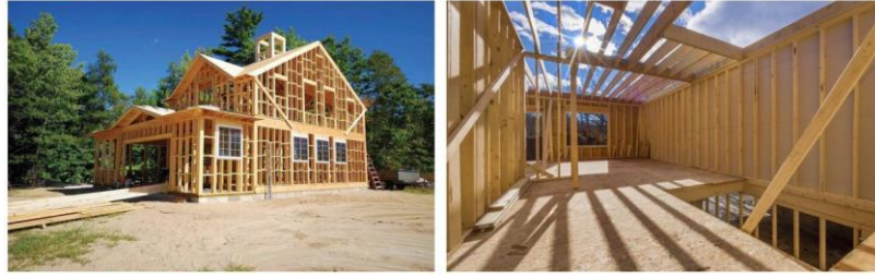
Şekil 75 Ahşap yapıda dikey taşıyıcı elemanlarda ahşap kullanımı.(URL 109)
