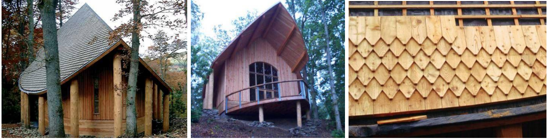
Şekil 153 Douglas Pavilion’u dış görünüm, seyir terası ve çatı kaplaması detayları. (URL 192, URL 193, URL 194)
