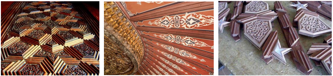
Şekil 131 Bursa Ulu Camii Kündekâri detayı, Bursa Muradiye Külliyesi Kündekâri saçak detayı, Kündekâri geçmelerinin birleşim aşaması.(URL 107, URL 108, URL 109)
