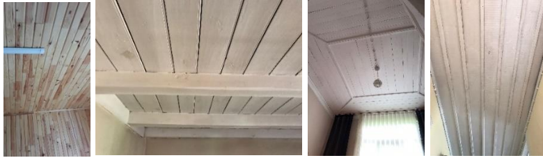
Şekil 166 Tavanlardaki lambri kaplamaları ve farklı geçme sistemleri.(Servet Kahraman Evi: Hanedar Arşivi, 2021)
