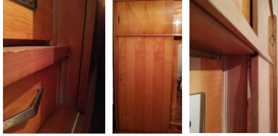
Şekil 186 B.H. Evi formika malzemeden kaplı ahşap sürgü kapalı gardırop detayı. (Hanedar Arşivi, 2021)
