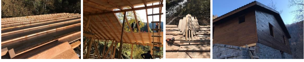
Şekil 164 Geleneksel Karadeniz evi ahşap çatının uygulanma aşaması ve tamamlanmış görünümleri. (Ünal Karaman Evi: Hanedar Arşivi, 2021)
