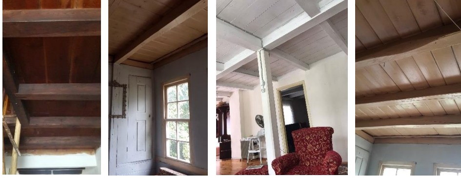
Şekil 169 Kolon-kirişte ahşap kullanımlarına örnekler.(Servet Kahraman Evi: Hanedar Arşivi, 2021)
