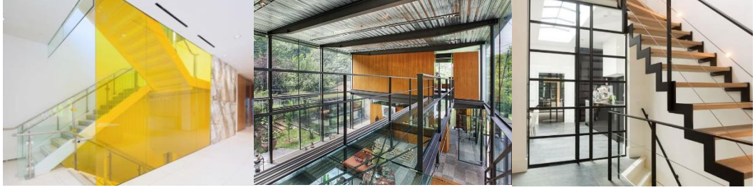
Şekil 57 Akustik özellikli cam yüzey, Alataş Mimarlık tasarımı olan Uşaklıgil Evi'nde cam ve çelik malzemenin kullanımı, Çelik ve cam malzemenin kapı ve merdivendeki kullanımı. (URL 91, URL 92, URL 93)
