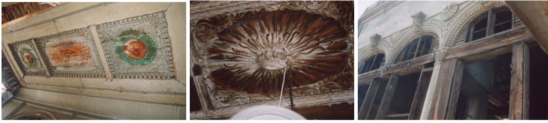
Şekil 141 Camcıoğlu Evi Ahşap tavan süslemesi, İ.Akdağ Evi-Tavan ahşap süsleme detayı, Camcıoğlu Evi- Köşkü Ahşap taç süslemesi-cephe-kolon ve pencere doğrama detayları. (Tali, 2010, s:85) 82 , (Tali, 2010, s:82) 83 , (Tali, 2010, s:84) 84 ,(URL 206)
