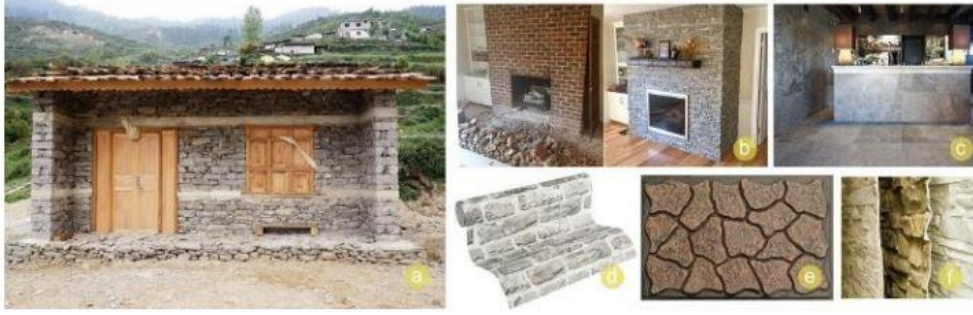
Şekil 58 a) Nepal’de bir taş yapı örneği (LE Village Noir, 2013), b)Yüksek yoğunluklu poliüretan malzemeden üretilmiş duvar panelleri, c)İç mekânda taş görünümlü seramik (LaGare Hotel), d)Kağıt duvar kaplaması, e)Taş görünümlü plastik, f)MSD Panel Sistemleri. (Yıldız, Seçkin, 2019, s:9) 30 , (URL 206).
