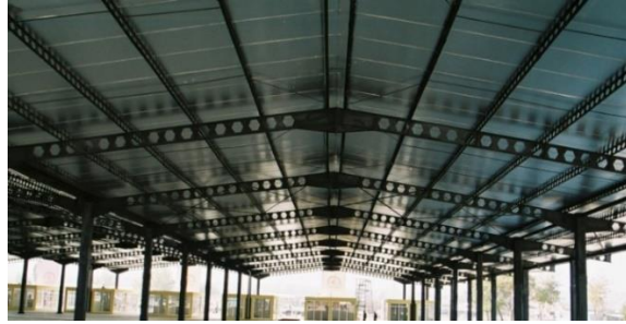
Şekil 8 Çelik malzeme ile üretilmiş petek kiriş görünüm. (URL 4)
