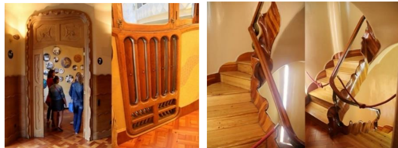
Şekil 152 Merdiven korkulukları, iç mekân ve dış cephe doğramaları estetik biçimde şekil verilerek ahşap malzeme dokusuyla birlikte donanım elemanı olarak kullanılmıştır. (URL 191)
