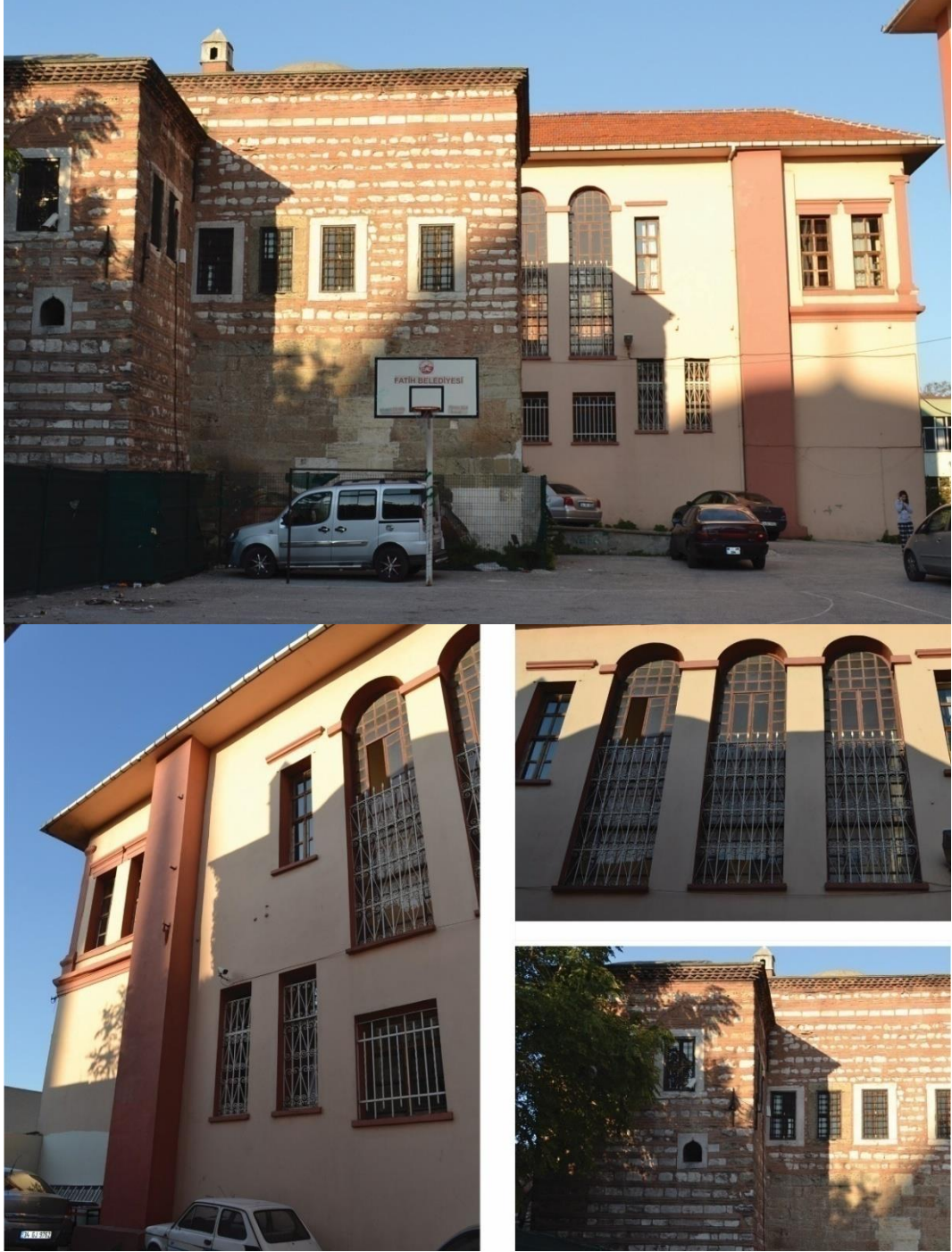
Şekil 37 : Vefa Lisesi güneybatı cephesi
