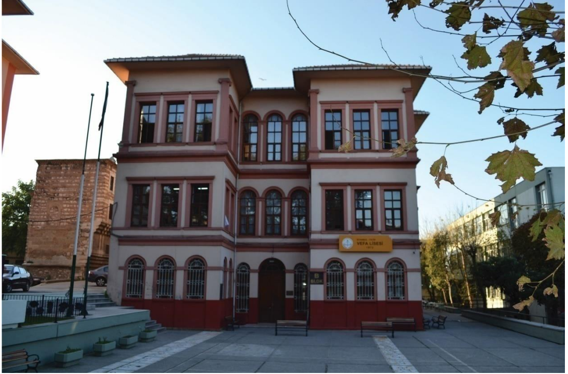
Şekil 31 : Vefa Lisesi güneydoğu cephesi
