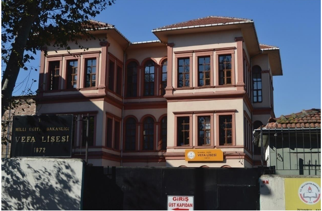
Şekil 32 : Vefa Lisesi güneydoğu cephesi
