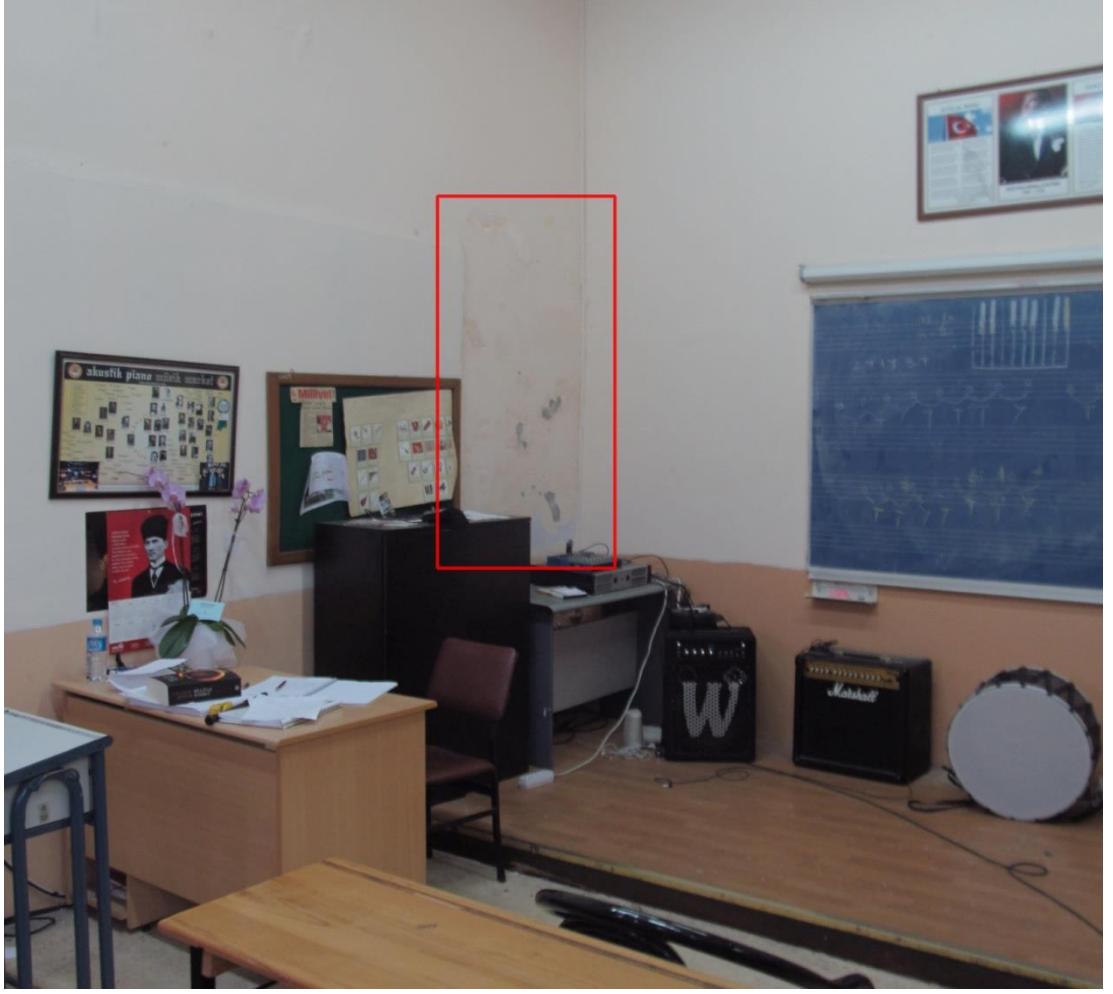
Şekil 47 : Müzik odası nem altındaki duvardan bir kesit
