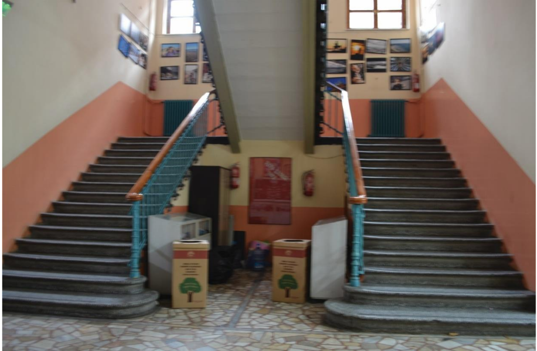
Şekil 43 : Zemin kat - Merdivene bakış
