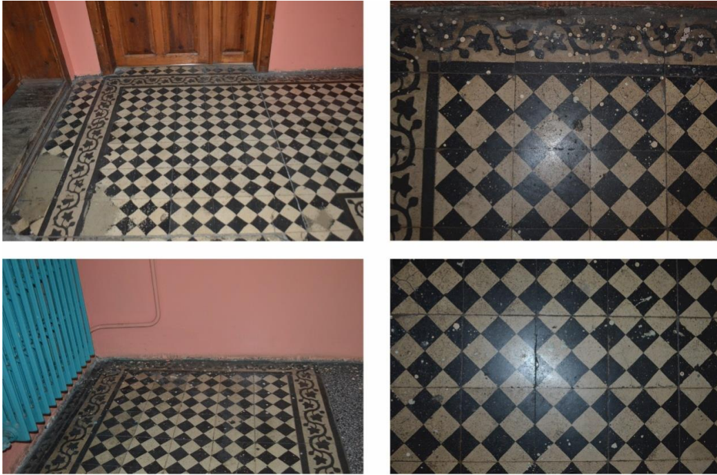
Şekil 39 : Karosiman döşeme kaplaması
