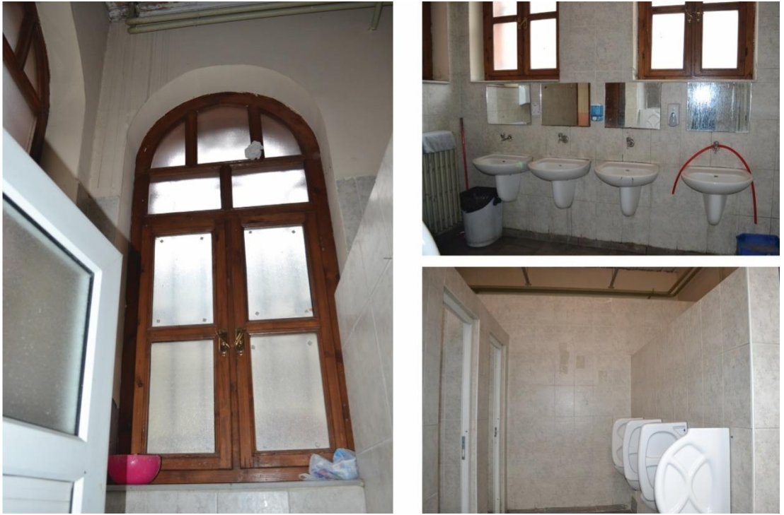
Őekil 12 : Zemin kat - (Z 05) Erkek öđrenci tuvaleti
