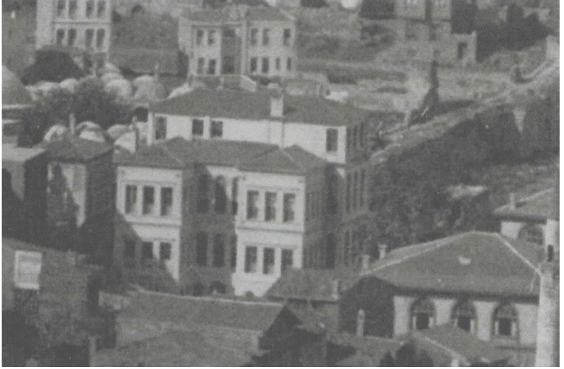
Şekil 57 : Beyazıt Kulesinden çekilen bir panoromada Mütercim Rüşdü Paşa Konağı ve çevresi
