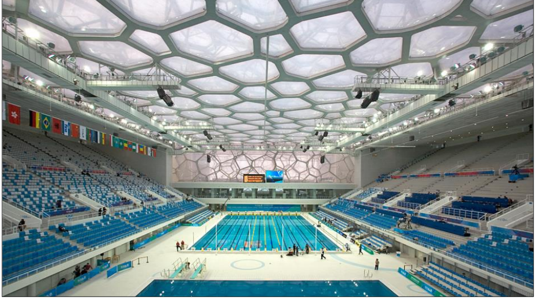
Resim 5.16: Ulusal Su Sporları Merkezi yapısının ETFE yastık kaplı çatısından içeriye giren doğal aydınlatma (Url-84).
