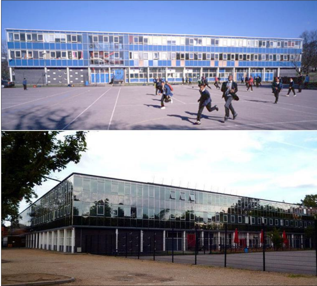
Resim 5.22: Üst görselde Kingsdale Okulu'nun yenilenmeden önceki hali, alt görselde yenilenmeden sonraki hali (Url-91),(Url-92).
