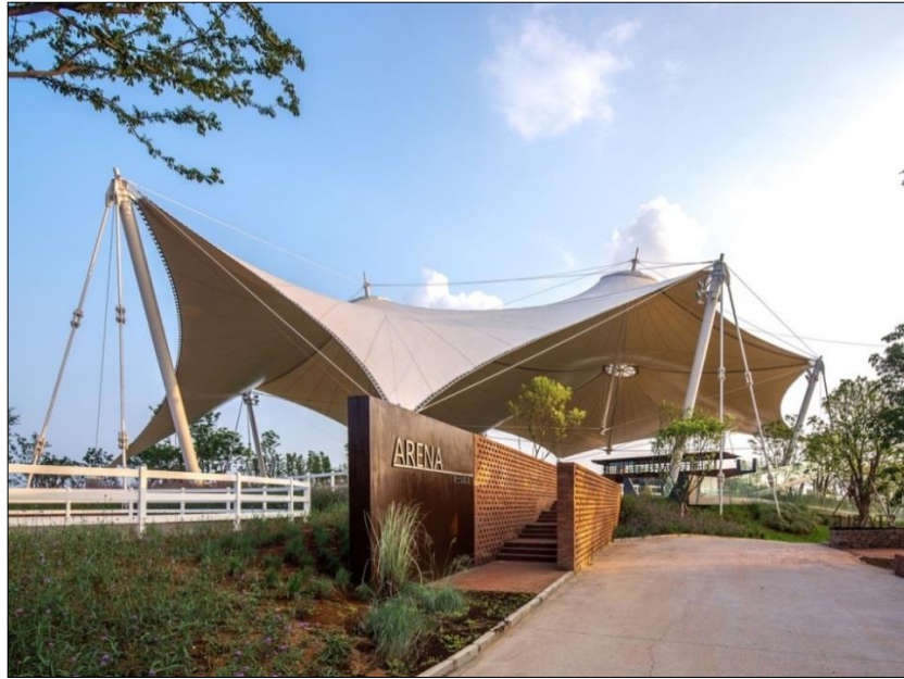
Resim 1.12: Luxes Island Saddle Club, sınırlı gerilmiş asma germe yapısı, Çin (Url-13).
