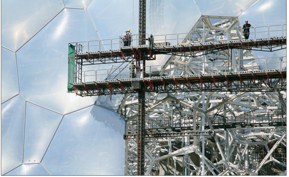
Resim 5.15: İnşaat halindeki Ulusal Su Sporları Merkez yapısına ETFE yastıkların montajı sırasında (Uri-85).
