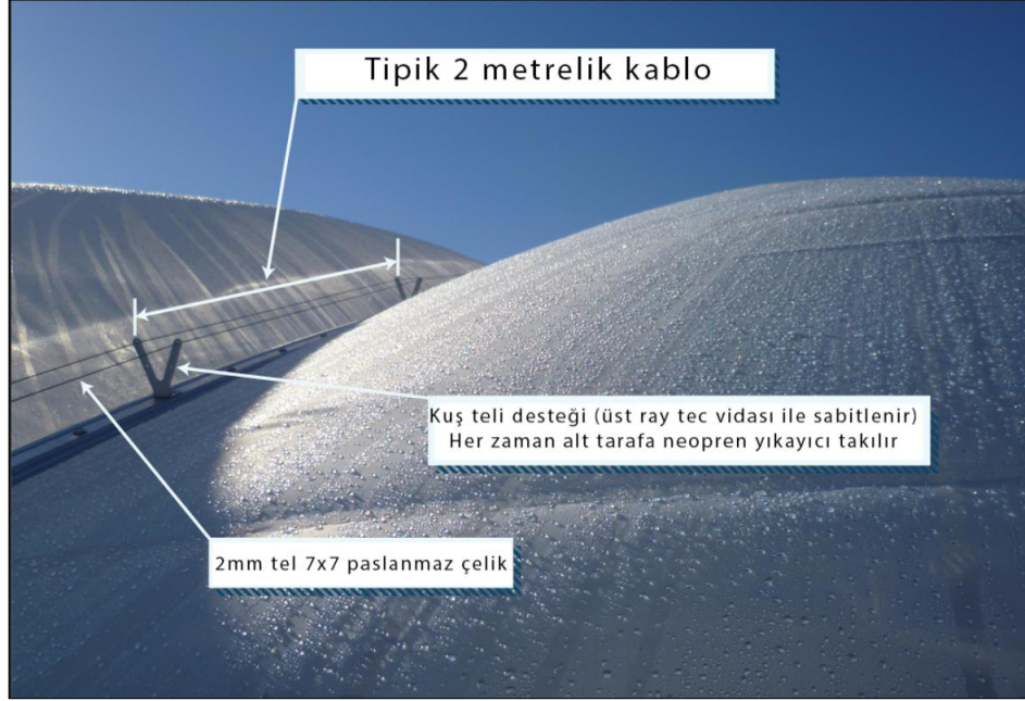
Resim 3.8: ETFE yastık birleşim profili üzerindeki kuş kovucu tel örneği (Url-47).
