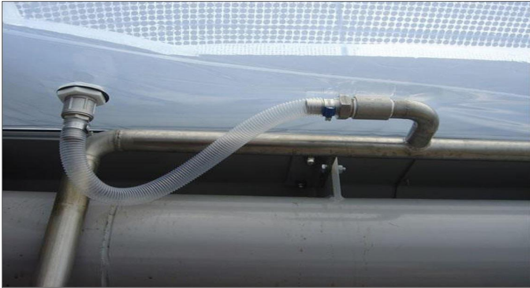
Resim 3.3: ETFE yastığa havalandırma boru bağlantısı (Bessel, 2012).
