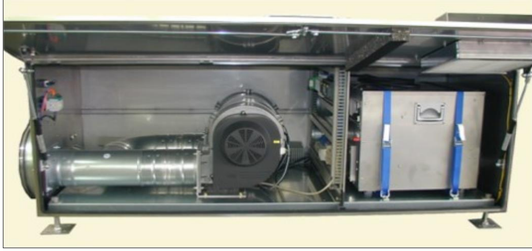
Resim 3.2: ETFE yastıklar için kullanılan hava üfleme makinesi örneği (Url-31).
