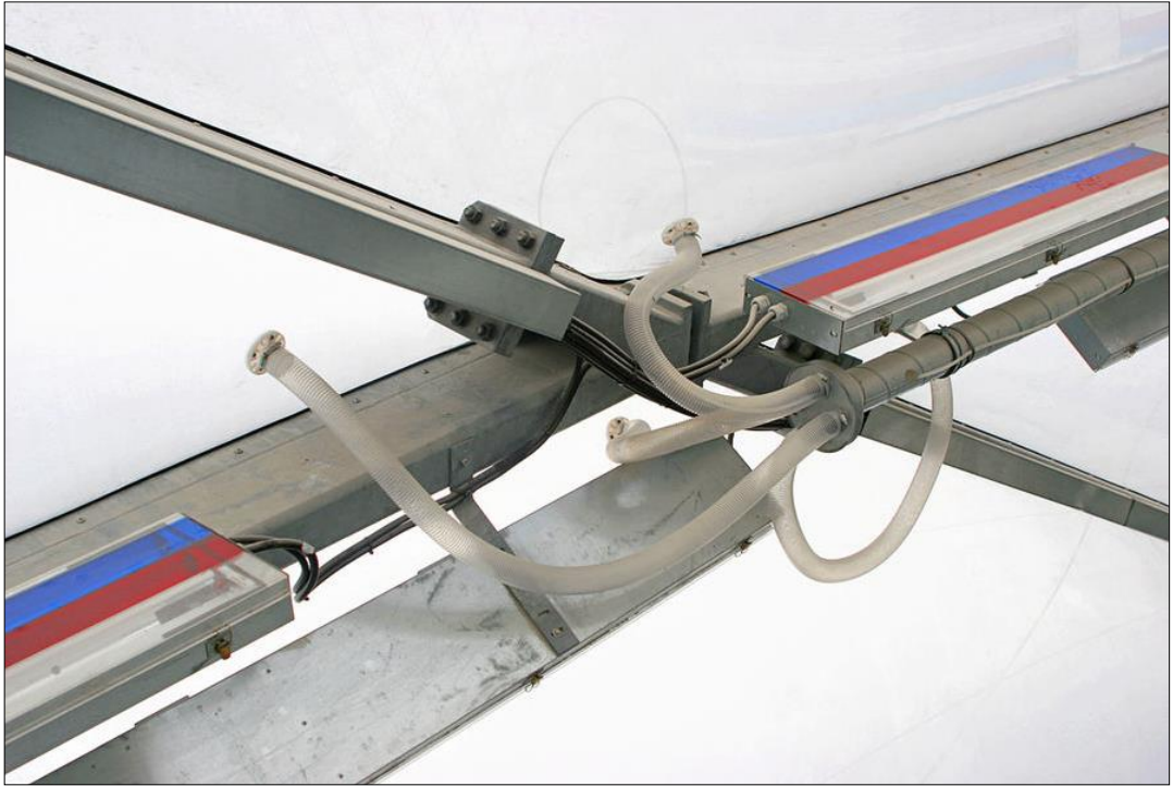
Resim 5.10: ETFE yastıkları şişiren hava borularının yakın çekim görseli (Url-80).
