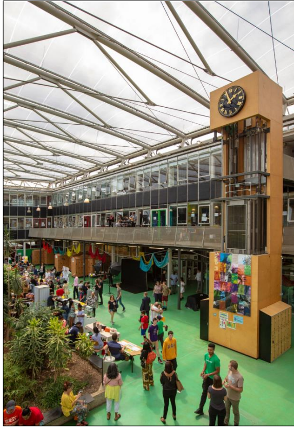
Resim 5.29: Kingsdale Okulu ETFE yastık kaplı sıralı çatısı (Url-91).
