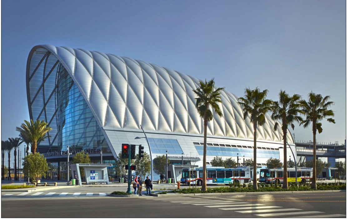
Resim 4.24: Diyagrid çerçeve ve kemer formundaki ETFE folyolardan meydana gelen ARTIC binası, Los Angeles (Url-70).
