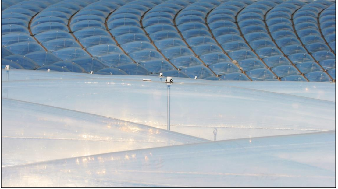
Resim 5.4: Allianz Arena'nın ETFE çatısına yakın çekim görseli (Url-73).
