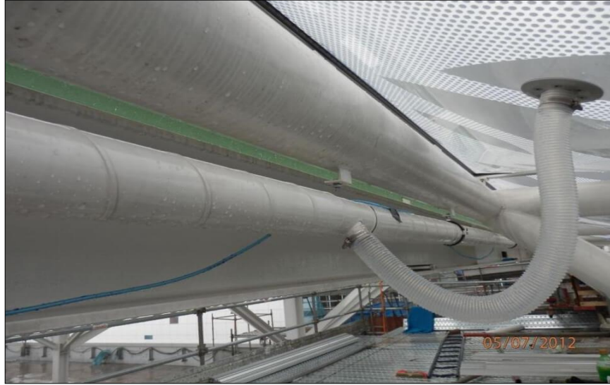
Resim 3.4: ETFE yastıkların havalandırma borularına bağlantısı (Url-31).
