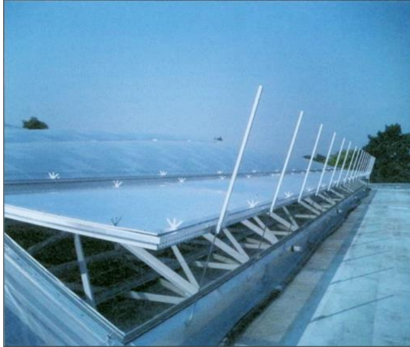
Resim 5.26: Kingsdale Okulu avlusundaki ETFE yastıklı havalandırma kapakları (Url-90).
