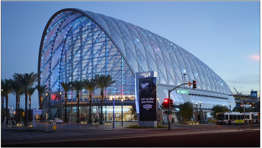
Resim 4.21: Kemer çatı formundaki ETFE yastıklarla ARTIC yapısı, Los Angeles (Url-69).
