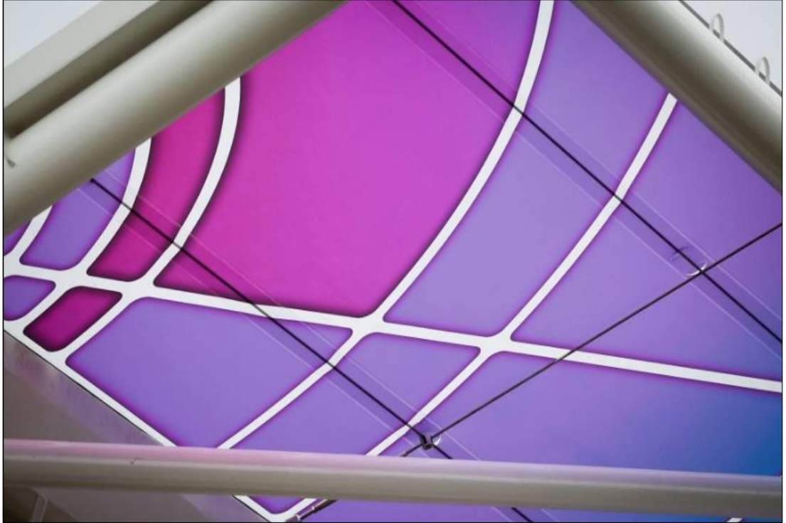
Resim 5.32: ETFE folyo altındaki destek gerilim kabloları (Url-98).
