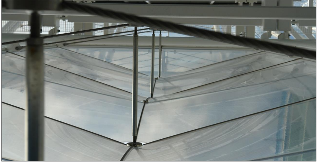
Resim 4.26: Kablo gerdirme destekli ETFE folyolar, Unilever Merkez Binası, Hamburg (Url-72).
