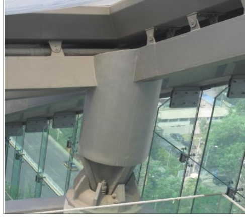
Resim 4.19: Basit bilyeli, soket bağlantısının yakın çekimi (Bessey, 2012).
