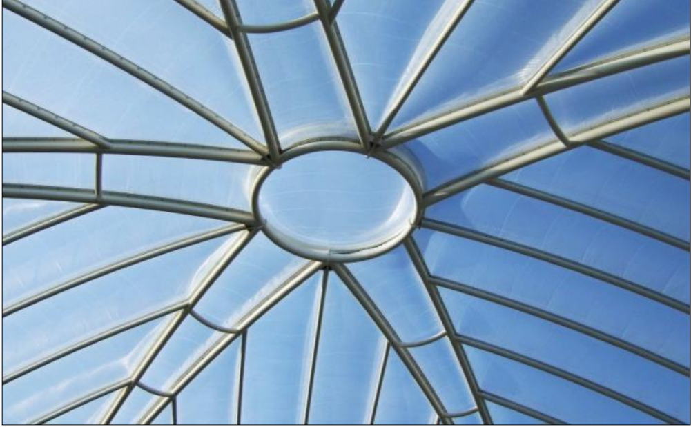
Resim 4.2: Kuzey Swindon Okulu ETFE kubbe çatı uygulaması (Url-51).
