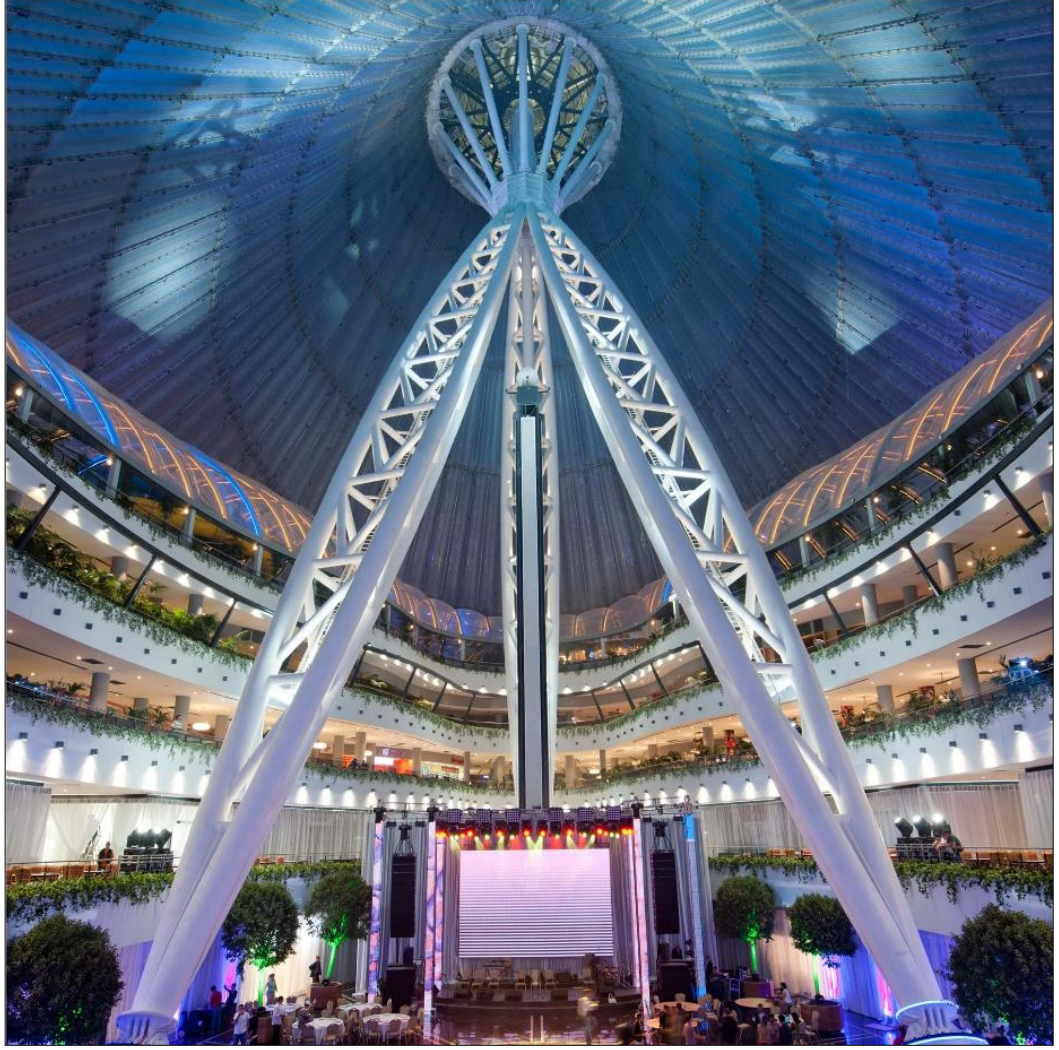
Resim 4.14: Han Çadırı'nın ana taşıyıcısı olan üçayak kulenin içeriden görünümü (Url-61).
