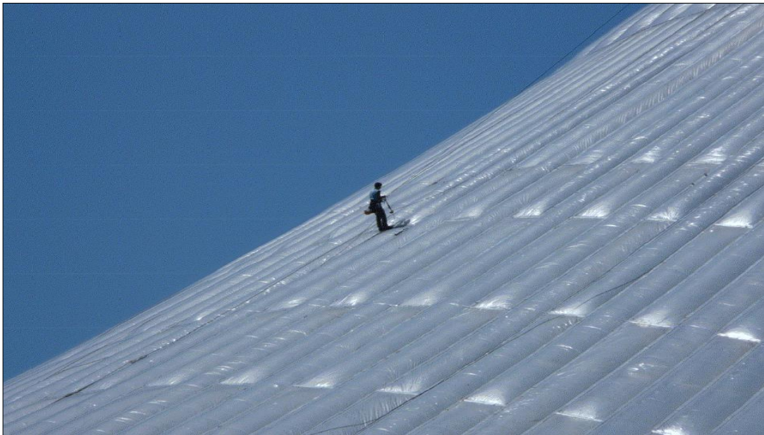
Resim 4.13: Han Çadırı'nda ETFE yastıklarının yerleşimi ve kontrol aşaması (Url-63).
