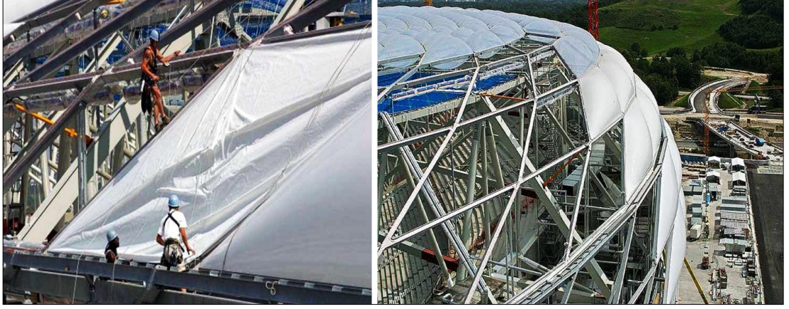
Resim 5.6: Allianz Arena'daki ETFE folyoların karkas sistem üzerindeki raya sıkıştırma işlemleri (Url-74).
