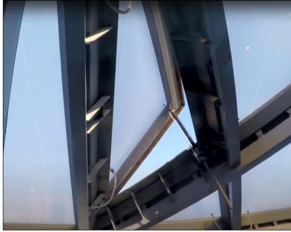
Resim 4.17: Parkview Green Plaza kabuk yapının çalıştırılabilir havalandırma şaftı (Url-68).
