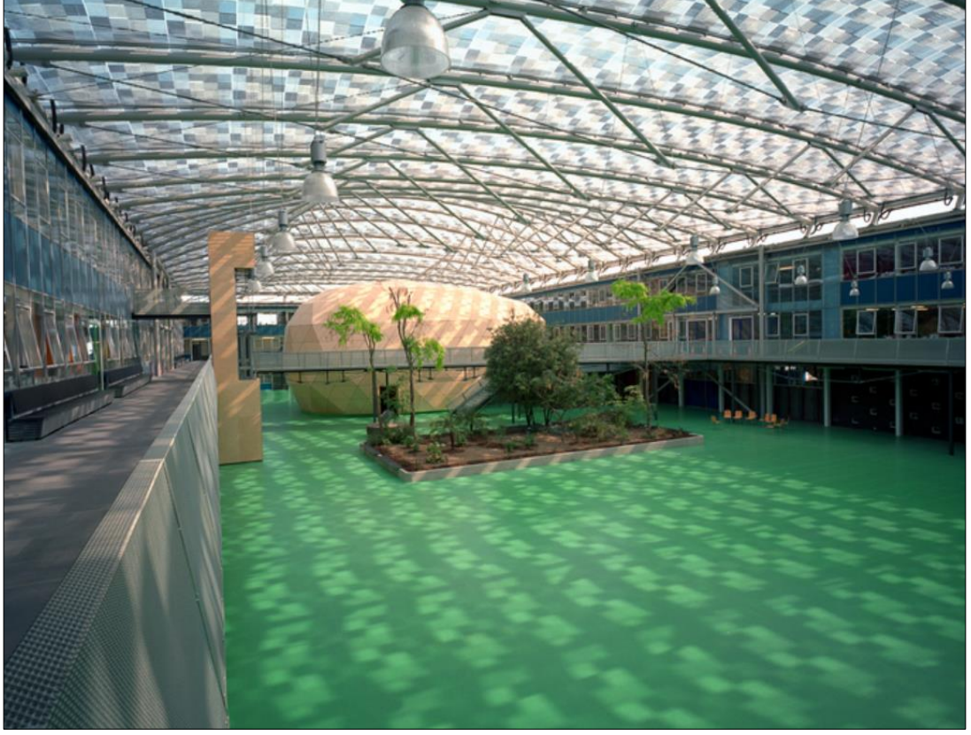
Resim 5.24: Kingsdale Okul avlusunda ETFE folyoların yarı ışık geçirgen davranışı görseli(Url-94).
