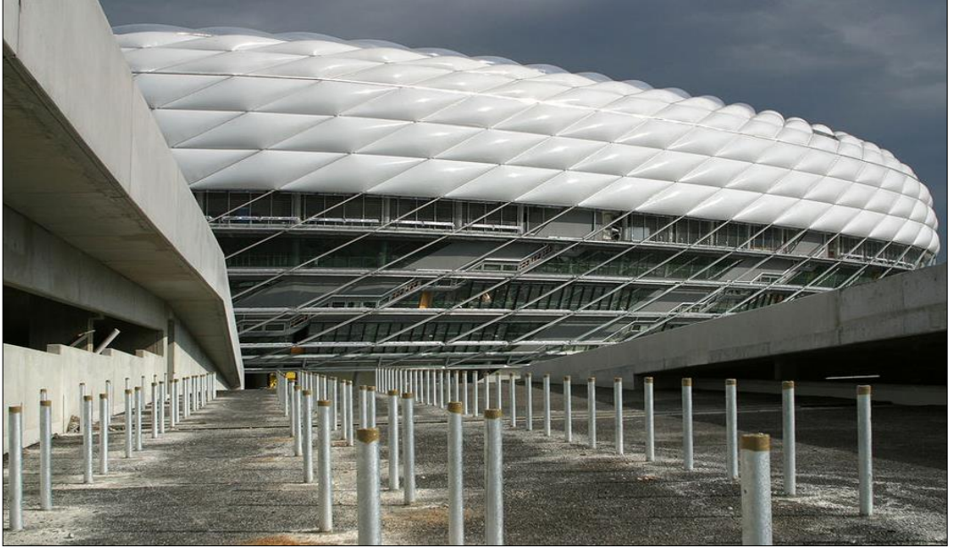
Resim 5.7: Allianz Arena Stadyumu'nun giydirme ETFE cephe sistemi montaj aşaması (Url-74).
