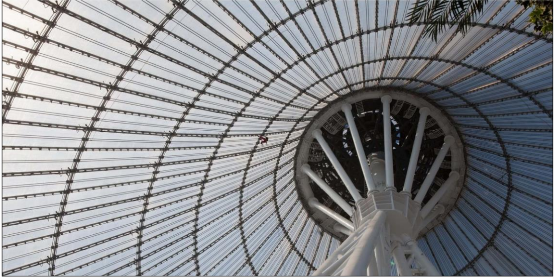
Resim 4.12: Han Çadırı'nın içerden ters koni şeklindeki hub halkanın görseli (Url-61).
