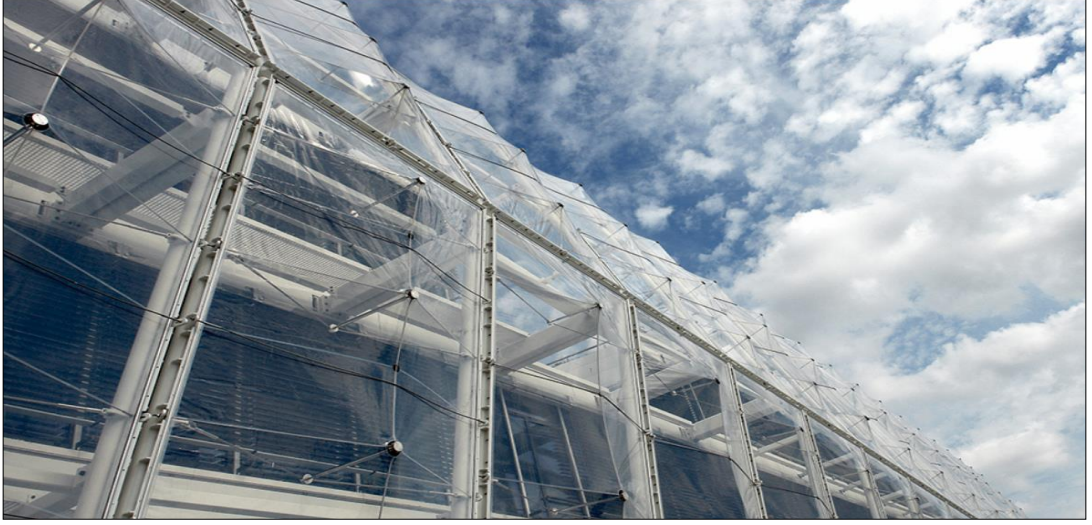
Resim 4.27: Kablo destekli ETFE folyo panellerin aşağıdan görünümü (Url-72).
