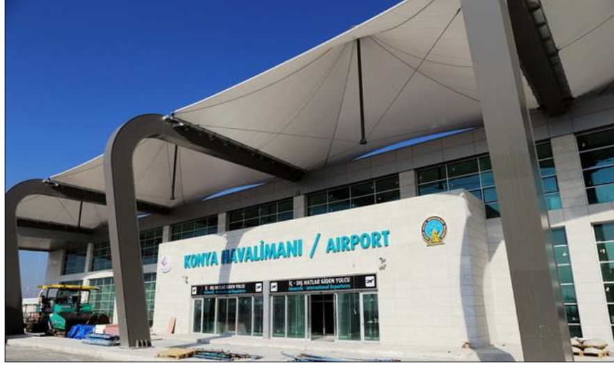
Resim 2.2: İçten askılı uçan kolon model örneği, Konya Havalimanı (Url-18).
