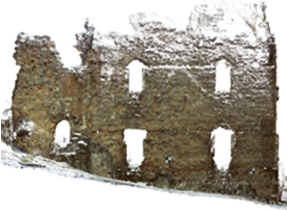
Şekil 2. Optik ve scanner sistem ile yapının ölçümü.
