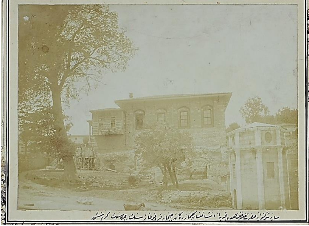
Görsel 176 Komutanlık Binası Güney-Batı cephe görünümü ve altında bulunan Erken Bizans Dönemi Sarnıç girişi, 1930 276
