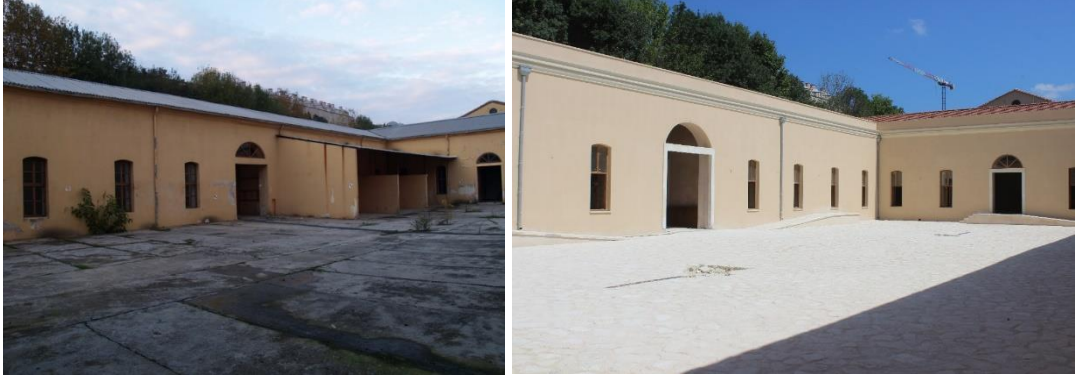
Görsel 160 Eski Askeri depolar, uygulama öncesi (solda), uygulama sonrası (sağda), (Öcal, 2016)
