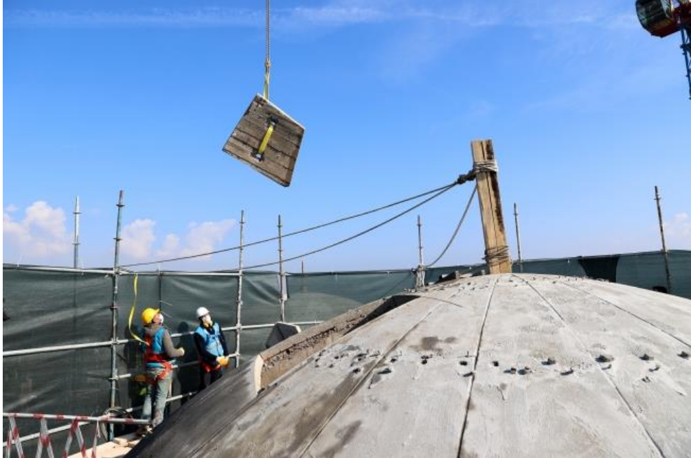
Görsel 44 Fatih Köşkü betonarme kubbelerinin onarımı, 2021 96
