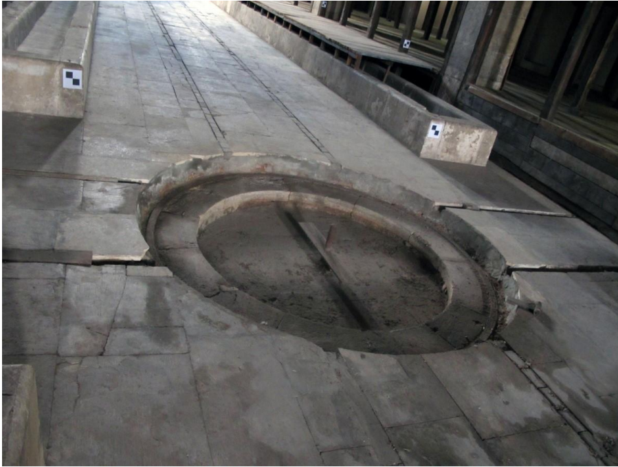
Görsel 155 3 nolu depo içerisinden fotoğraf, 2015 (Öcal) (Fotoğrafta tren hattına ait ray izleri ve ortada makas değişim merkezi görülmektedir.)
