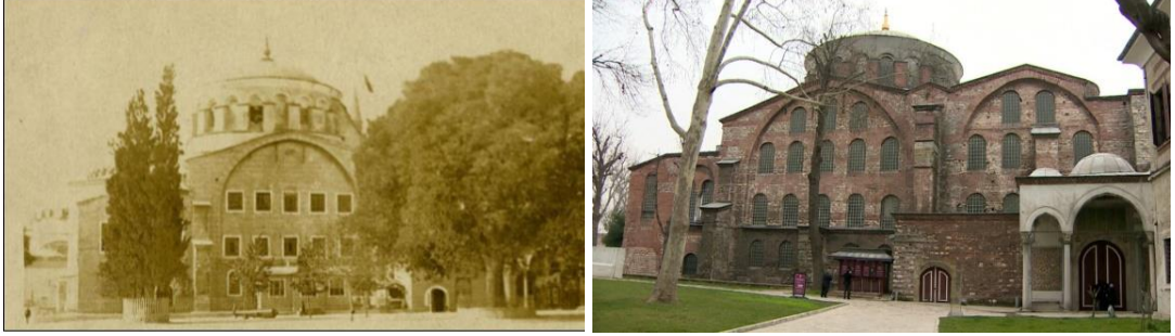
Görsel 14 Aya İrini Kilisesi kuzey cephe görünümü, 19. yüzyıl (solda) 42
