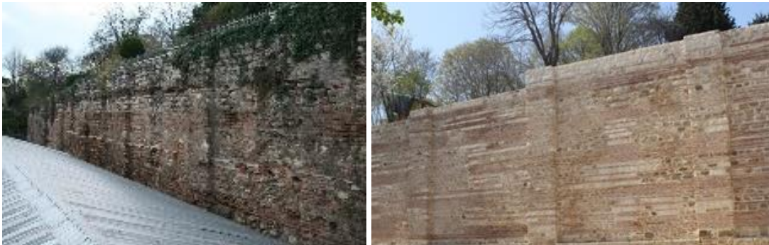
Görsel 138 Sur-i Sultani alanı Bizans dönemi İstinat duvarı uygulama öncesi (solda) restorasyon uygulama sonrası (sağda), 2016 (Öcal)
