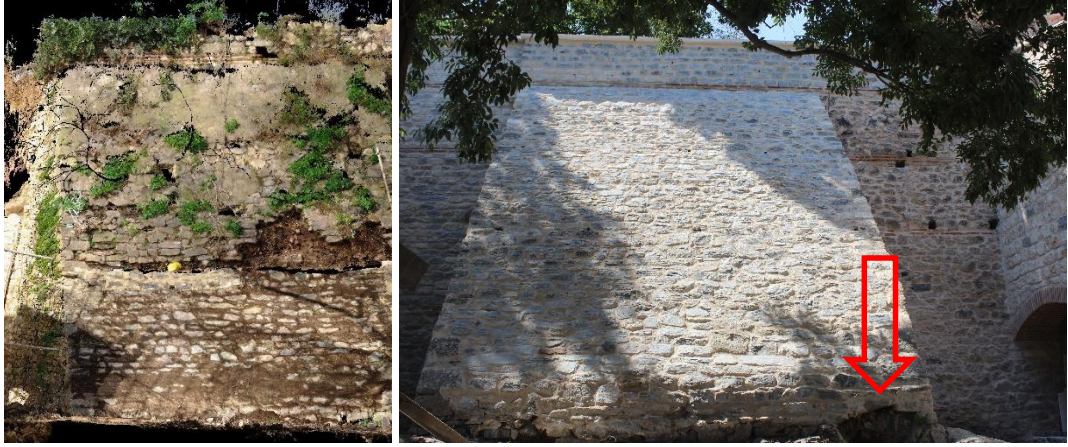
Görsel 166 İstinat duvarını destekleyen payanda restorasyon öncesi (solda), 2016, Görsel 167 Restorasyon sonrası (sağda), 2018 (Ok ile gösterilen kısımda alttaki kalıntının tonozlu girişi mevcut olup arkası kapalı olduğundan girilememiştir.) (Öcal)
