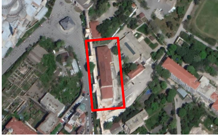
Görsel 186 Matbaa-i Amire Binasının Google Earth üzerinden konumu, 2017
