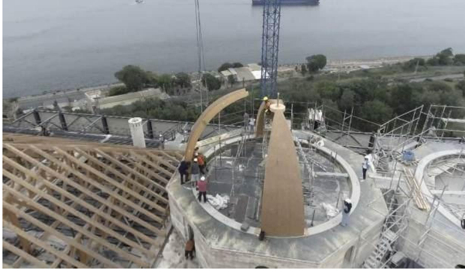
Görsel 45 Fatih Köşkü kubbelerinin rekonstrüksiyonu aşamasındaki fotoğrafı, 2021 97
