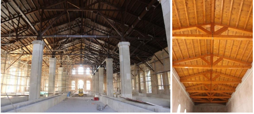
Görsel 139 Gülhane Depoları (3 nolu ve 2 nolu depolar) restorasyon ve rekonstrüksiyon uygulama fotoğrafı, 2016 (Öcal)
