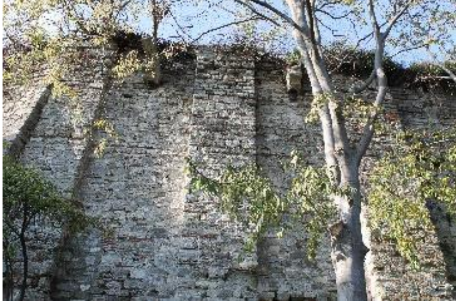
Görsel 200 Saray Mutfakları ve Hazine'ye dayanan Bizans dönemi payandalar ile desteklenen istinat duvarı, 2016 (Öcal)
