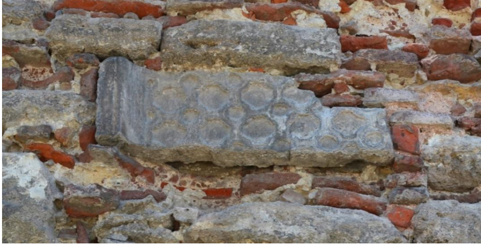
Görsel 206 Sahil Surları üzerinde Mangana Saray kapısına ait devşirme anıtsal malzeme 305
