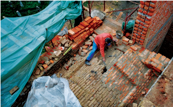
Fotoğraf 10- Hamamın tuğladan örülmüş tonozunun tamamlanması.
