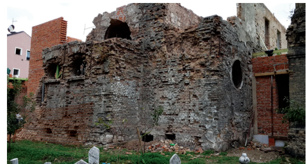
Fotoğraf 11- Hamamın duvarlarındaki örgü sistemi ve tuğla çürütme yapılması.
