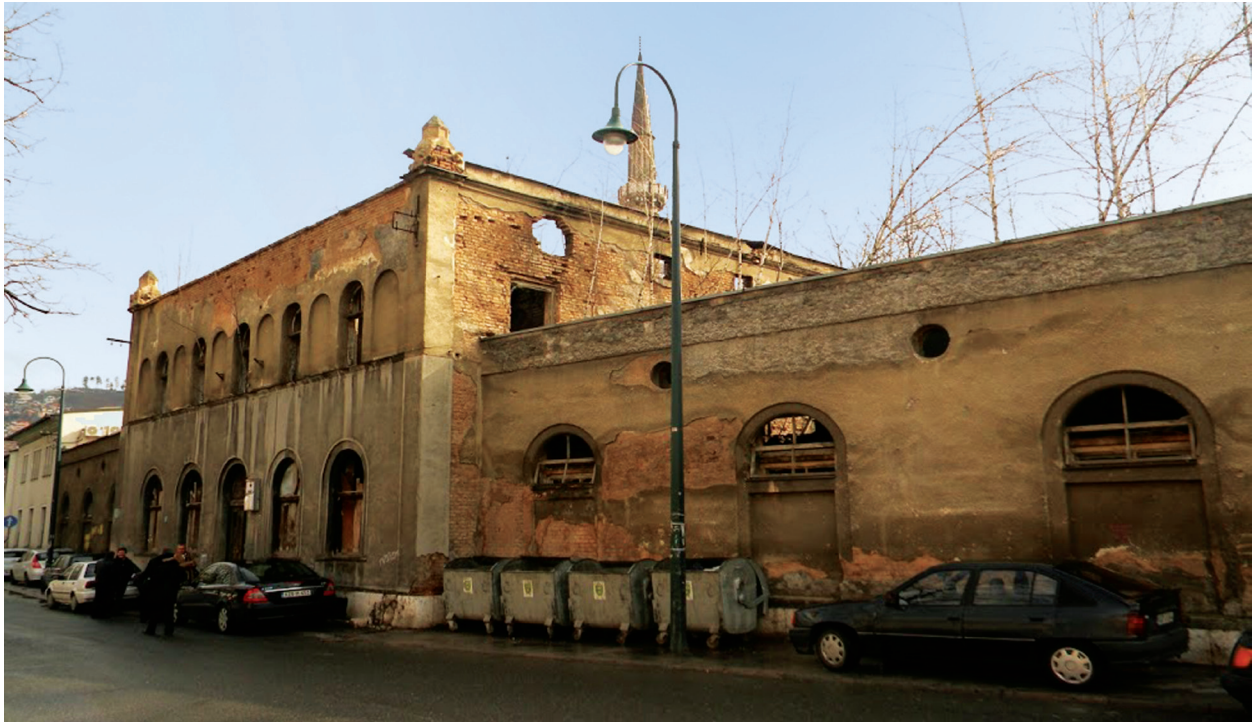
Fotoğraf 2- Restorasyona başlanmadan önce hamamın cepheden görünümü.
