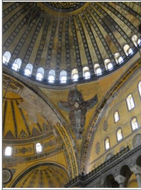
Şekil 3.27: Ayasofya İç Mekânında Pandantifin Görünümü (K: Ahunbay Z.)
