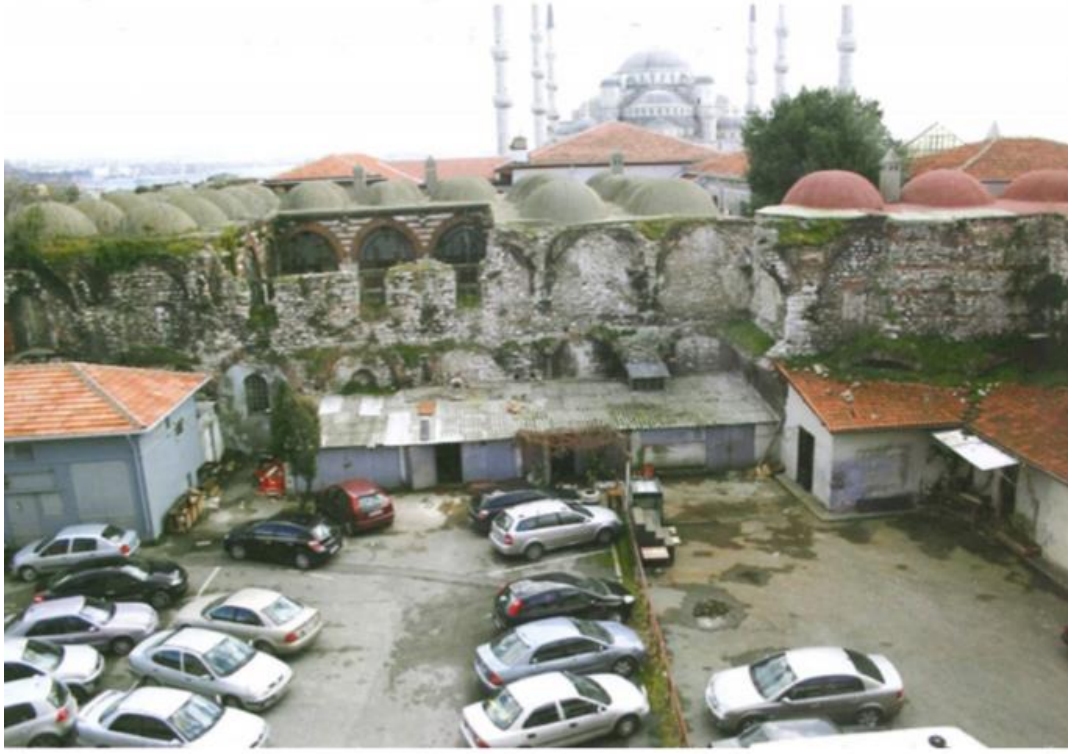
Şekil 3.16: Hapishane-i umumi kalıntıları (K: Atasoy N.)
