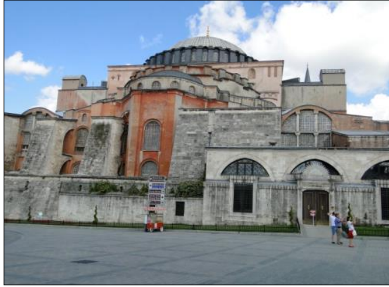
Şekil 3.28: Ayasofya'nın Doğu Cephesi (K: Ahunbay Z.)
