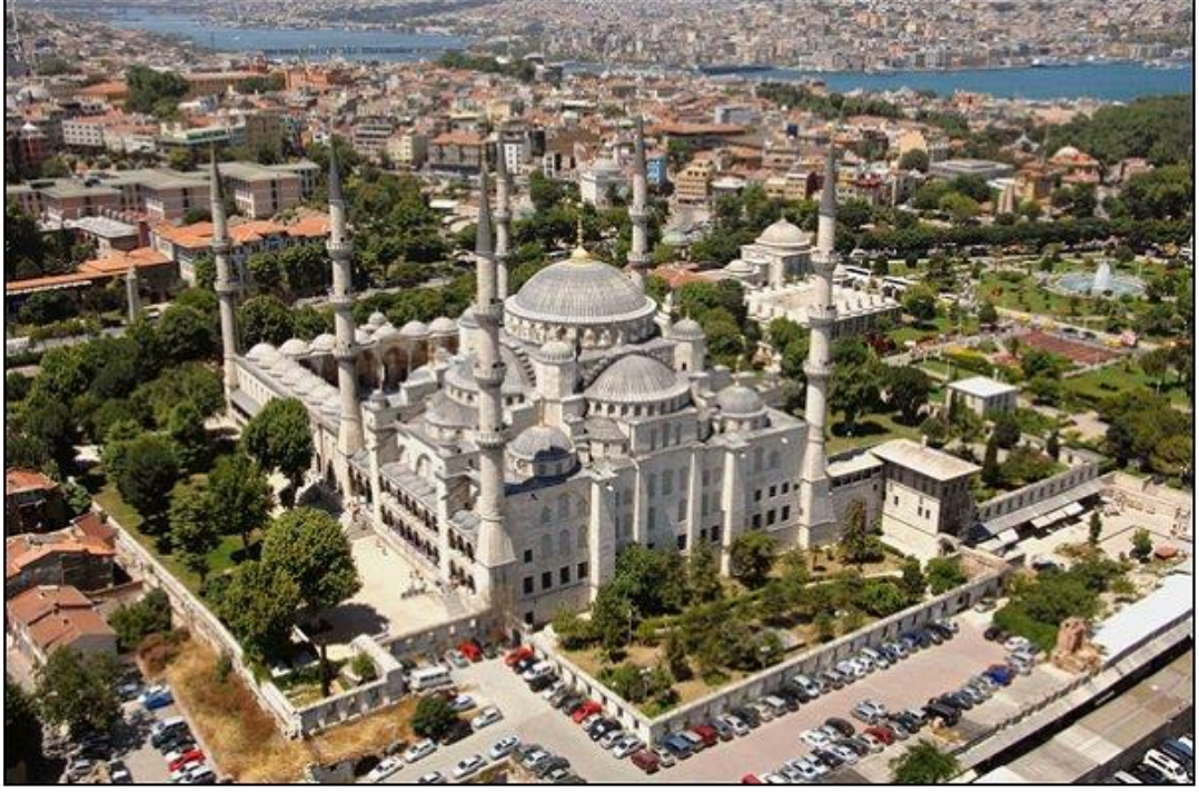
Şekil 3.2: Sultanahmet Camii güneybatı görünüşü (K: kvmgm.gov.tr)
