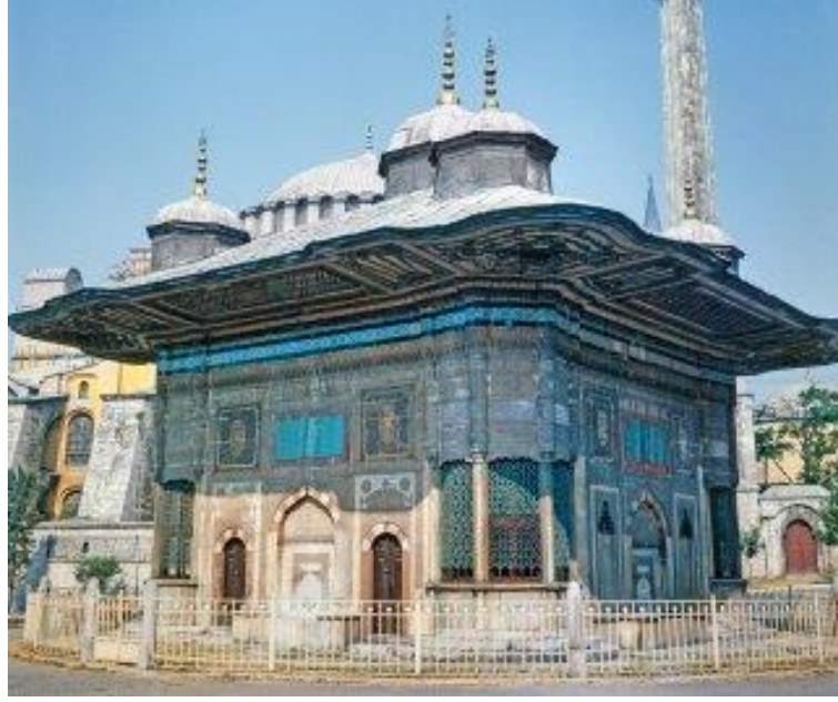
Şekil 1.14: Sultan III. Ahmed Çeşmesi (K: Url-4 )
