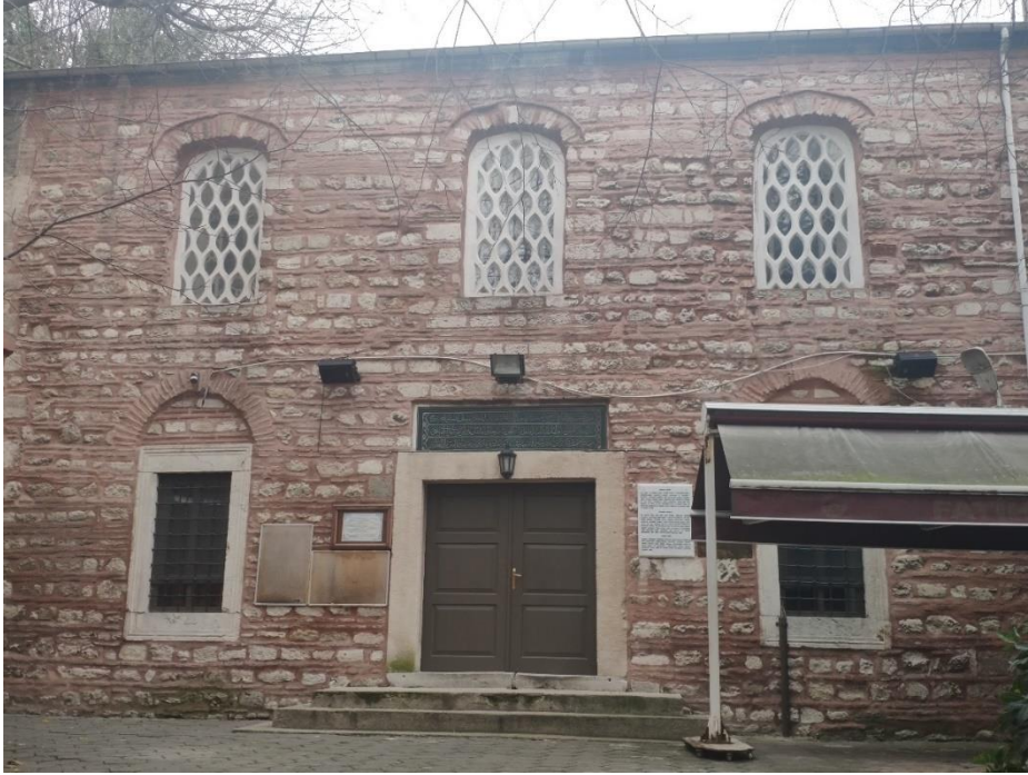
Ek 57: Kuzeybatı Cephesi Görünüş (S. Çakır,2020)
