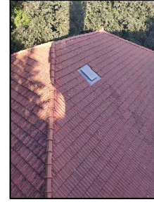
C. ÇATI ALATURKA KİREMIT OLARAK DEĞİŞTİRİLMİŞTİR VE AHŞAP ÇATI DETAYI ÇİZİLMİŞTİR.
