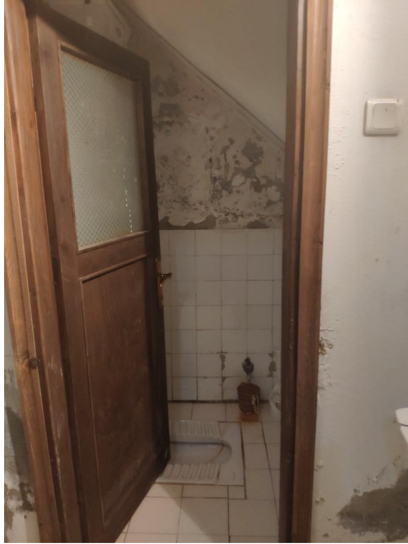
Şekil 4.11 B03 WC Görünüşü (S.Çakır,2020)
