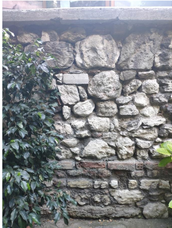
Şekil 3.64 Bahçe Duvarı(İç) Moloz Taş Görünüşü (S.Çakır,2020)
