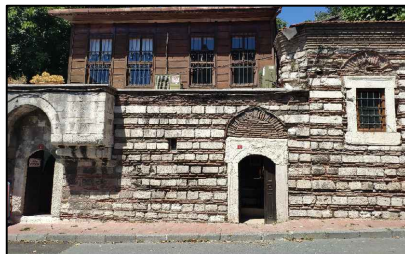
A. 101 SIBYAN MEKTEBİNİN 1.KATININ ÖN CEPHESİNE 3 TANE PENCERE AÇILMIŞTIR.
