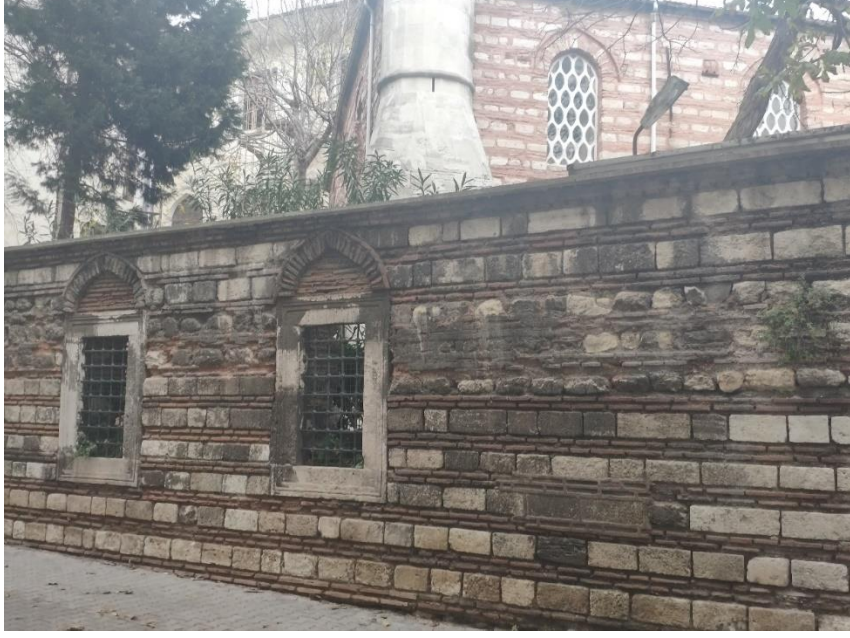
Ek 56: Kaptanı Derya İbrahim Paşa Sokak Bahçe Duvarı(S. Çakır,2020)
