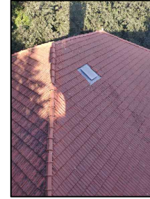
C. ÇATI ALATURKA KİREMIT OLARAK DEĞİŞTİRİLMİŞTİR VE AHŞAP ÇATI DETAYI ÇİZİLMİŞTİR.
