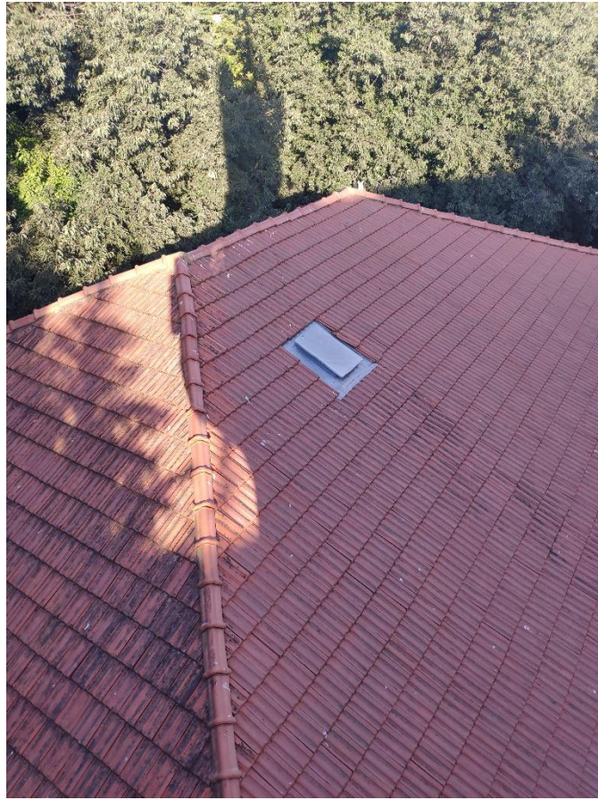
Şekil 3.69 Minareden Caminin Çatı Görünüşü (S.Çakır,2020)
