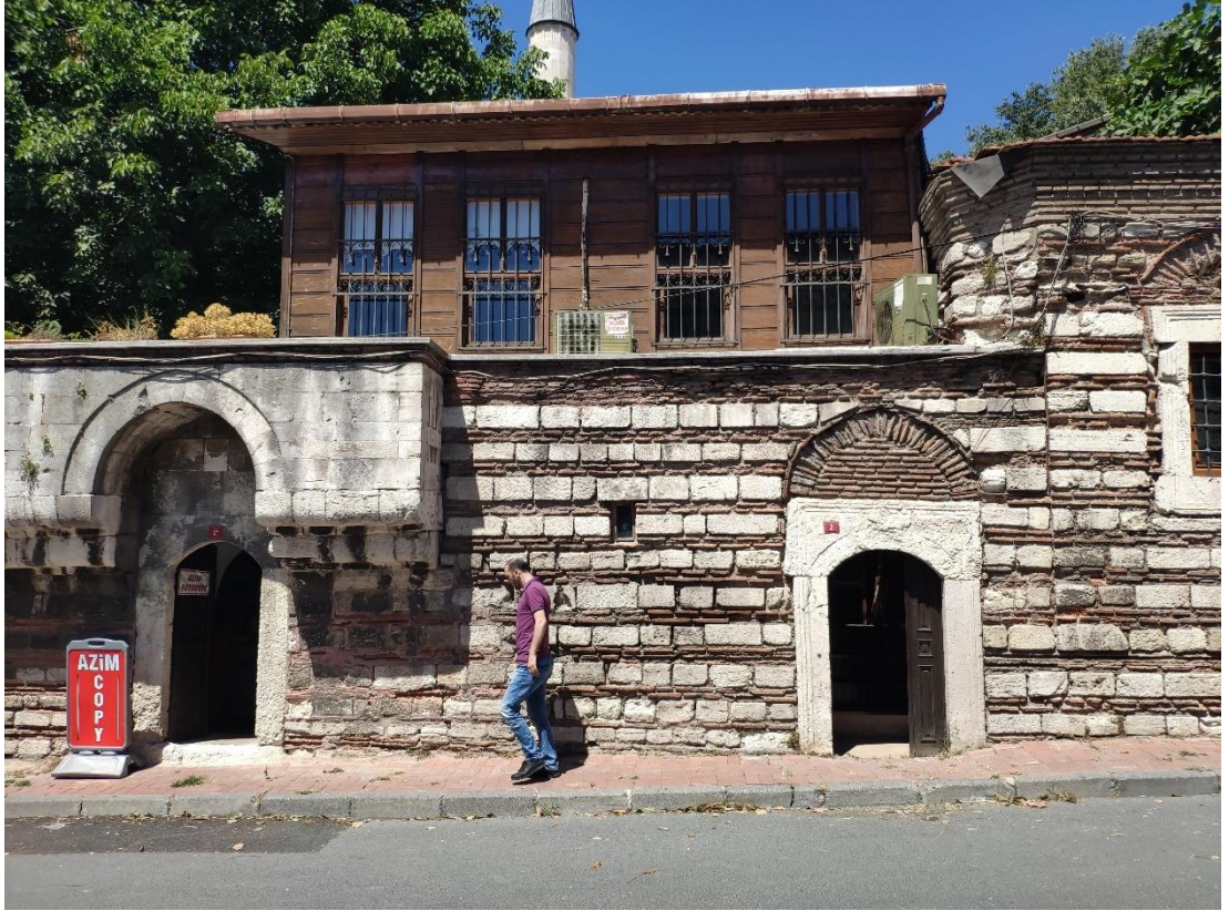
Şekil 3.65 Kafe Ahşap Yapı Görünüşü (S.Çakır,2020)
