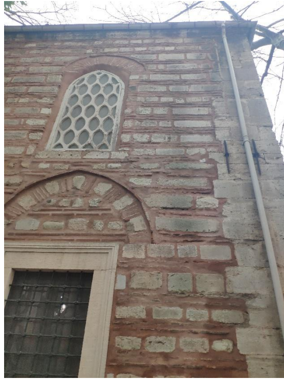
Şekil 3.48 Güneybatı Cephesi Pencere (S. Çakır, 2020)
