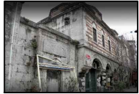
B. SIBYAN MEKTEBİ AHŞAP YAPISI İLE BİRLEŞTİRİLMİŞTİR VE İKİ KATLI OLARAK TASARLANMIŞTIR. (ANALOJİ- AMCAZADE KÜLLİYESİ SIBYAN MEKTEBİ)
