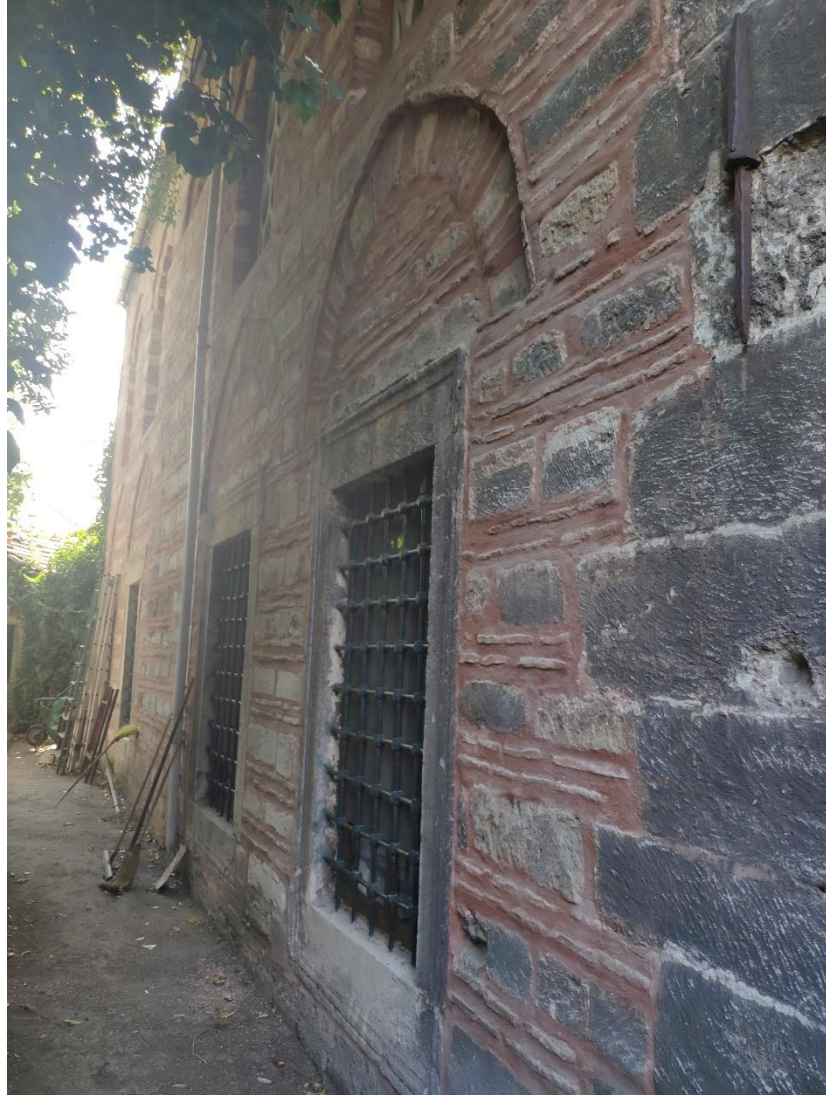
Şekil 3.43 Güneydoğu Cephesi Görünüşü (S. Çakır, 2020)
