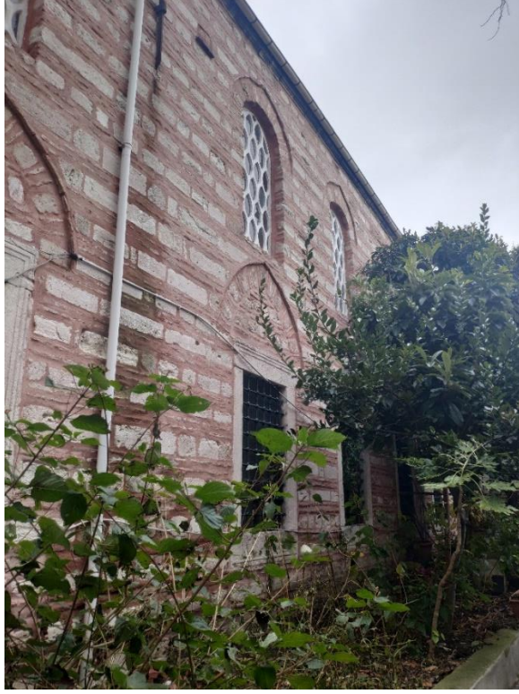
Şekil 3.50 Kuzeydoğu Cephesi Görünüşü (S. Çakır, 2020)
