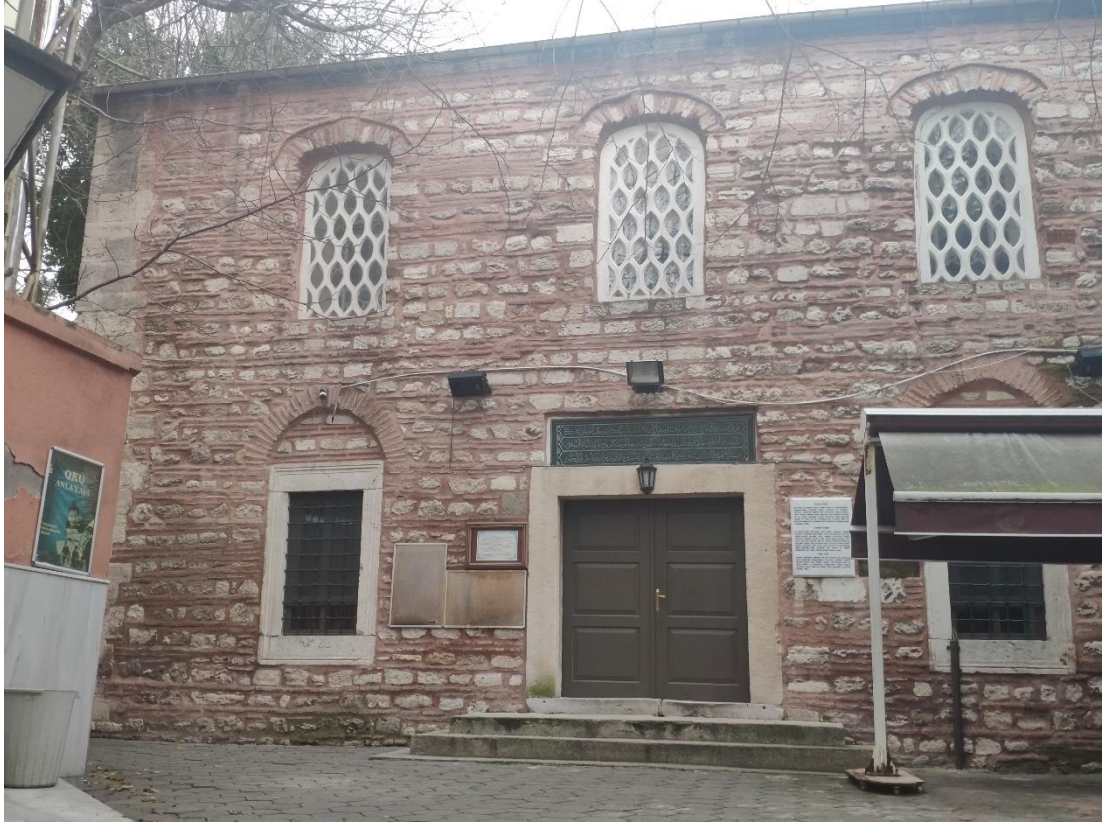
Şekil 3.53 Kuzeybatı Cephesi Görünüşü (S. Çakır, 2020)
