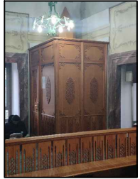
C. MÜEZZİN MAHFİLİNDE BULUNAN MUHDES AHŞAP PARAVAN KALDIRILMIŞTIR.
