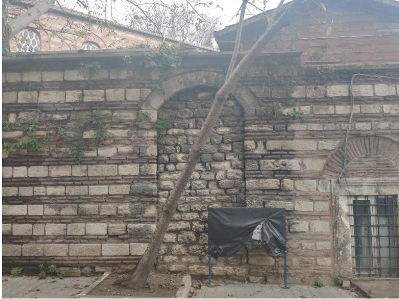
Ek 55: Kaptanı Derya İbrahim Paşa Sokak Dolgu Kapı(S. akır,2020)
