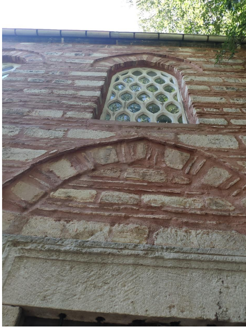
Şekil 3.44 Güneydoğu Cephesi Revzen (S. Çakır, 2020)
