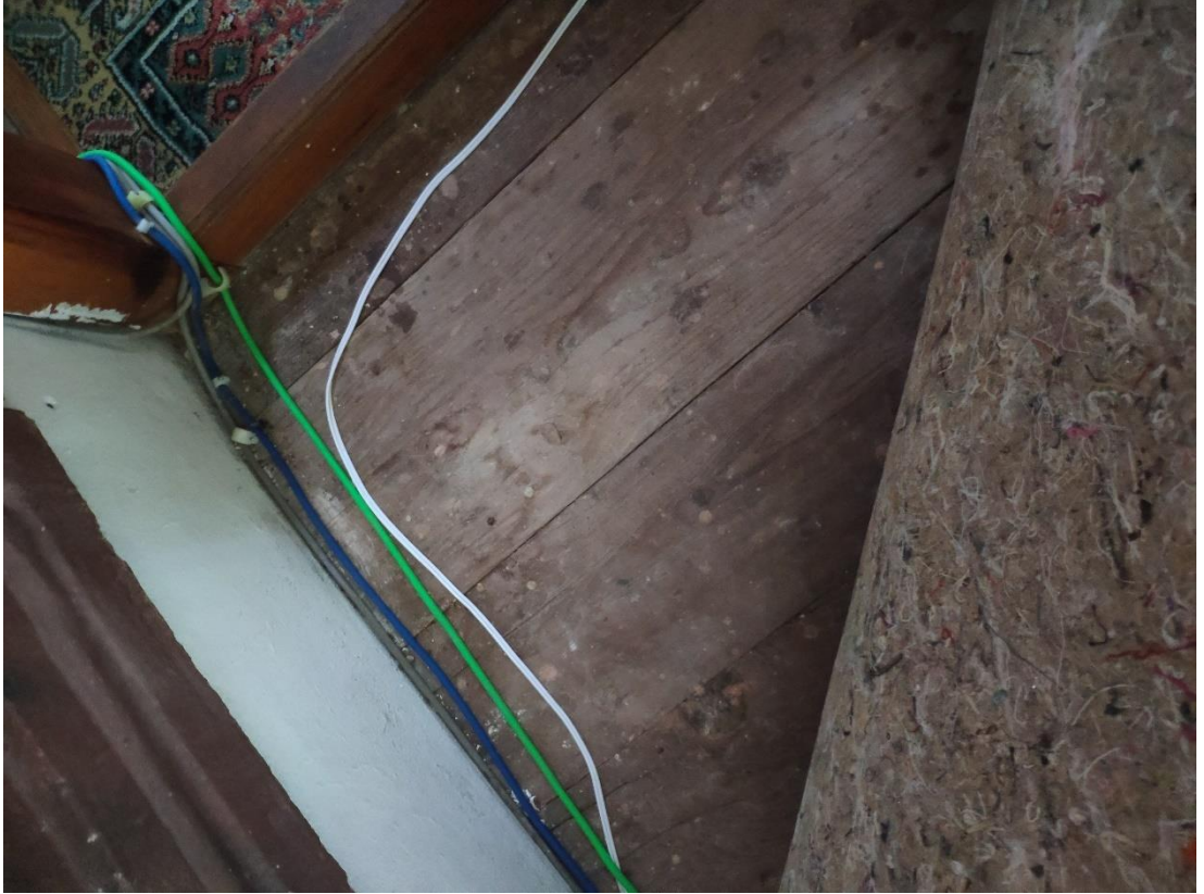
Şekil 3.66 Camii İçi Döşeme (S.Çakır,2020)
