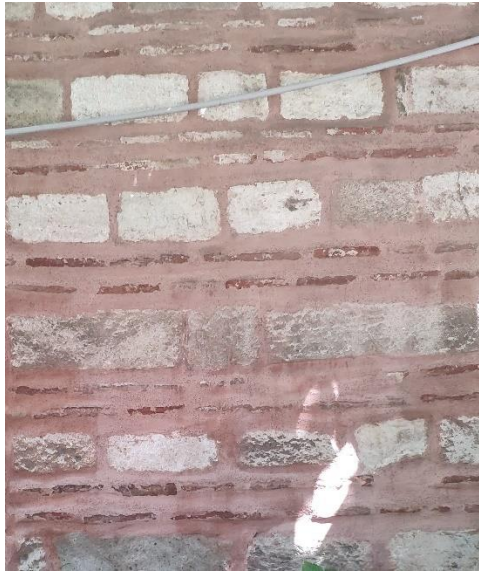
Şekil 3.62 Camii Kesme Taş-Tuğla Görünüşü (S.Çakır,2020)
