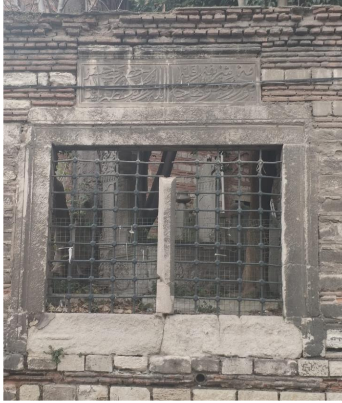
Şekil 3.6 Kaptan-ı Derya İbrahim Paşa Cami Hazire Duvarı Kitabesi (S.Çakır, 2020)
