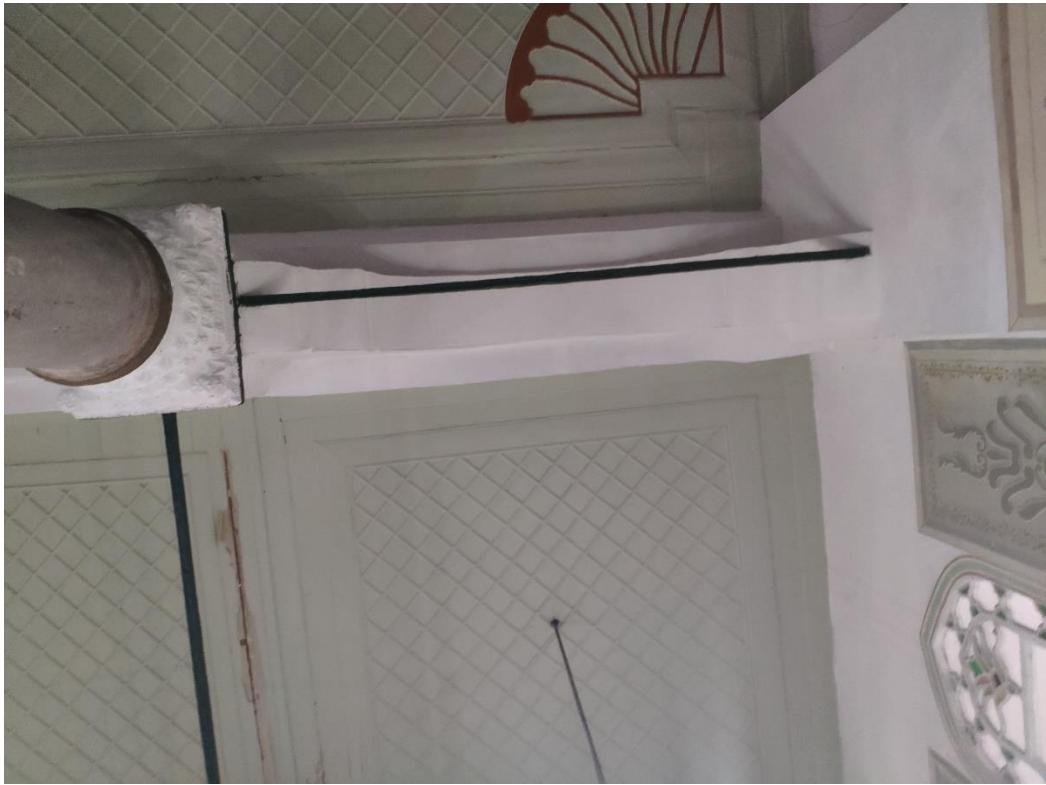
Şekil 3.23 Z02 Kadınlar Mahfili Demir Gergileri (S. Çakır, 2020)
