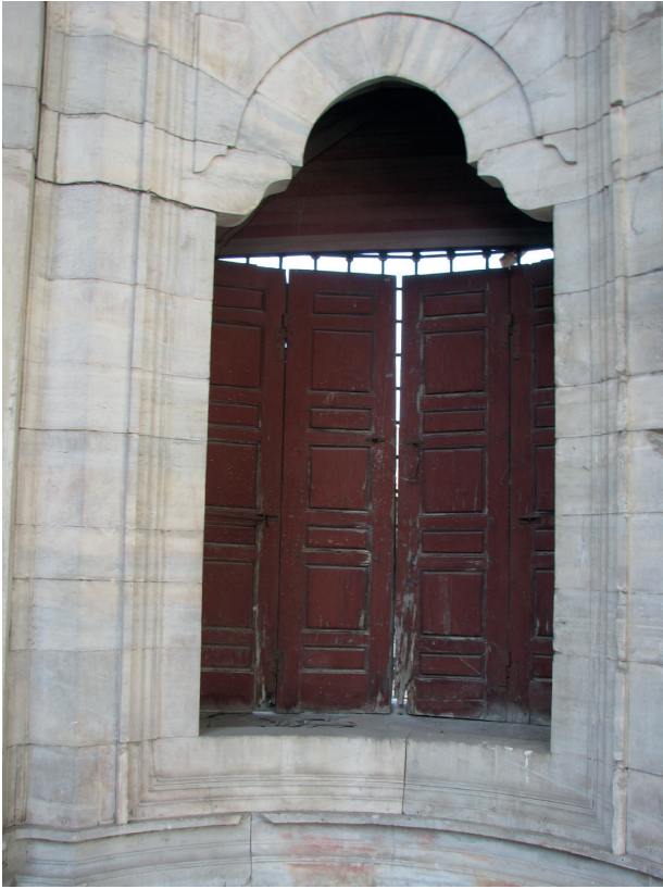
Fotoğraf 5. Avlu pencere kapaklarının genel görünüşleri ve biyolojik bozulmalar.
