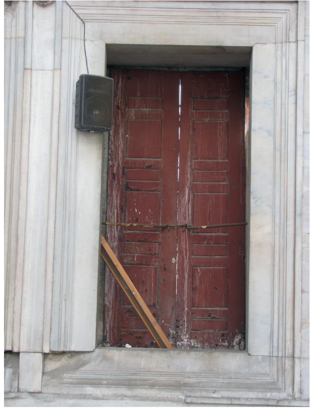
Fotoğraf 5. Avlu pencere kapaklarının genel görünüşleri ve biyolojik bozulmalar.
