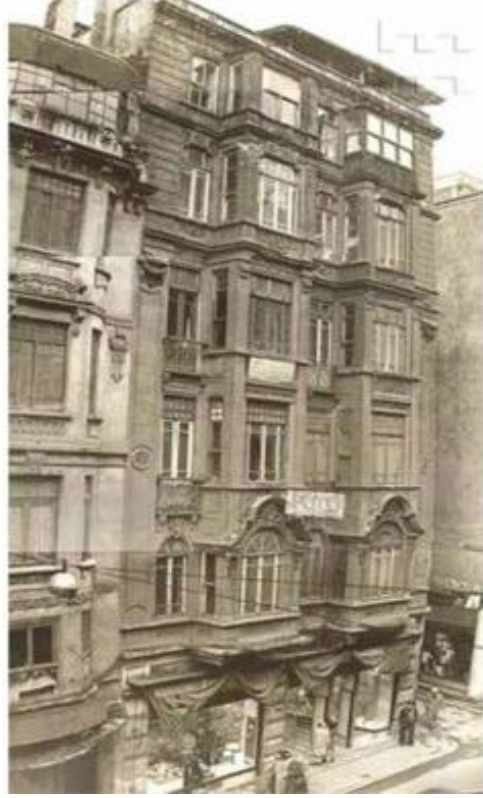
Şekil 4.7: Borusan Müzik Evi Facadism Uygulaması Öncesi (Url-23).
