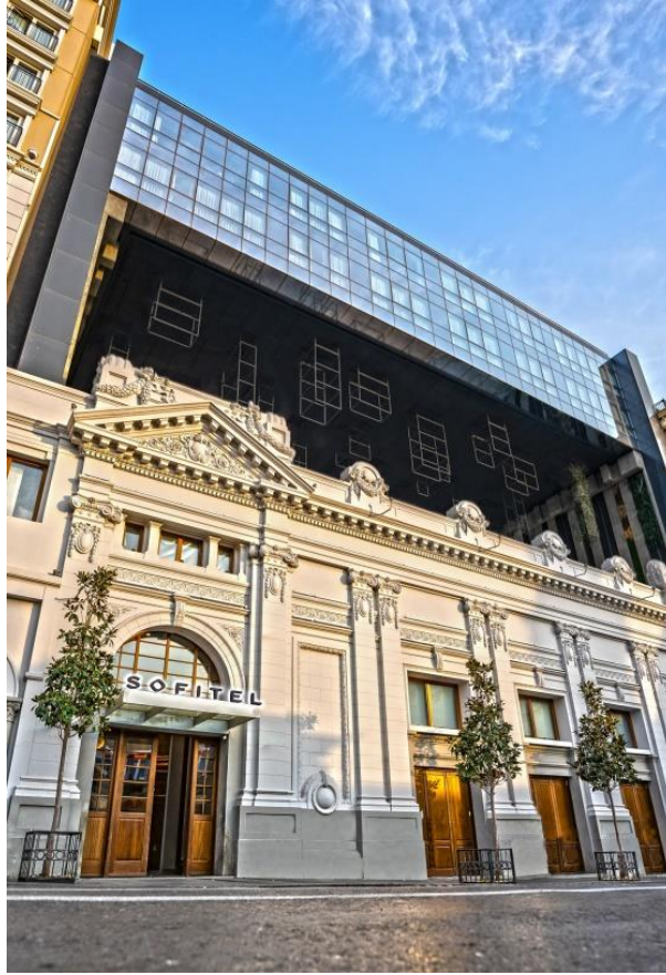
Şekil 4.1: Sofitel Ön Cephe (Url-20).
