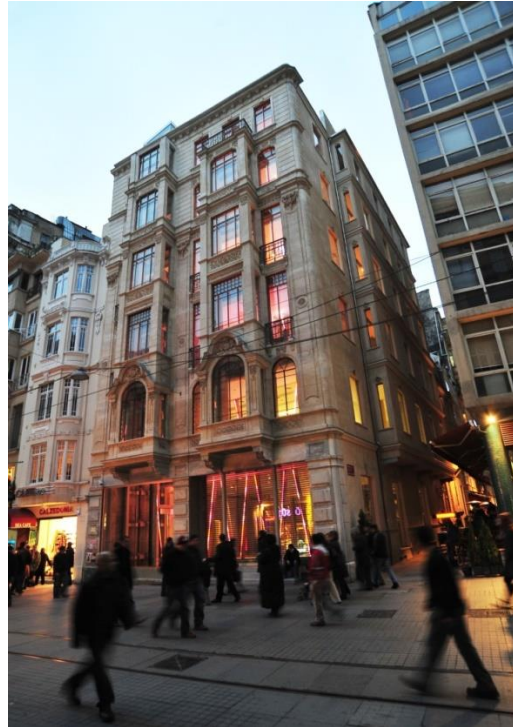
Şekil 4.8: Borusan Müzik Evi Facadism Uygulaması Sonrası (Url-23).
